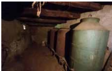
Detalle de la bodega.
