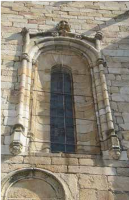
Detalle del ventanal.
