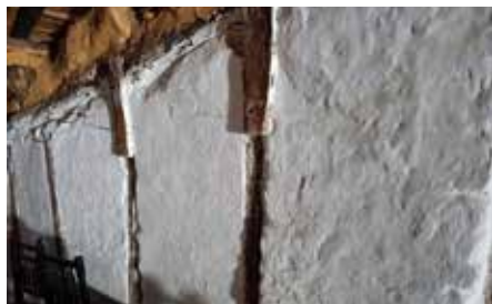
Detalle de los paramentos de una habitación del piso superior.
