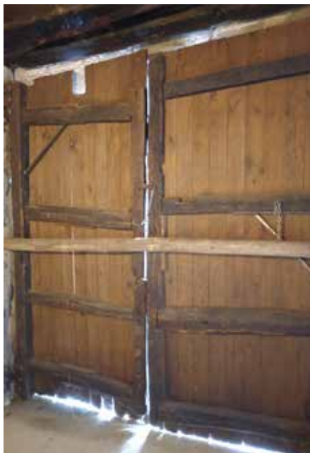
Detalle de la bodega.
