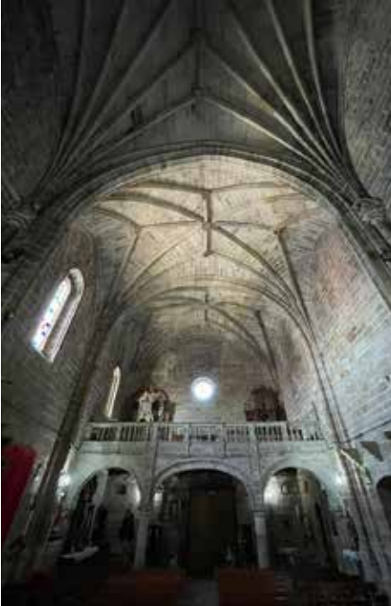
Detalle de las bóvedas.
