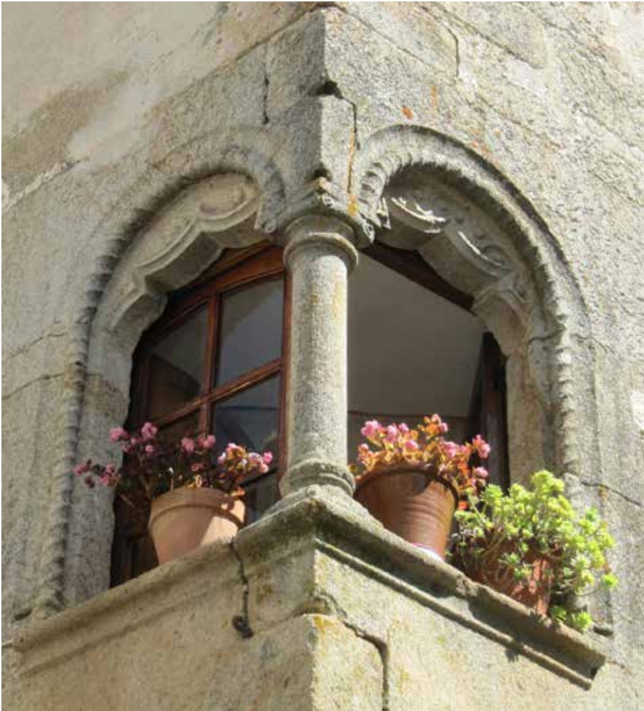
Ventana de esquina.
