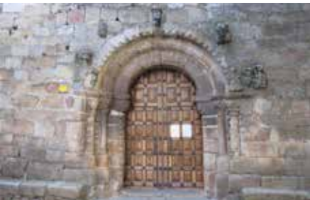
Portada, fachada occidental.
