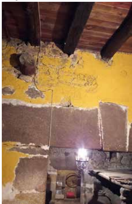
Detalle de la bodega.
