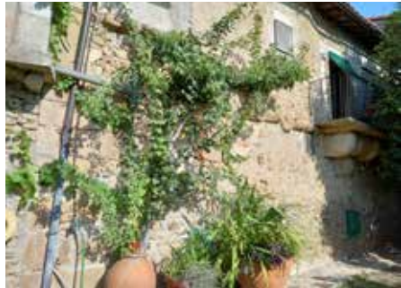
Detalle del patio.
