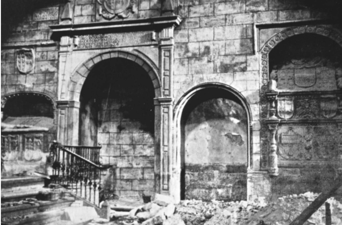
Fig. 2. Muro absidal de la epístola durante las obras de 1913. Fotografía del autor.
