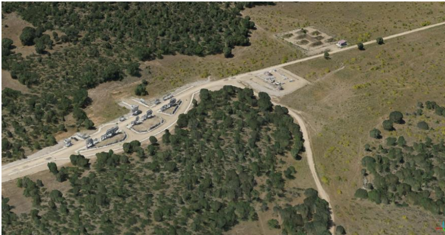
Figura 15. Zona de adiestramiento de "Casas de Uceda". Modelo 3D a partir de autocorrelación de imágenes de sensor fotográfico. Sistema RPAS Geodrone Mapper RTK del CEGET.
