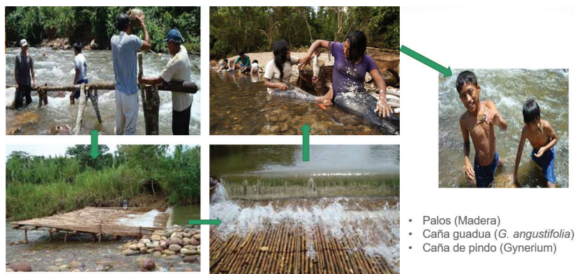
Figura 7. Elaboración del washim con caña guadua y pindos
