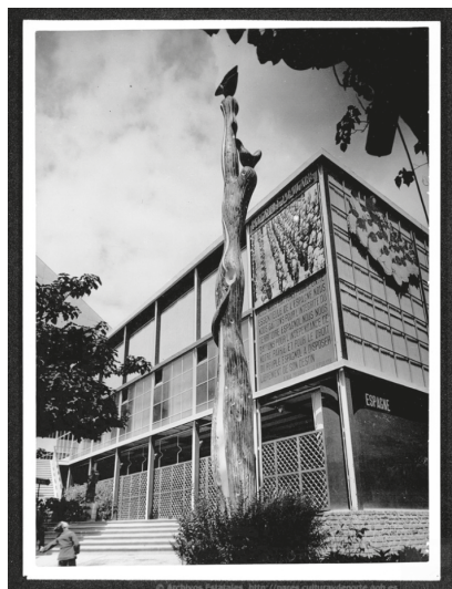
Fig. 5. Vista general del pabellón español. Fuente: Centro Documental de la Memoria Histórica, PS-Fotografías
