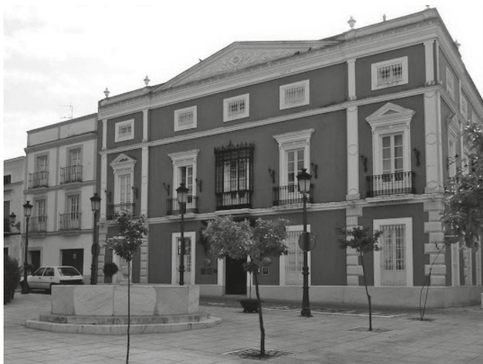
Fig. 3: Casa palacio de los Condes de la Corte
