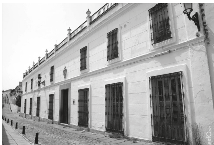
Fig. 4: Casa palacio de los Marqueses de Encinares en la calle Tetuan.
