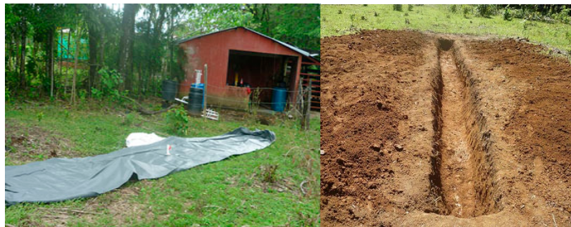
Figura 8. Aducción cercado y excavacion para Geomembrana para biodigestor parque Metropolitano María Lucia
