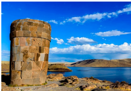
Figura 4. Chullpa de Sillustani, Paucarcolla Puno, Perú. Estructuras funerarias Collas, ubicado en la meseta del Altiplano a una altura de 3840 m.s.n.m., llegan a tener 12 metros de altura y el diámetro que posee en la parte superior es mayor que el de la base, todo un reto a las leyes de la gravedad y al equilibrio. Pruebas con el carbono 14 indican que datan del siglo XIV al XVI d.C.
