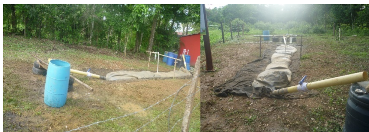
Figura 11 Preparacion , mezcla del material medicion de PH y Temperatura en el proceso de carga del biodigestor
