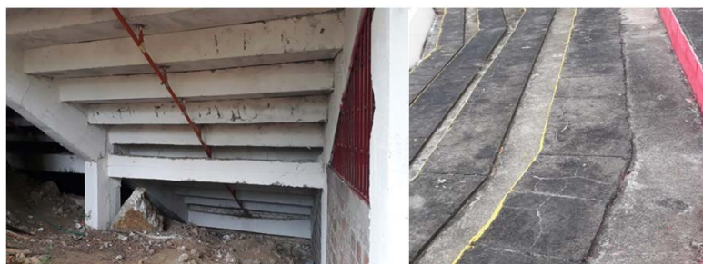
Figura 3. Estado actual de la estructura (graderías)
