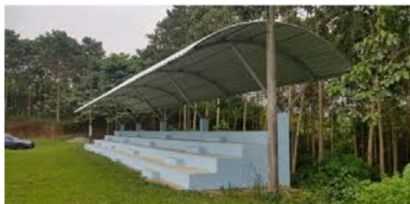
Figura 20. Cubierta liviana con estructura metálica
