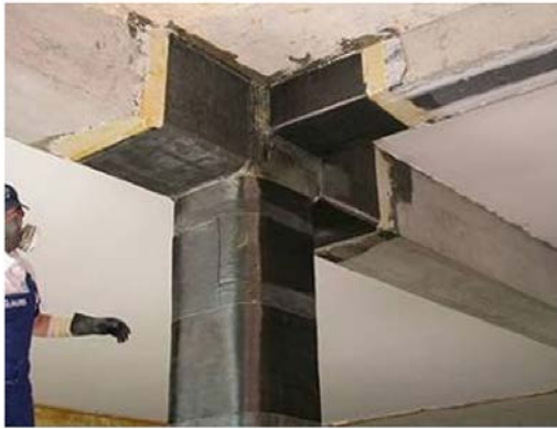
Figura 18. Sistema RFP (manto fibra carbono)
