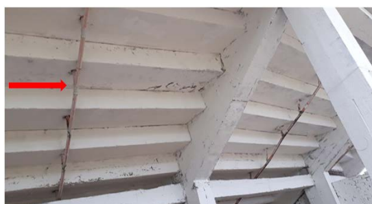
Figura 8. Instalación de sistema de evacuación de aguas lluvias
