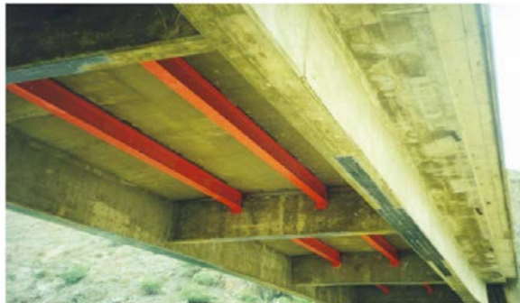
Figura 19. Reforzamiento con adición de perfiles
