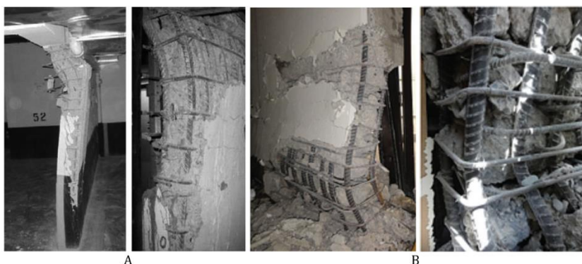
Figura 2. Fallas fuera del plano - A) sismo Chile, B) Sismo nueva Zelanda
