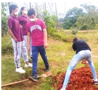
Figura 6. Preparación del terreno
