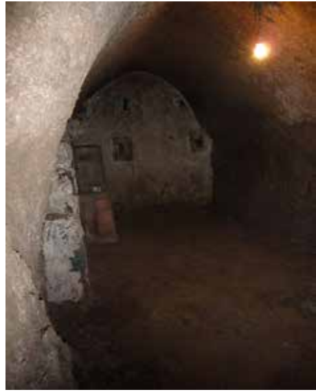
Imagen interior de uno de los dos caños del calado 2 excavado en roca, con forma abovedada excavada en el terreno como los hastiales. No posee sostenimiento de refuerzo por la geometría abovedada.
