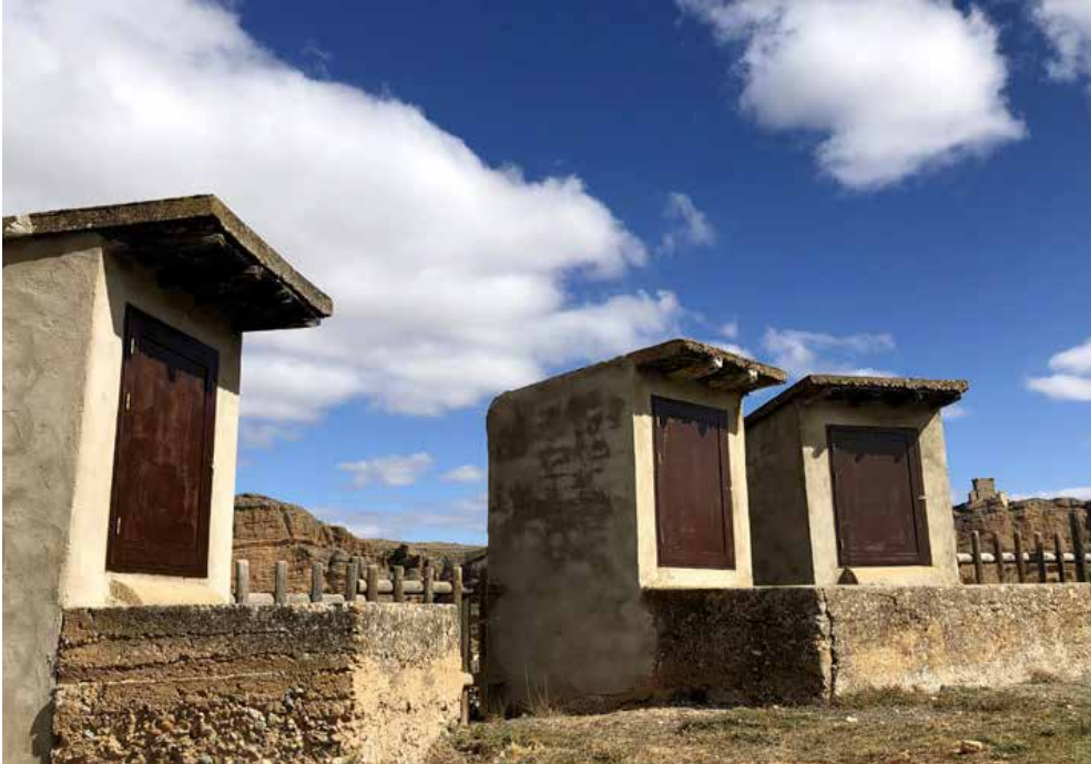
Las luceras donde se recepcionaba la uva y caía por gravedad al lagar de cada calado.
