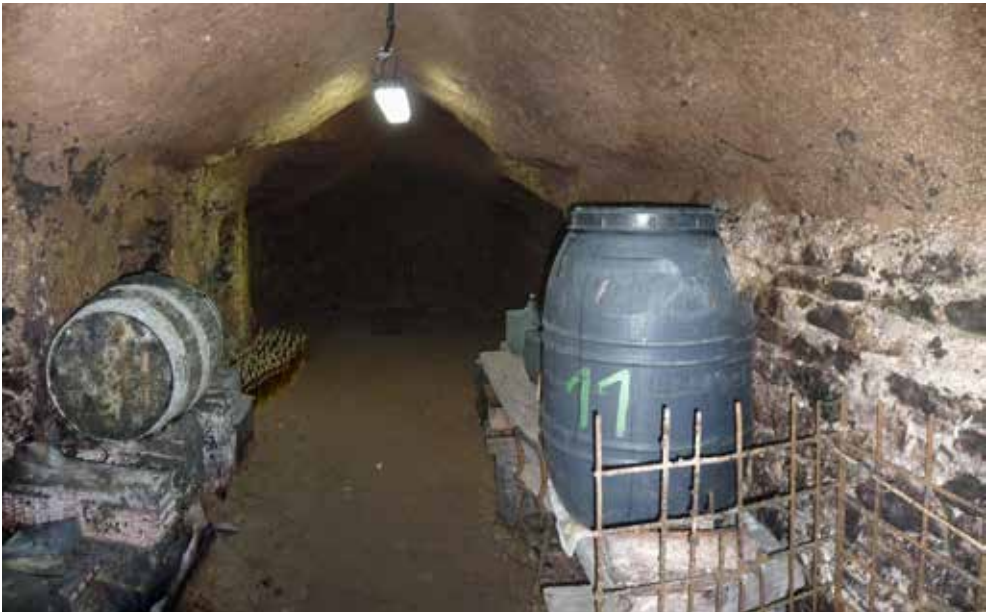
Imagen interior del calado 1 excavado en roca, con forma de bóveda apuntada sobre muros de piedra en los hastiales. No posee sostenimiento de refuerzo por la geometría del mismo.
