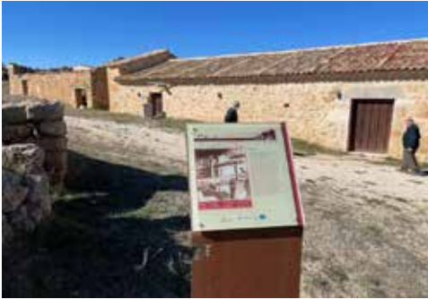
Fig. 5. Una vista exterior del lagar recientemente recuperado.
