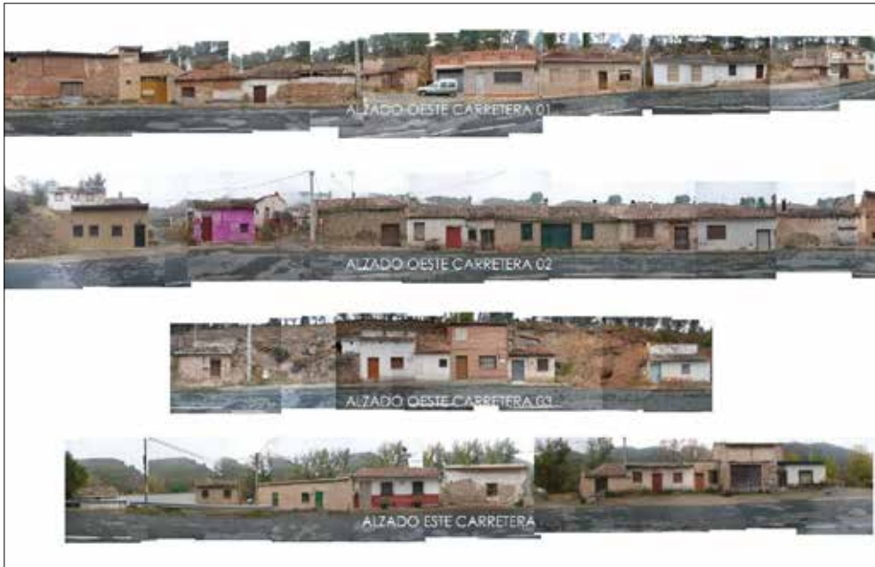
Alzados a ambos lados de la carretera del barrio de bodegas de Lagunilla del Jubera.
