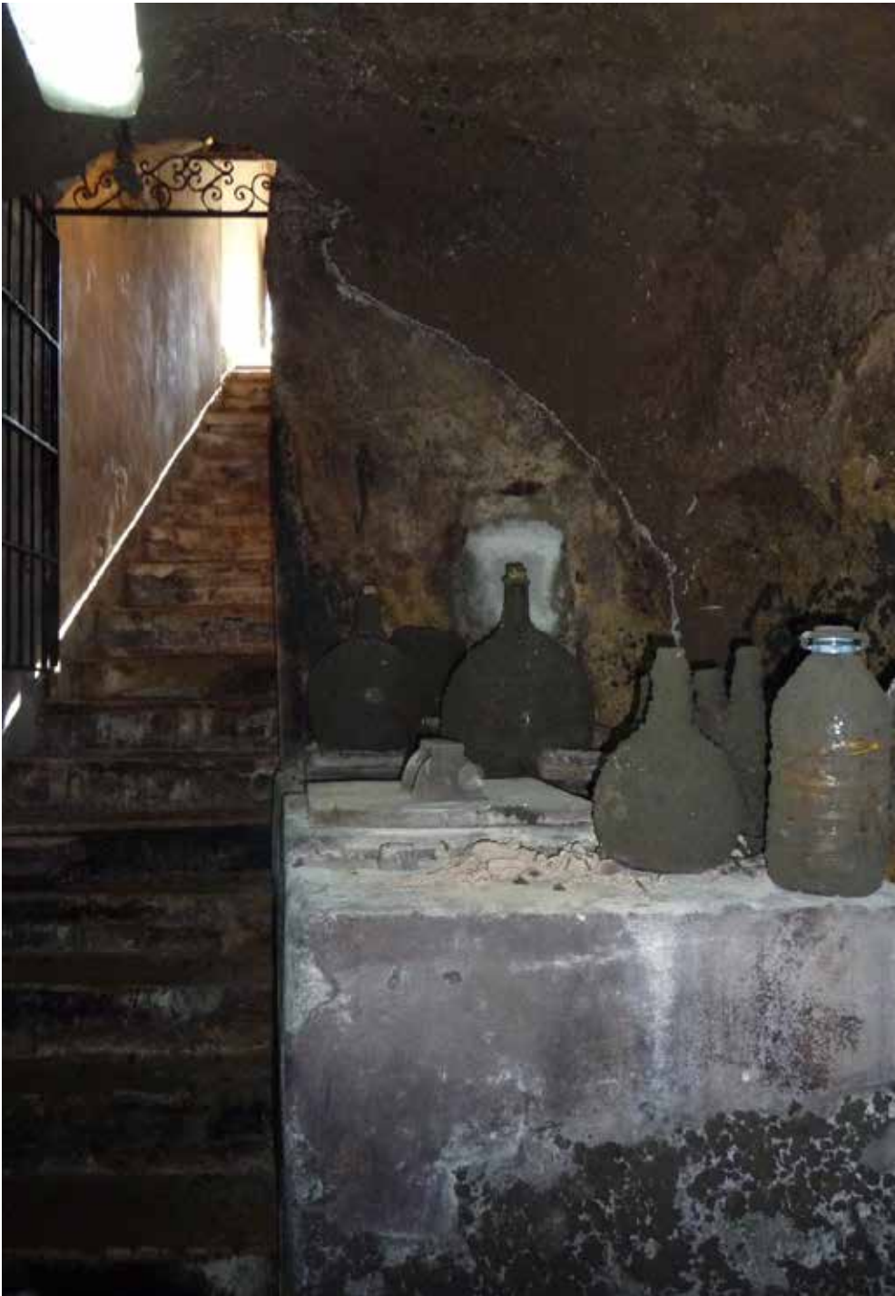
Imagen interior del calado 1 excavado en roca, con la escalera de acceso y sección del terreno.
