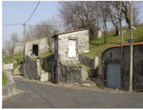
Rue du Thieu; bodegas rematadas con «tonnes».
