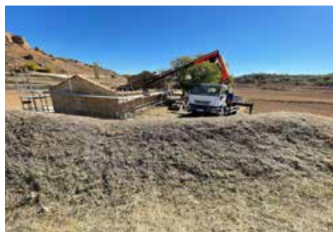
Fig. 11. Obras de recuperación de edificios en todo el BIC. (Fotografías T. Herrero).
