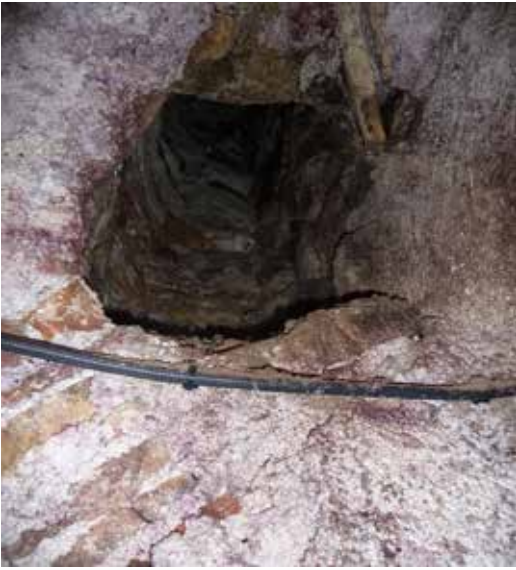
Vista interior desde el calado 2 de la tufera reforzada con piedra.
