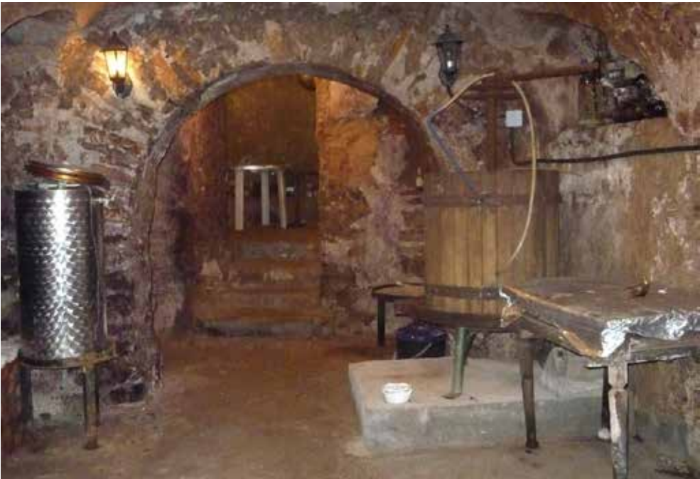
Imagen interior de uno de los dos caños del calado 2 excavado en roca, con forma de bóveda sobre muros de piedra en los hastiales. Sí posee sostenimiento de refuerzo por medio de arcos. Posee sostenimiento porque la luz (la anchura del calado) es más ancha de la que puede soportar el mismo terreno.
