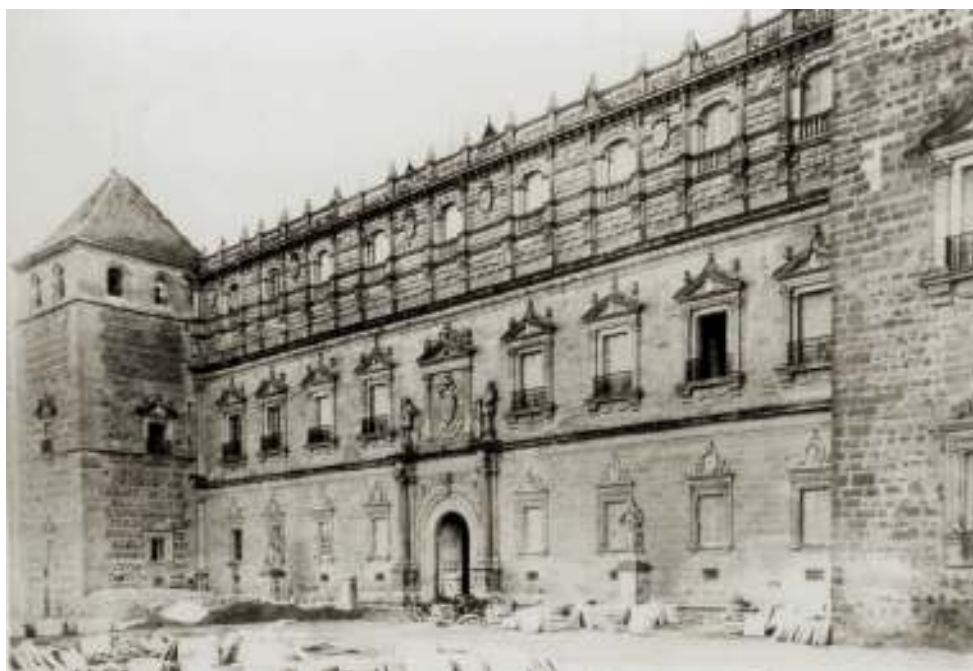
El Alcázar en obras
