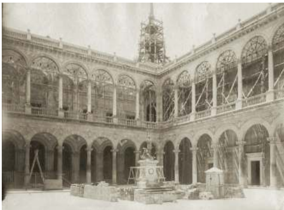
El patio en obras tras el incendio
