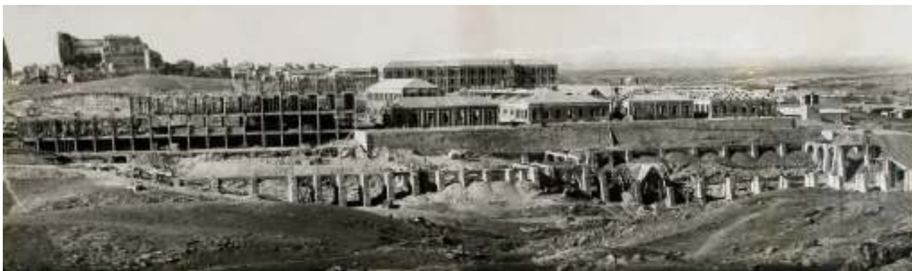
Panorámica de las obras, con las ruinas del Alcázar al fondo
