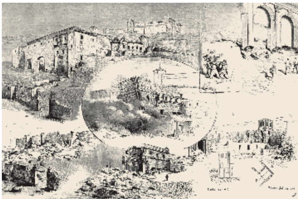
Voladura del Hospital de Santiago
