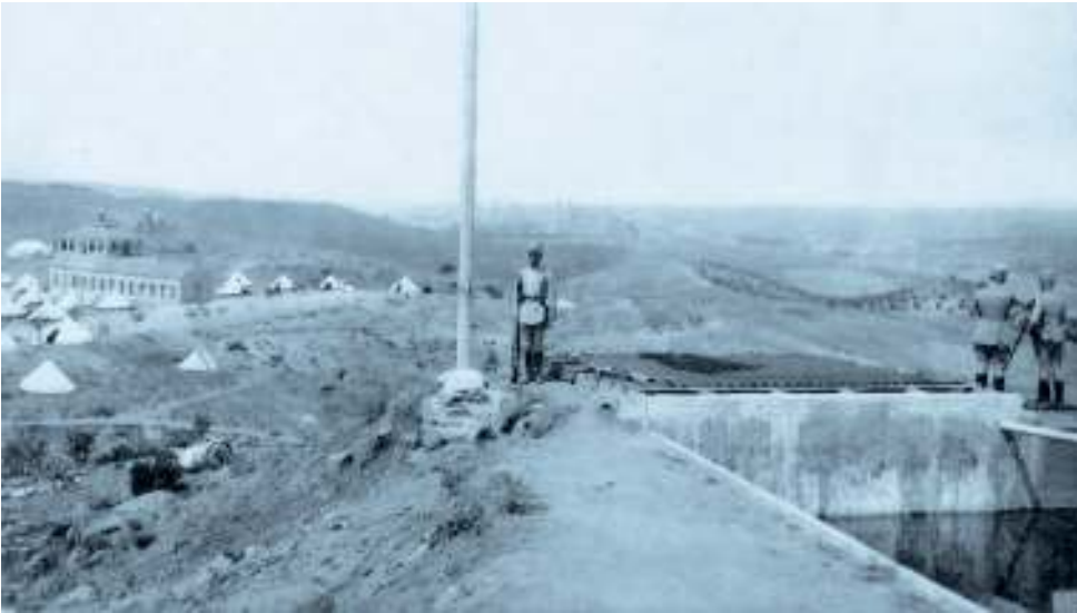
Depósito de agua y centinela del reducto
