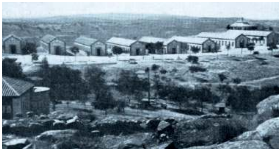
Vista del campamento de Los Alijares en 1916
