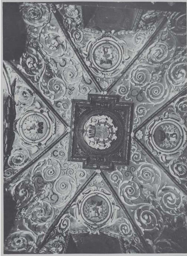
Fig. 8. Bóveda de la antecapilla de San Isidro. Biblioteca Regional Joaquín Leguina, Fondo Moya Idigoras.
