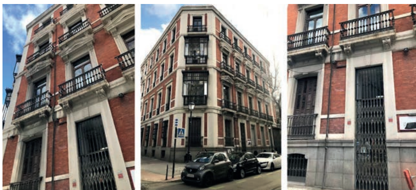
Tres vistas actuales del noble edificio del número 2 de la calle de Manuel Silvela, en pleno centro de Madrid, en cuyo bajo se ubicaba la Galería Círculo 2; en ellas se ve la puerta de entrada al local, hoy vacío y sin actividad. L.M. MARTÍN VELASCO.
