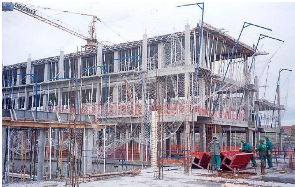
Fig. 16: Obras de estructura del instituto, finales de 2001. Fot. CONEX.
