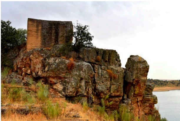
Fig. 15. Estructuras defensivas de la Guerra Civil, zona de las tropas franquistas. Esther Núñez
