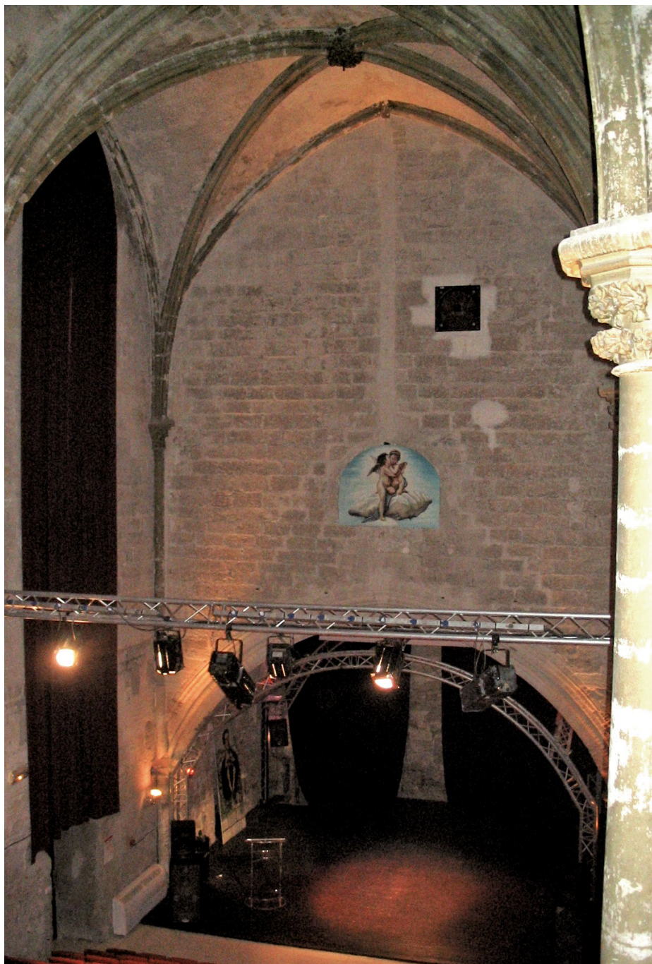
Figura 3. Aviñón, capilla de Saint-Jean: tribuna construida en el primer tramo bajo el mando de Guillaume de Reillanne (1336-1352). (Foto: D. Carraz).
