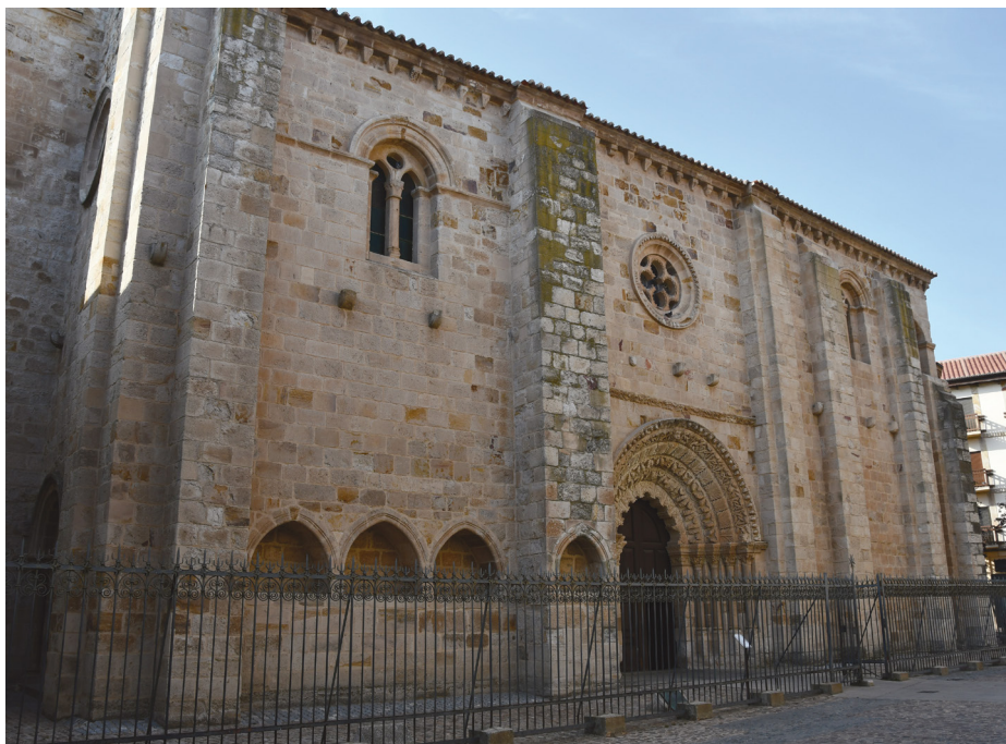
Figura 2. La Magdalena de Zamora, fachada meridional. (Foto del autor).
