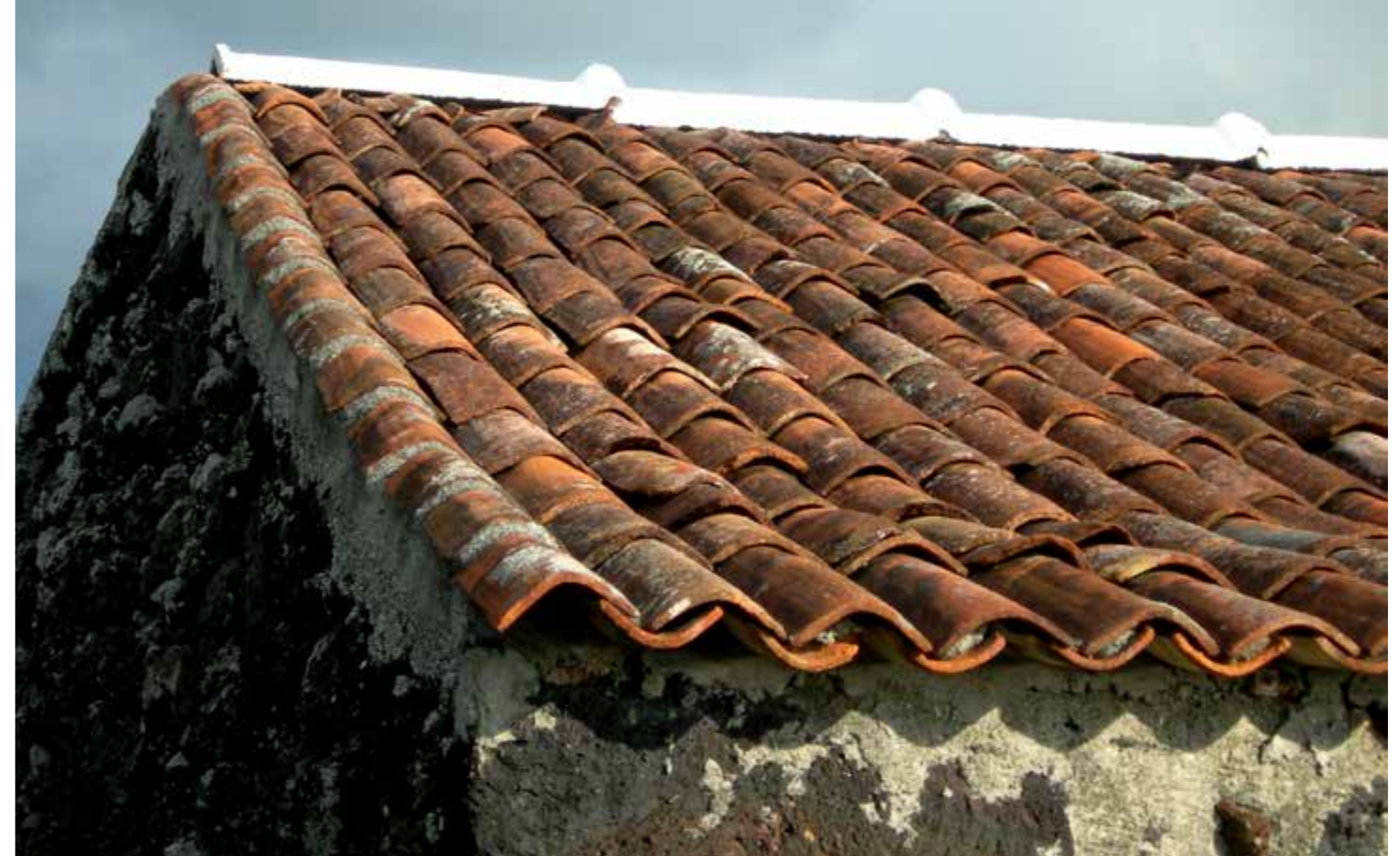
Detail of the roof of a traditional building: ceramic tile made of clay from the islands of Graciosa or Santa Maria in Fogos, parish of Candelária | Pormenor da cobertura de um edifício tradicional: telha cerâmica de canudo de barro das ilhas Graciosa ou de Santa Maria em Fogos, freguesia da Candelária | Detalle de la cubierta de un edificio tradicional de teja cerámica de barro procedente de las islas de Graciosa o Santa María en Fogos, pedanía de Candelária
