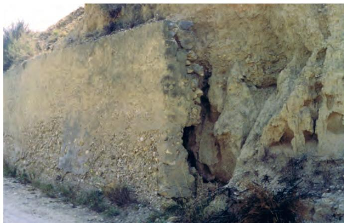
Fig. 12. Horma de tapial. Su cara interna, en contacto con las margas de la ladera se encuentra muy afectada por la erosión (foto del autor, 1994).
