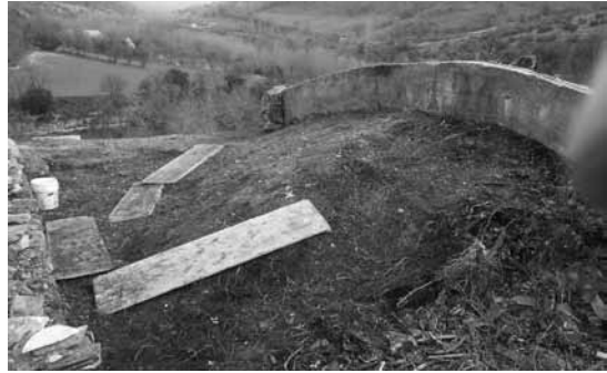
Vista de la viga de hormigón existente sobre la bóveda
