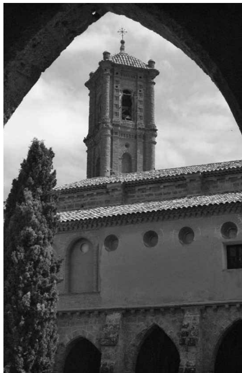
Fig. 6. Torre y claustro del monasterio de Piedra, Zaragoza.
