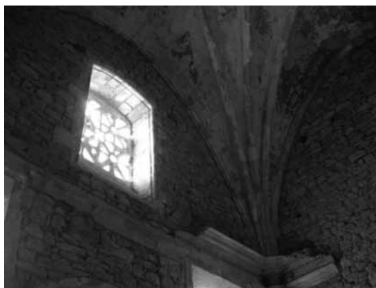
Fig. 13. Ventana y arranque de la bóveda de la sala capitular
