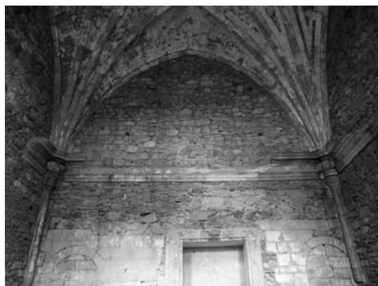
Vista del interior de la sala capitular
