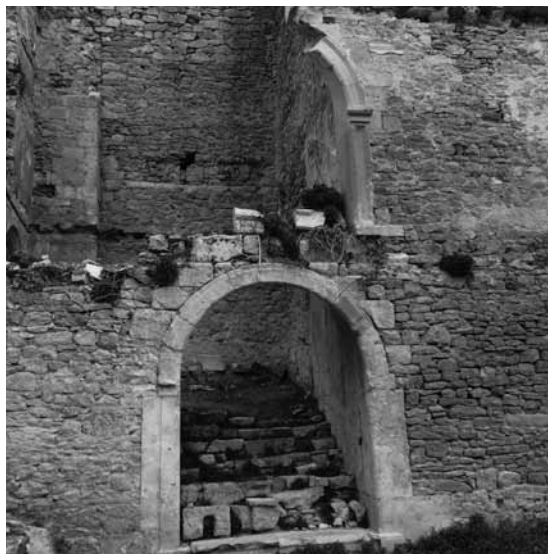
Fig. 22. Restos de la ubicación de la escalera principal
