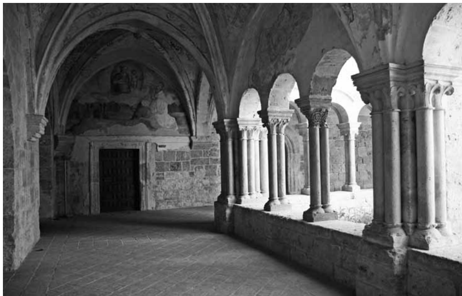
Fig. 7. Claustro medieval con pinturas renacentistas en Valbuena, Valladolid (foto: Santiago Sobrino).
