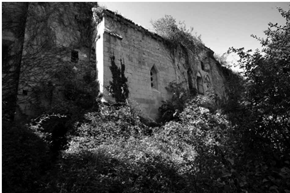
Vista del acceso al monasterio antes de iniciar su recuperación
