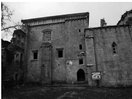
Vista de la fachada sur con la nueva cubierta de la sala capitular
