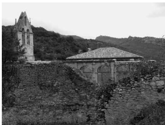
Vista de la nueva cubierta desde la ladera norte, a la altura superior del claustro
