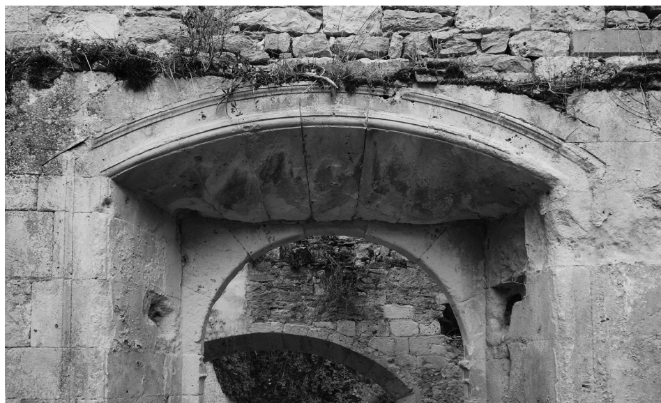
Imagen 11. Capialzado (aparejo de intradós alabeado que enlaza un dintel y un arco rebajado).
