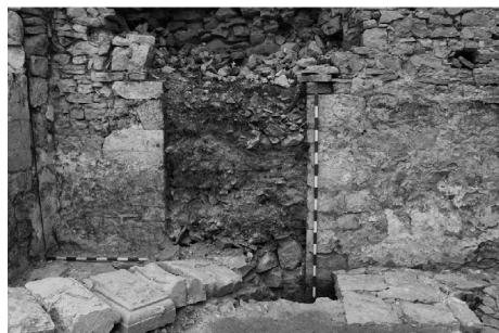
Imagen14. Imagen izquierda: indicios del vano documentado en el muro este del refectorio, cuyo umbral se encuentra a 50 cm por debajo del suelo. Imagen derecha: el mismo vano, esta vez con arco conservado, visto desde el claustro de la hospedería.
