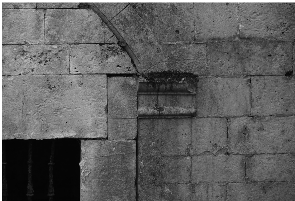
Imagen 10. Sillar mordido por la última dovela del arco.
