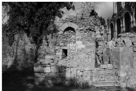
Imagen14. Imagen izquierda: indicios del vano documentado en el muro este del refectorio, cuyo umbral se encuentra a 50 cm por debajo del suelo. Imagen derecha: el mismo vano, esta vez con arco conservado, visto desde el claustro de la hospedería.
