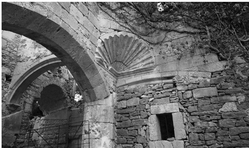
Imagen 8. Trompa sosteniendo un pequeño vuelo.
