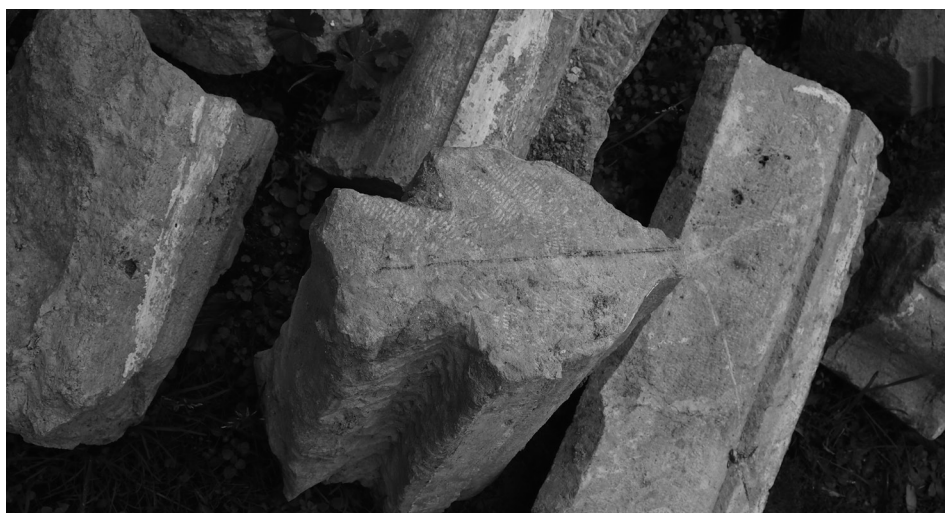
Imagen 1. Dovelas de nervios de una bóveda de crucería, conservando la marca del eje empleado para situar la plantilla de su perfil.
