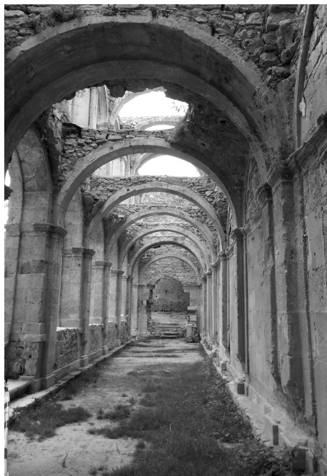
Imagen 18. Rioseco. Detalle de la cruzía Este del claustro.
