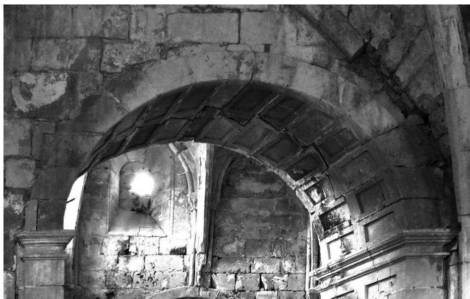
Imagen 13. Uno de los arcos esviados en la iglesia.
