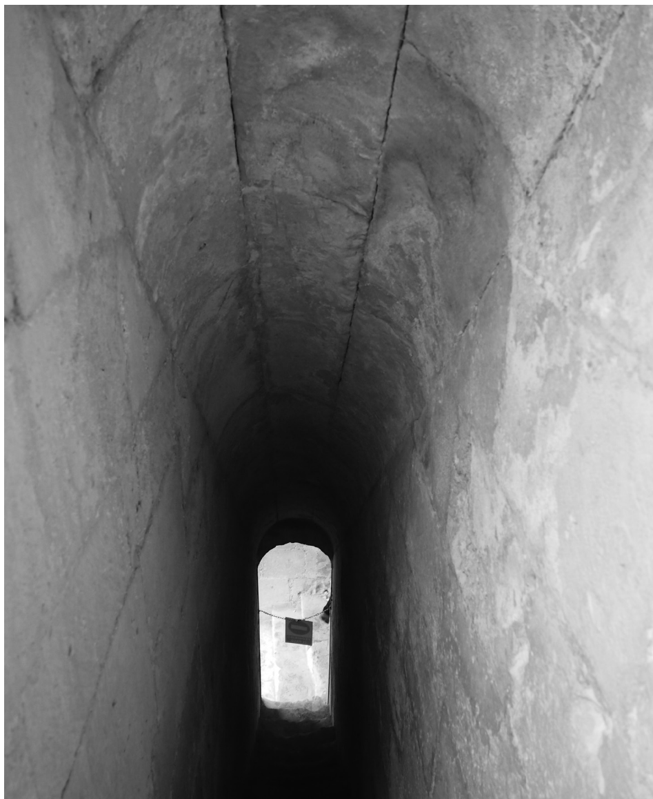
Imagen 15. Bóveda de cañón en descenso sobre una estrecha escalera.
