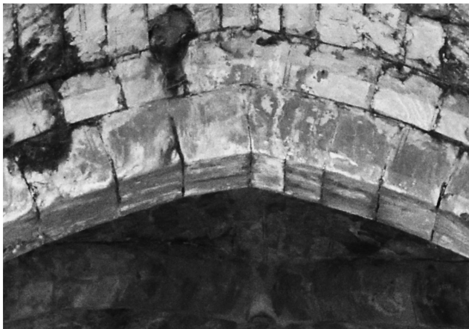
Imagen 2. Vértice de uno de los arcos perpiaños de la iglesia, resolviendo el quiebro con una dovela normal a la izquierda y otra cortada al bies a la derecha.
