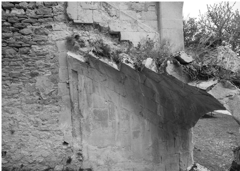
Imagen 16. Bóveda de cañón en descenso sobre la escalera que se encuentra entre el claustro y el patio de la hospedería.
