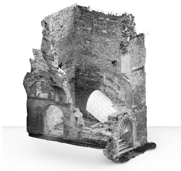
**FIGURAS 10.1 y 10.2. Análisis geométrico y restitución de la bóveda oblicua y escalones del primer tramo a partir de los datos obtenidos del modelo fotogramétrico, sombreado en color gris la parte de la estructura que aún está en pie (imagen superior). Reconstrucción 3D de la parte de la bóveda desaparecida, representada en color blanco, superpuesta sobre el modelo fotogramétrico de la ruina (imagen inferior).**
