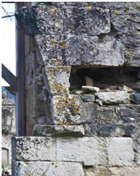
**FIGURA 3. Restos del muro marcando lo que era el intradós del arco.**
