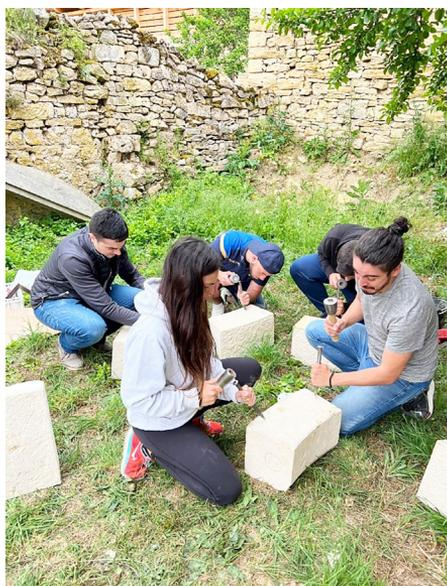
FIG. 1 – Alumnos del MUCRPA rematando la labra de las dovelas del arco, 2022 (MUCRPA).
