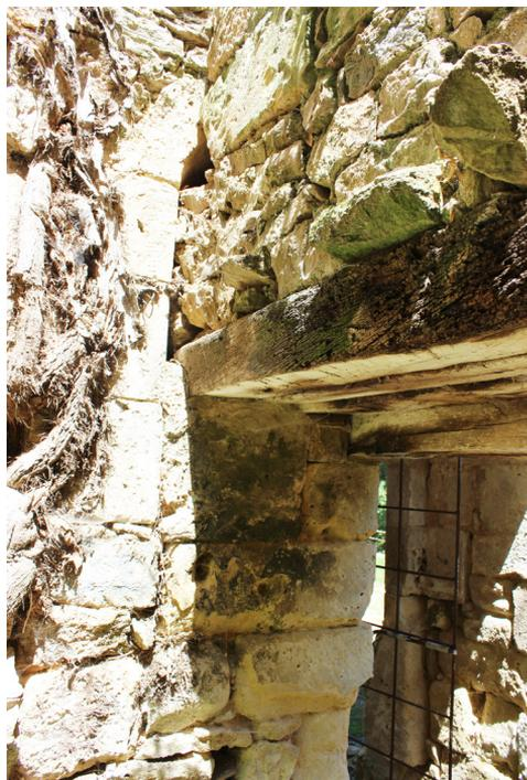
**FOTO 5. – Vista interior del punto de conexión entre la ventana abocinada, ya cegada por el muro lateral Este, la puerta existente en dicho muro y la jamba de la puerta exterior.**
