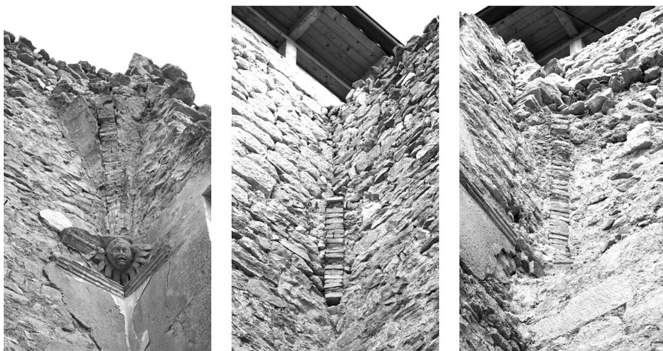
FIGURAS 8.1, 8.2, 8.3, 7.4. En la fotografía superior (7.1) se aprecian los distintos tipos de aparejos del paño número 4, así como el pasamanos de la escalera, algunas dovelas de la bóveda en decenda y fragmentos de revoco. En la fotografía inferiores (7.2, 7.3, 7.4 de izquierda a derecha) distinguimos tres arranques de ladrillo de la bóveda que cubriría la caja de escaleras. En la fotografía 7.2 también vemos las molduras y decoraciones del arranque de la bóveda.
