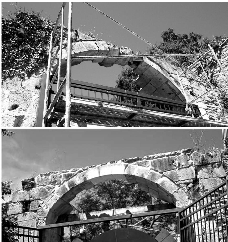
FIGURA 1. Arco rebajado, en la parte interior de la entrada, antes y después de la restauración.
