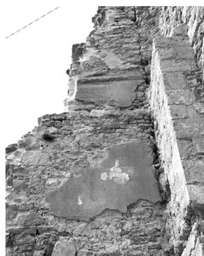
**FIGURAS 7.1, 7.2, 7.3. En la fotografía superior (6.1) se aprecian los distintos tipos de aparejos del paño número 3. En la fotografía inferior izquierda (6.2) vemos fragmentos de escalones embutidos en el muro y otras piedras que podrían formar parte de la bóveda en decenda. En la fotografía inferior derecha (6.3) observamos los restos de revestimientos del paño número 2.**
