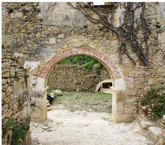
FIGURA 18. Interior del segundo arco, terminado.
