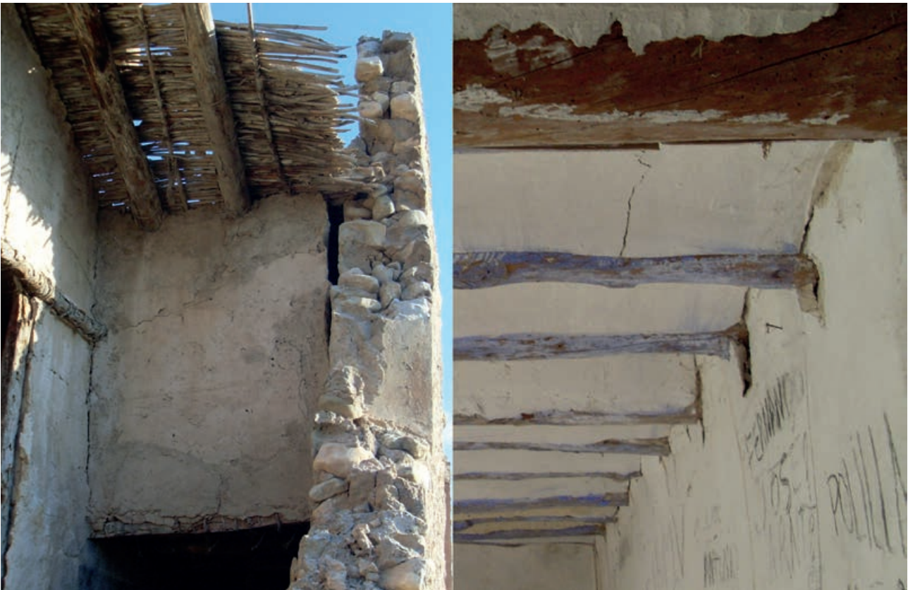
Figura 4. Muro de mampostería y cubierta y forjado. (Autor: Jaime Muñoz Gómez)
