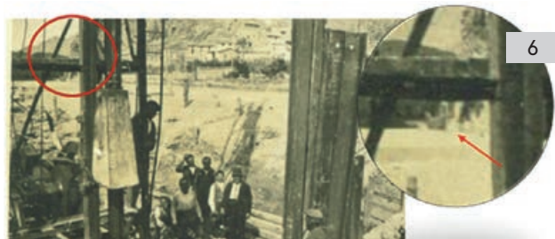
Figura 5. Tratamiento de la imagen del barco. Se descubre el barco con las tablas y el mástil, y una figura humana que está sentada, posible barquero. (Fuente: Estudio Miguel Crea) / Figura 6. Trabajos de entibación para la cimentación de los estribos del puente de hierro. (Grupo de Fotografías Antiguas de Blanca, «La pica del puente» Emilio Cano Candel. Detalle del barco, Autor: Miguel Ángel Molina Espinosa)
