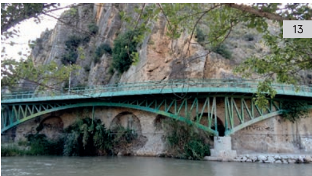
Figura 13. Ensanche de acero sobre el acueducto de las Excanales. (Autor: Miguel Ángel Molina Espinosa) / Figura 14. Esquema de la estructura y puntos de carga y reacción. (Autor: Miguel Ángel Molina Espinosa) / Figura 15. Cuadro del estado de las cargas y reacciones. (Autor: Miguel Ángel Molina Espinosa)
