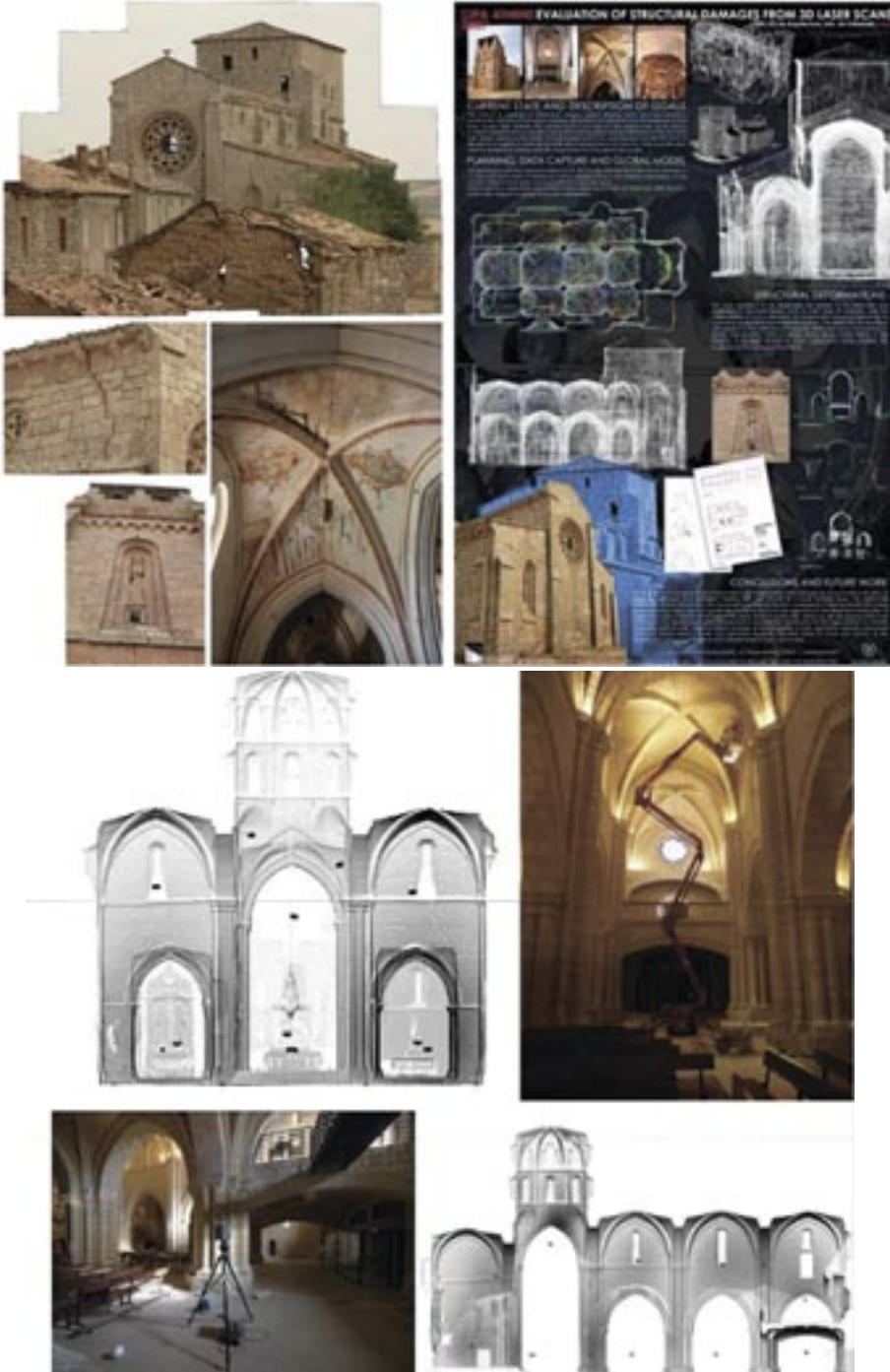
Iglesia de Santiago Apóstol, Villamorón (Burgos). Estudio de las deformaciones estructurales.
