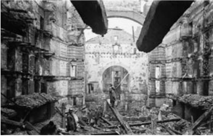
Teatro de Santa Cruz, de Barcelona, tras el incendio.
