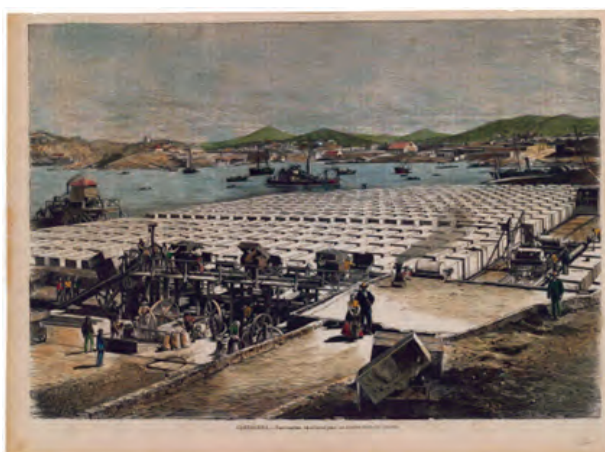
Foto 4. AGRM planero003-1_052 Grabado de Cartagena. Fabricación de sillares para las nuevas obras del puerto. 1873.
