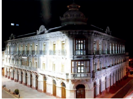
Fig. 2. Casa del Piñón. © Rafa Fotografía. (AMLU. FOT-2778-9).
