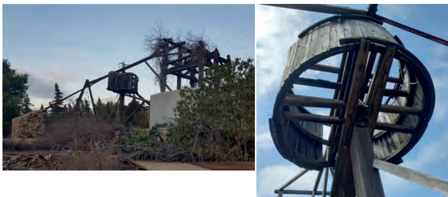
Figura 2. Vista general del malacate de la cantera Emilia. Figura 3: Detalle del tambor. En ambas imágenes se observa el estado avanzado de deterioro del malacate. Fotografías: Sonia Hernández Gómez.
