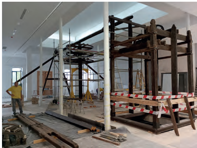
Figura 13. Imagen general de labores de montaje del malacate en el interior del Museo Minero. Fotografía realizada por Sonia Hernández Gómez.
