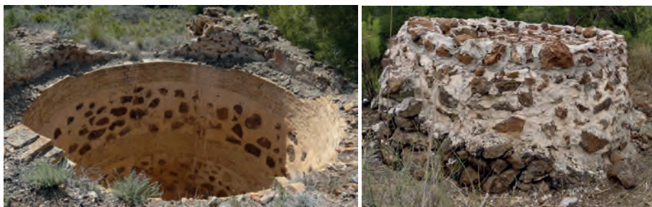
Figura 2. Pozo minero sin brocal y pozo con brocal reconstruido. Conjunto minero de la Peña del Águila.
