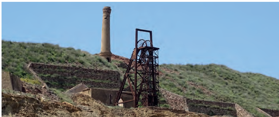
Figura 5. Castillete, salas de máquinas y de calderas, y chimenea de la Mina Montserrat. Cabezo Rajao.
