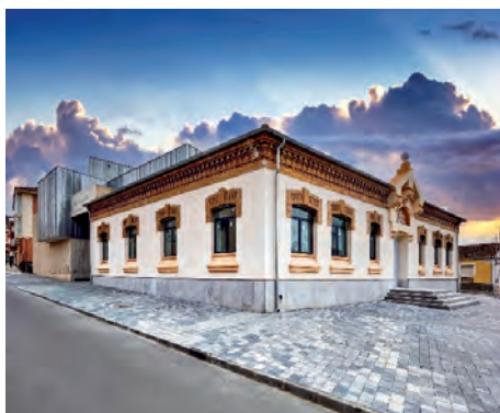
Fig. 10. Obra finalizada. Liceo de Obreros-Museo Minero. Febrero de 2023. © Fotografía de Pedro J. Bernal.
