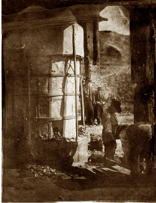
Horno atmosférico en la Sierra Minera de Cartagena para fundir escorias. Fotografía Federico de Botella y Hornos. 1864.
