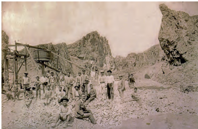
Figura 1. Cabezo Rajao. Vista interior de la Raja. Autor: Ángel Martínez. En la imagen se observan dos malacates instalados en sendos pozos pertenecientes a la mina Virgen de los Ángeles. Archivo Municipal de La Unión.
