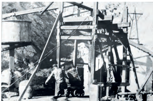
Figura 14. Fotografía donde se observa un esportón cargado de mineral sobre un zorrillo bajo las instalaciones de un malacate. Archivo Francisco Silvente.
