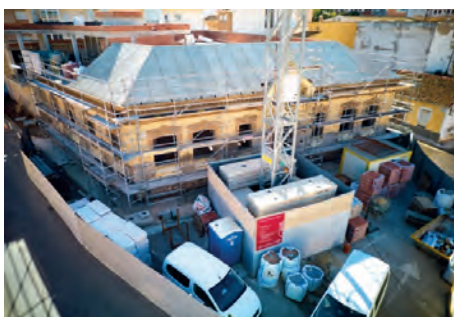
Fig. 9. Obras de rehabilitación del Liceo de Obreros- Museo Minero. © Fotografía de Pedro J. Bernal.
