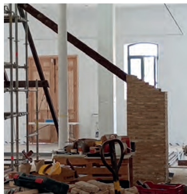
Figuras 9 y 10: Imágenes de los trabajos de ejecución de los machones laterales de ladrillo. Fotografías: Sonia Hernández Gómez.
