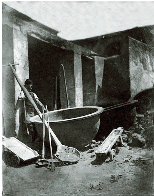
Caldera, moldes y útiles para desplatación o copelación en la Sierra Minera de Cartagena. Fotografía Federico de Botella y Hornos. 1864.
