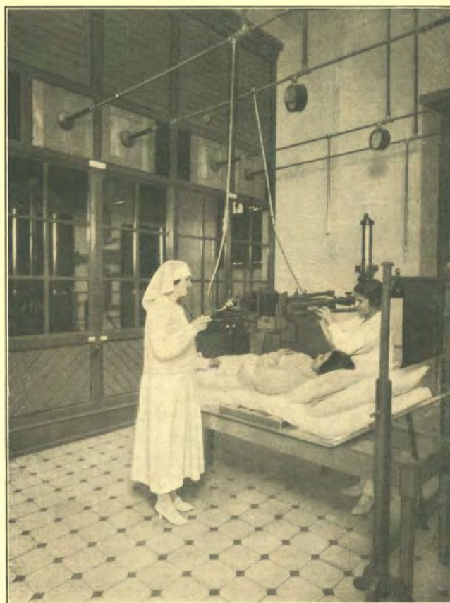
Instalación de Rayos X con destino a la terapia
