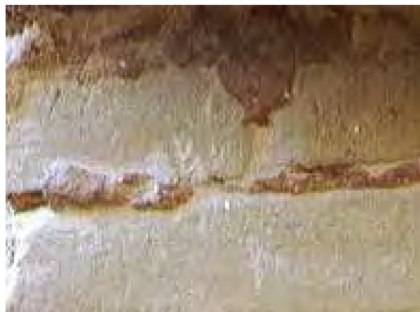
Fig. 32.- Empleo de la arcilla roja en la unión de adobes (GENER, J.M.).
