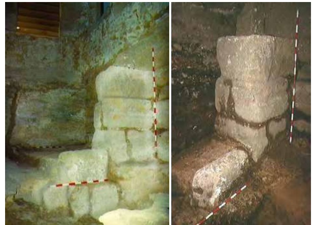
Fig. 63.- Estructuras perpendiculares al muro de pilares del periodo II (GENER, J.M.)
