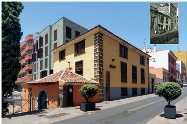
Figura 1. San Cristóbal de La Laguna, calle de los Herradores: Capilla de la Cruz Verde, casa colindante e imagen de las casas que existieron en los solares donde ahora está el edificio con el número 7. Fotografía: Carlos Rodríguez Morales. Imagen en blanco y negro: Delegación Territorial del Catastro (AHPT).
