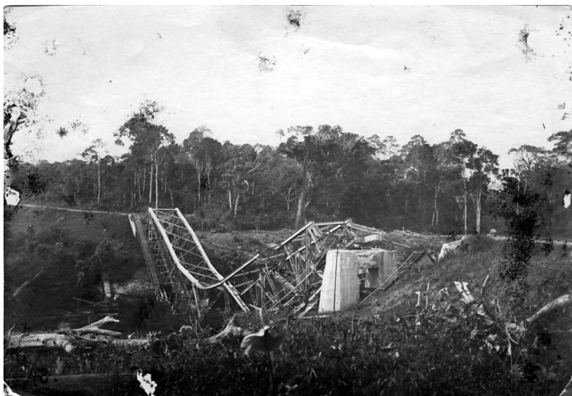
Fig. 14. Voladura de un puente sobre el río Nkele. Fuente: APPB.
