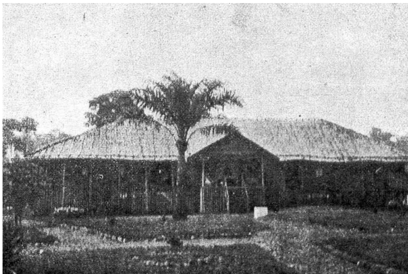
Fig. 32. La denominada “casa del veterinario” constituía el núcleo central de los asentamientos de Pequeno Bokoko. Fuente: Una Obra de... Apéndice fotográfico.
