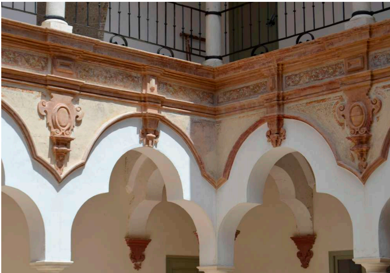
Elementos de ladrillo en el patio principal de una casa señorial rehabilitada
