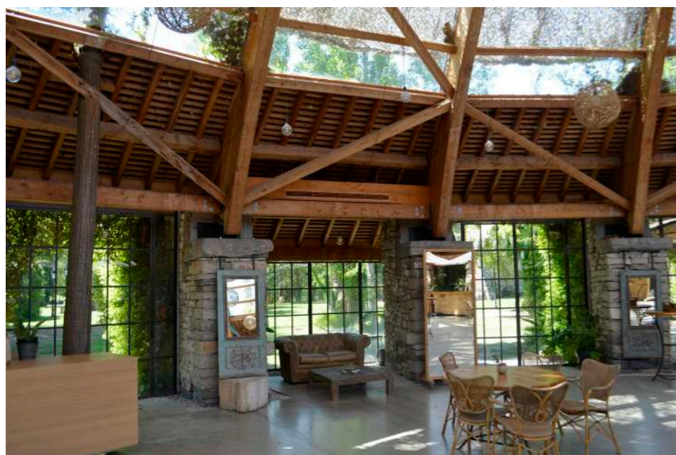
Punto de encuentro de la cúpula con los soportes de piedra seca
