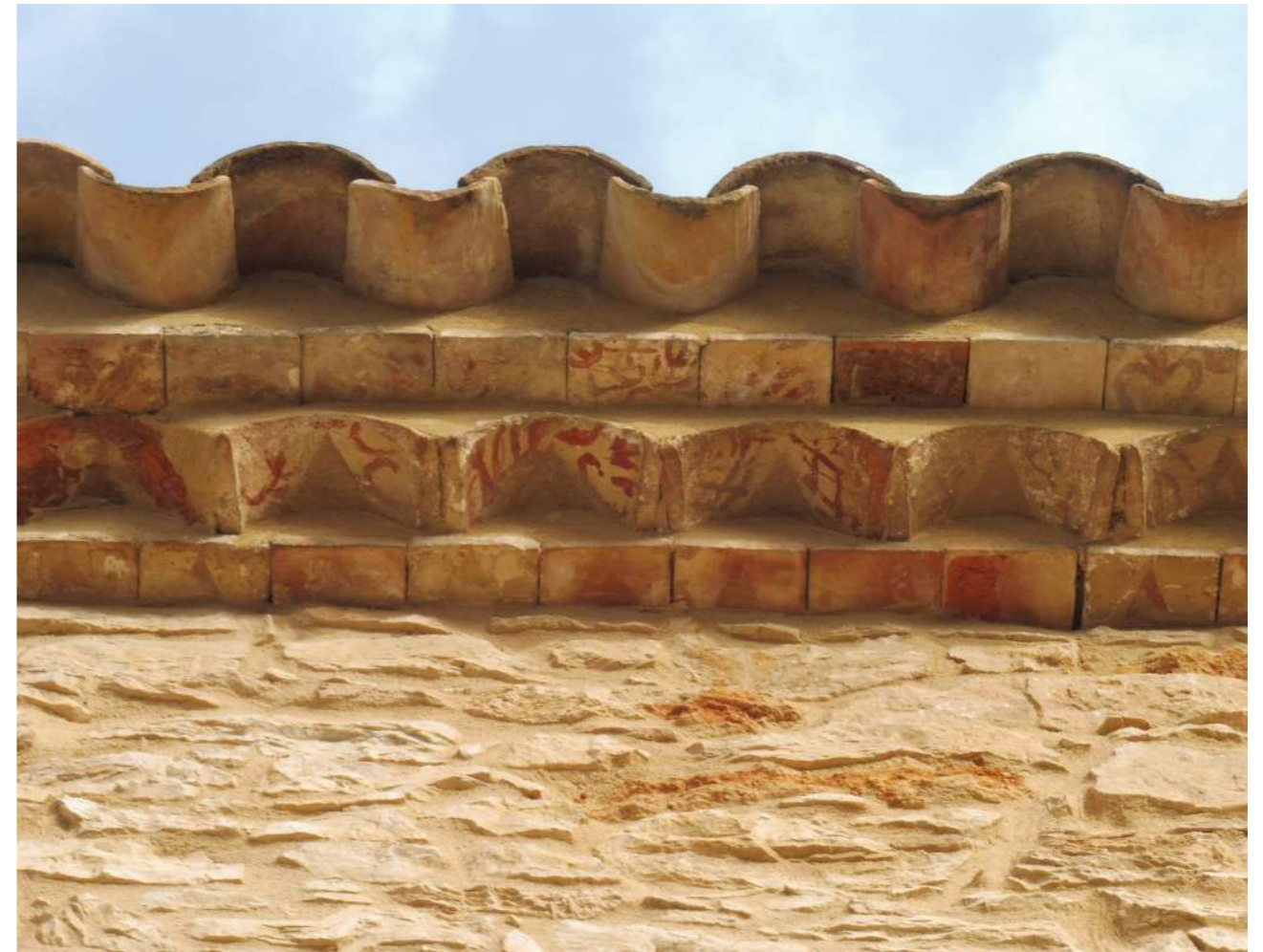
Alero en un edificio de Begur, Gerona
