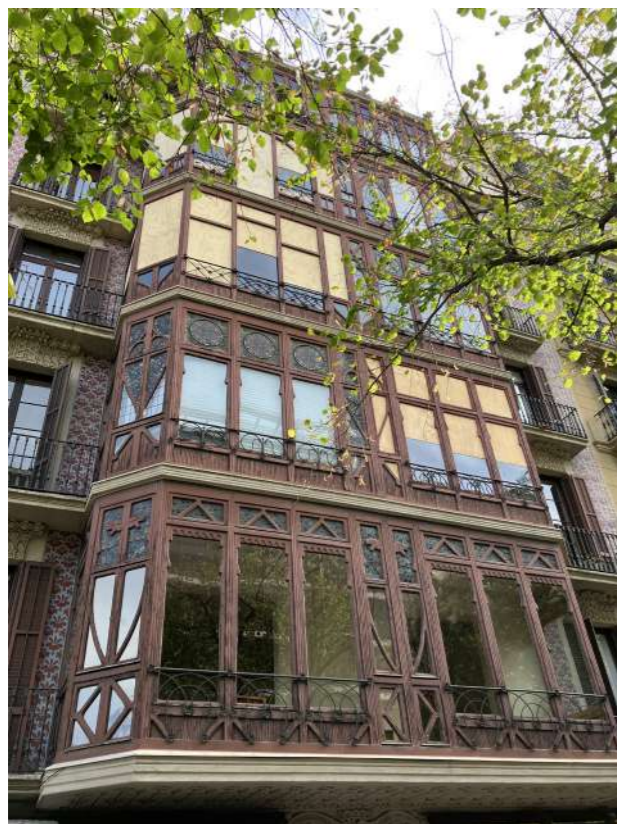
Restauración de la estructura de una tribuna de madera en un edificio modernista del ensanche de Barcelona
