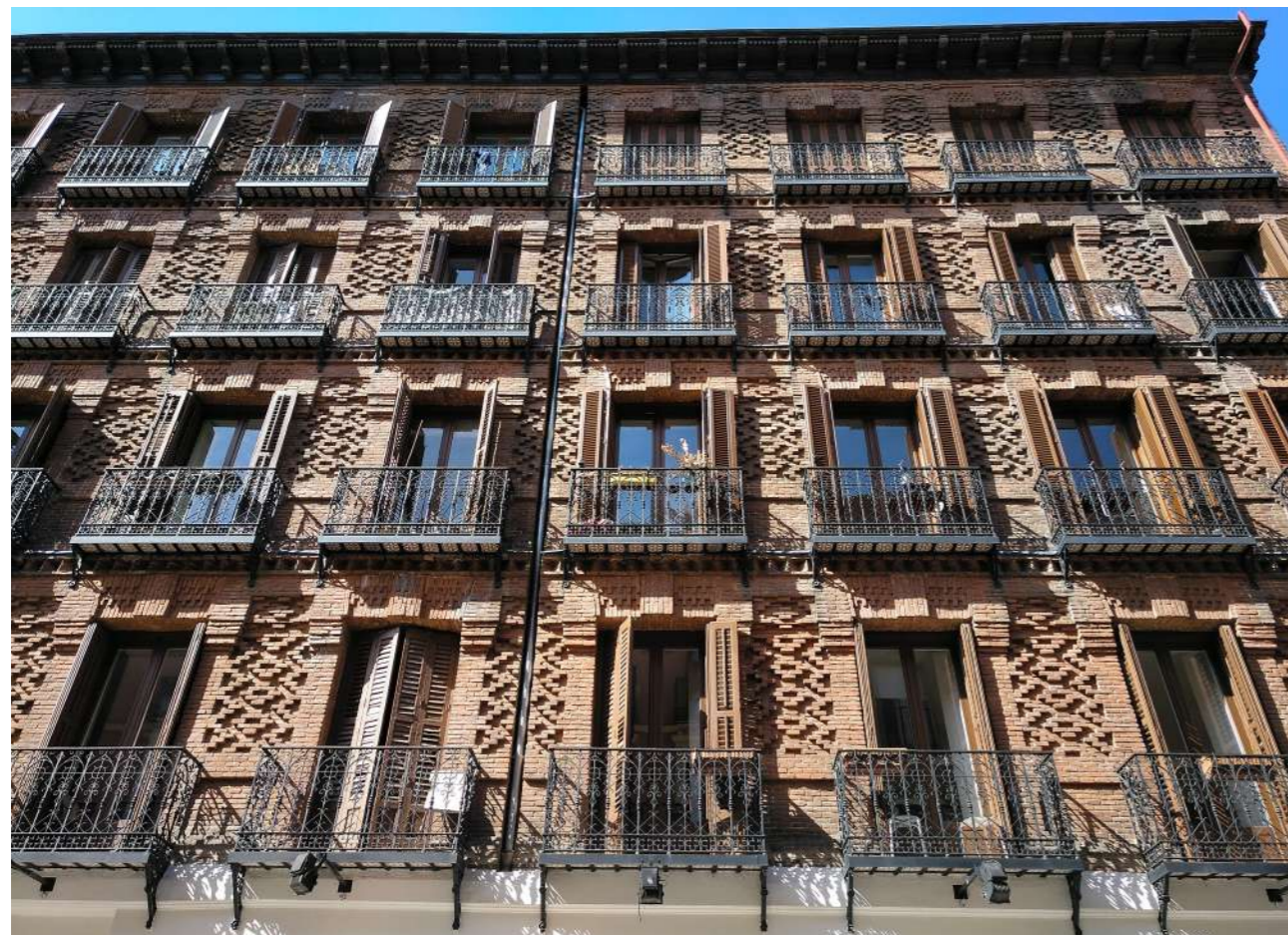
Fachada de un edificio de viviendas en Madrid
