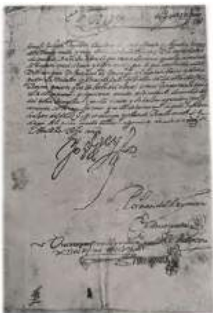
Figuras 20: Carta de Felipe II donde otorga primacía a la construcción de la torre de San Miguel del Estacio. Fuente: Jiménez (1957) del A.M. Murcia).
