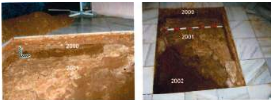
Fig. 8. Vistas de la Cata 2, donde se aprecian los tirantes de cimentación que unían los pilares de las naves laterales.
