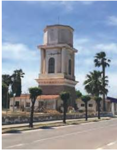
Ilustración 8: Depósito Elevado de Agua. Foto de la autora.
