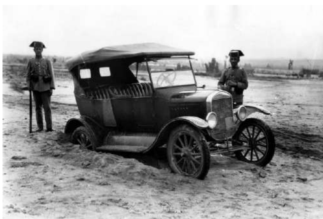
Fig. 18: Hacia 1920. Efecto de la falta de afirmado.
