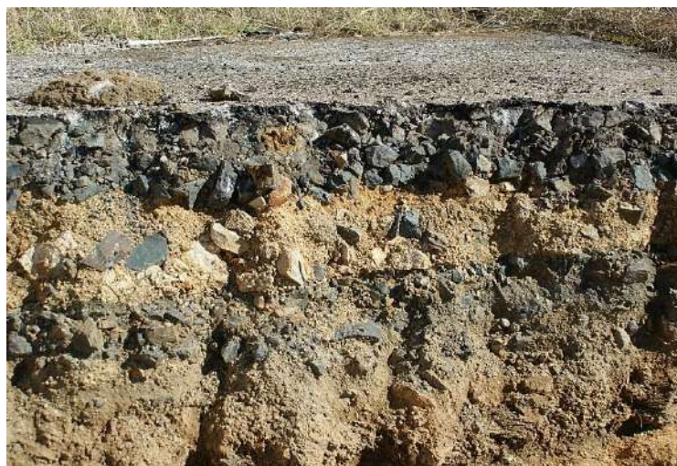
Fig. 10: Sección transversal de una carretera de 1 er orden de España según consta en el Atlas o anexo de la obra Carreteras de Manuel Pardo, y que se correspondería con la aquí estudiada.
