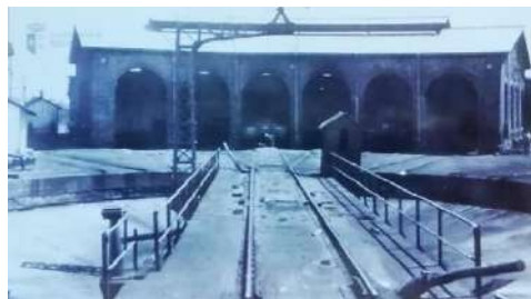
Figs. 10 y 11: Puente giratorio y cocherón de locomotoras de Los Rosales y restos de la reserva de máquinas y del puente giratorio de Cerro del Hierro (Colección autor y J. J. Romero).
