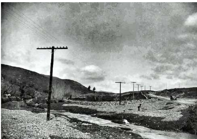
Fig. 9: La carretera en la zona del arroyo del Culebrín hacia 1927. En el primer plano, el acopio de piedra machacada para la reparación del firme.
