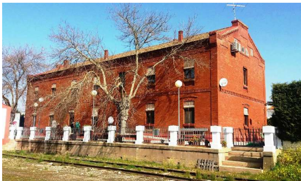
Fig. 7: Dormitorio de maquinistas, denominado La casa roja , en Llerena (2016). Archivo autor.
