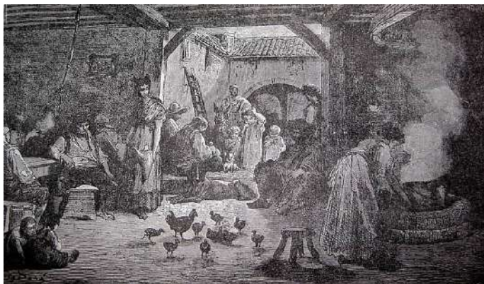
Fig. 28: Interior de una venta en Extremadura (Gustavo Doré).
