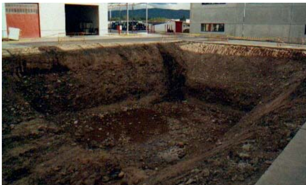
Figura IV.29. Excavación del principal foco contaminante detectado.
