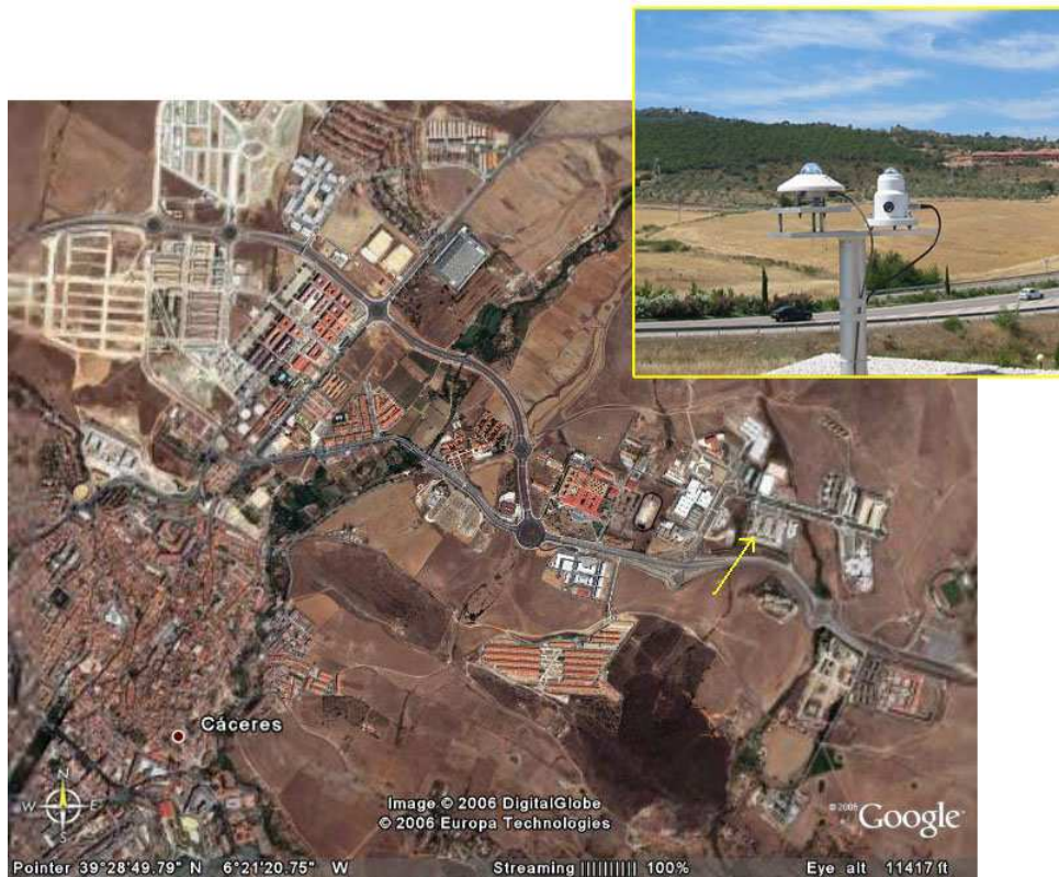
Figura 4.4: Estación de medida de radiación solar en Cáceres y su localización exacta (fuente: Google Earth).
