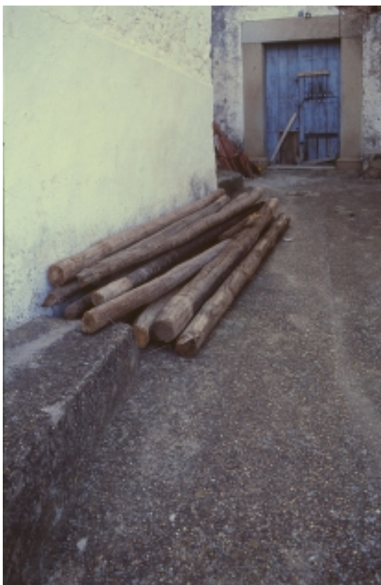
Figura 7.3.23. Acopio de rollos para reparar el forjado de una casa de Magacela. (Foto: D. Duque)
