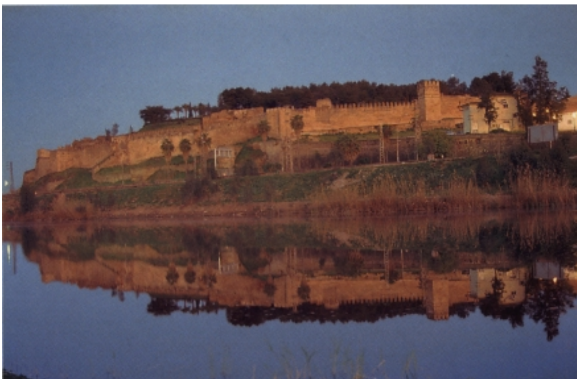
Figura 5.4.1. Vista general de la Alcazaba de Badajoz desde el Guadiana. (Foto: J.J. Monroy Cobos)
