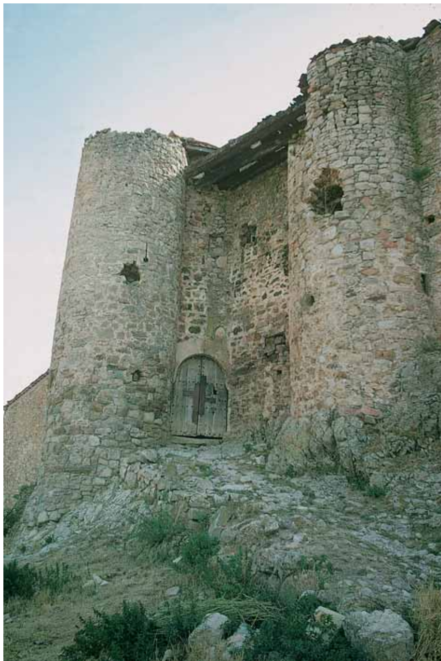
Torrefuerte. Entrada principal.
