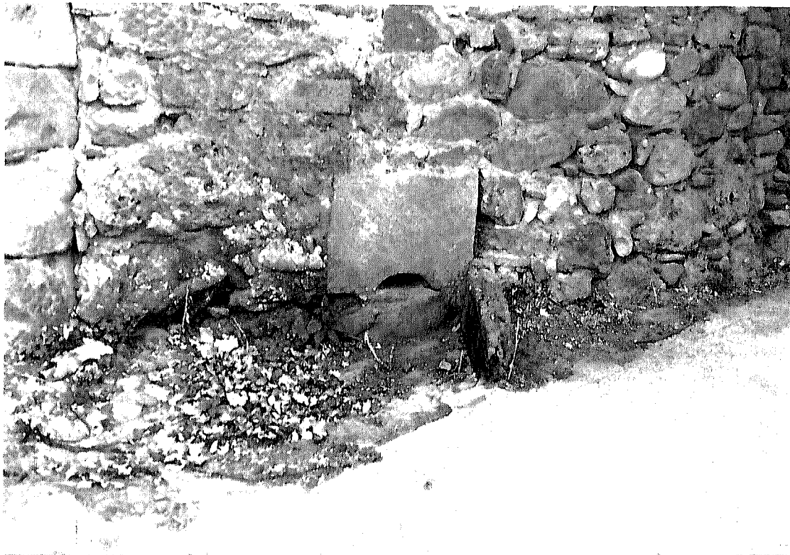
Lám. 4. Aguadojo: boca de salida. (Viniegra de Abajo)
