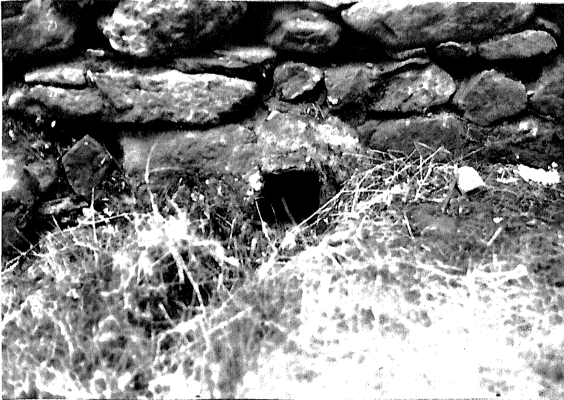
Lám. 3. Aguadojo: boca de entrada del agua de riego. (Viniegra de Abajo)
