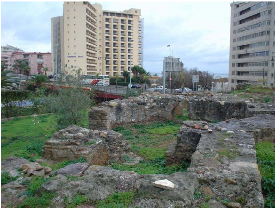
Ilustración 123 Vista del yacimiento de Torreblanca del Sol. Su afección principal es la falta de vallado, en buen estado, de la parcela y, como consecuencia de ello, la acumulación de basura sobre los restos de las antiguas termas. (Archivo del Autor, 2009).
