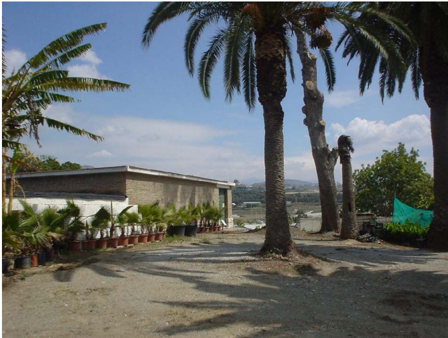
Ilustración 191 Caseta donde se halla el hipogeo mayor del yacimiento de Trayamar. Nótese el entorno elevado, donde se ubica un vivero. (Archivo del Autor, 2009).
