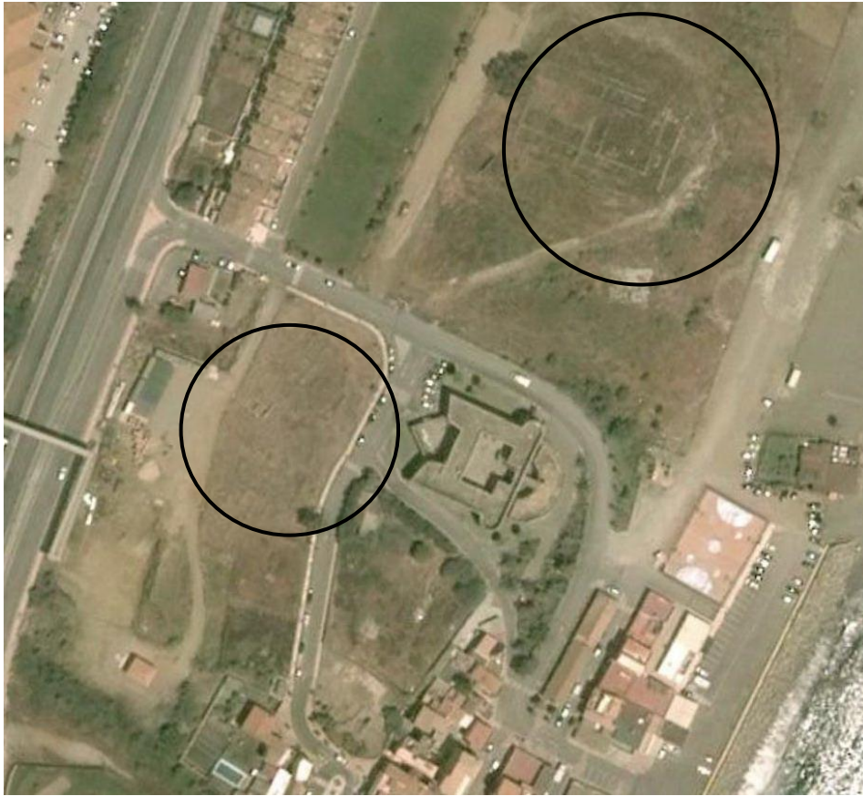
Ilustración 40 Restos que afloran junto al Castillo de la Duquesa. Pueden apreciarse las trazas de las antiguas edificaciones. Nótese la inserción del yacimiento entre dos bordes rotundos: el mar y la N-340.
