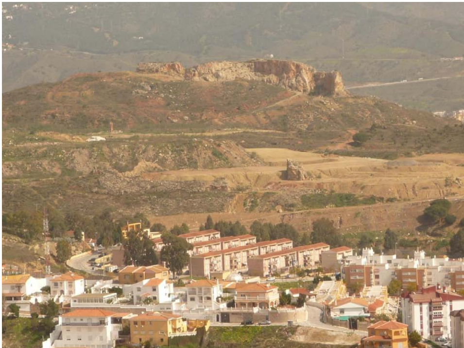
Ilustración 129 Vista del Monte Coronado, desde el Cerro de la Tortuga. En primer plano se aprecian los movimientos de tierras, debidos a la explotación del cerro como cantera. (Archivo del Autor, 2009).
