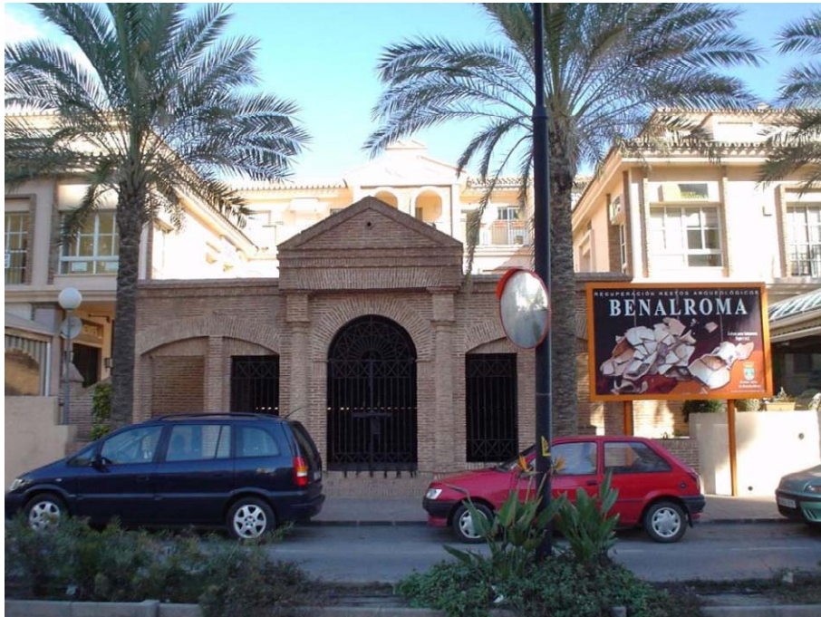
Ilustración 122 Edificio que contiene los restos de la villa romana de Benal-Roma. (Archivo del Autor, 2009).
