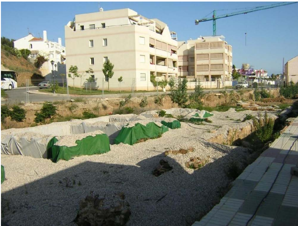
Ilustración 168 La fosa principal del yacimiento de Benagalbón, limitada por el Camino Viejo de Vélez (izquierda) y la N-340 (derecha). Se aprecia en primer término la lámina de geotextil y la grava, sobre la que posteriormente se ha edificado, tratándose de una superposición fija. A la izquierda se atisba el segundo núcleo del yacimiento, la llamada Loma de Benagalbón. Al fondo, donde aparece la grúa torre, se encuentra el tercer núcleo del yacimiento. (Archivo del Autor, 2008).
