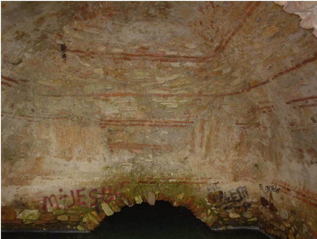
Ilustración 54 Interior de los Baños de la Hedionda. Véanse los grafitis sobre el paramento original romano. (Archivo del Autor, 2008).
