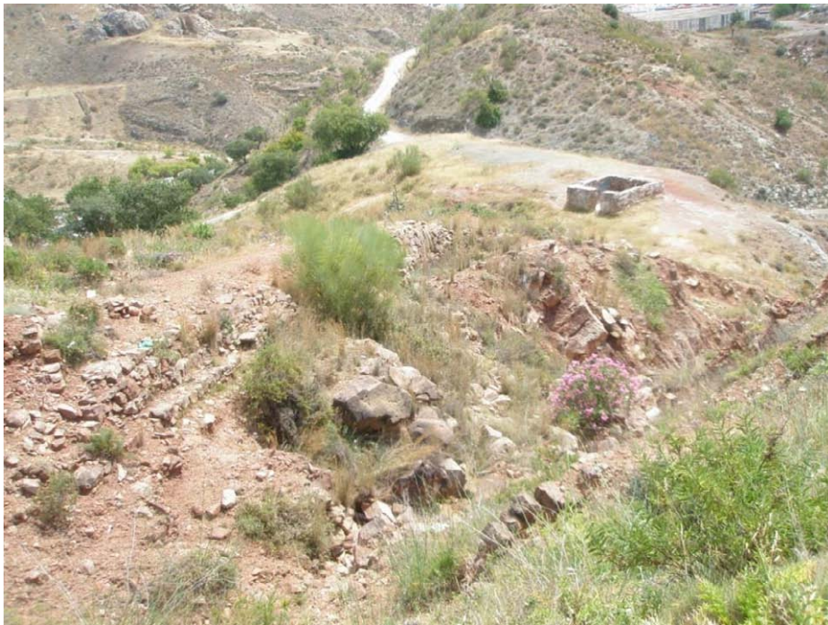
Ilustración 140 Vista de la ladera del Monte Coronado, donde se aprecian, junto a restos de paramentos antiguos, elementos como construcciones abandonadas, explanadas llenas de vertidos, sucios caminos de tierra y grafitis, todos ellos entre pedruscos desprendidos de la cima del monte. (Archivo del Autor, 2009).
