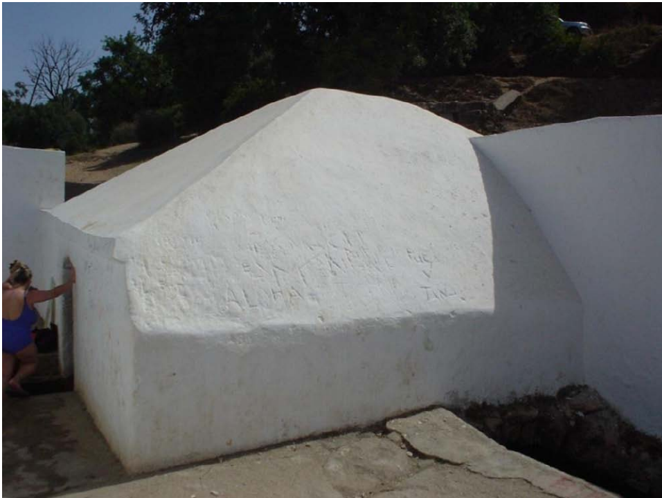
Ilustración 55 Raspado del revoco de yeso y suelos deteriorados, en los Baños de la Hedionda. El acceso al interior se produce por la puerta, a la izquierda de la imagen. (Archivo del Autor, 2008).
