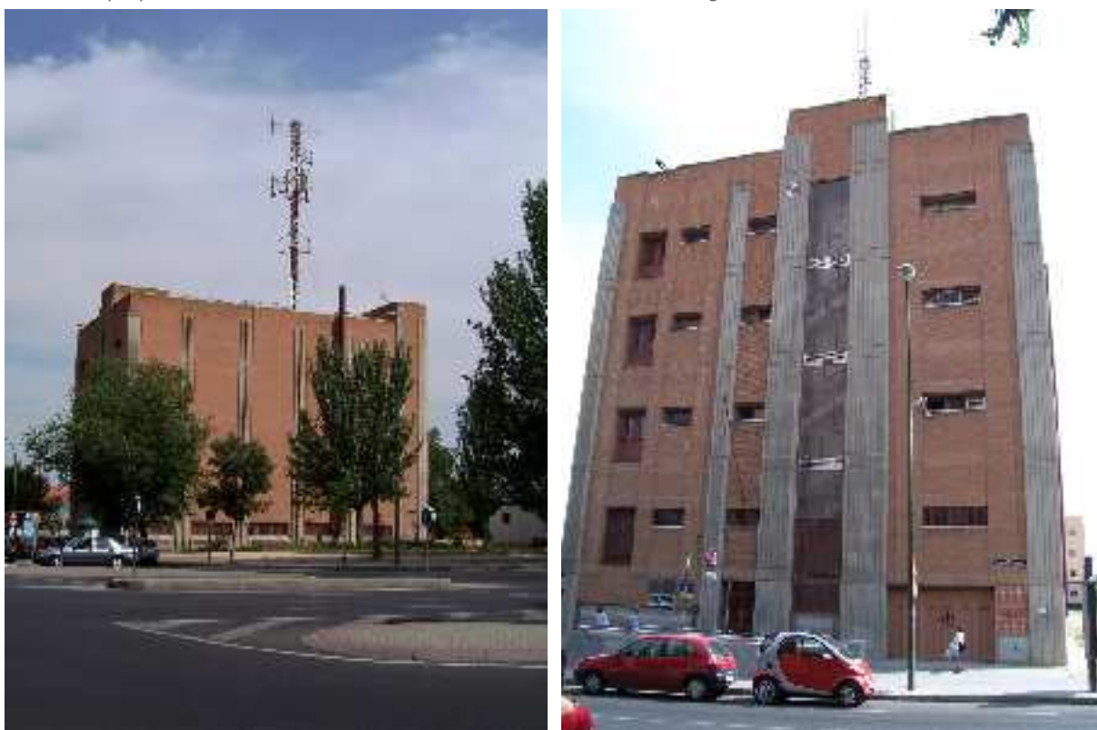
Figura 5.152: Central telefónica Madrid "Pavones", 1976, Damián Galmés de Fuentes. Colección propia del autor.
