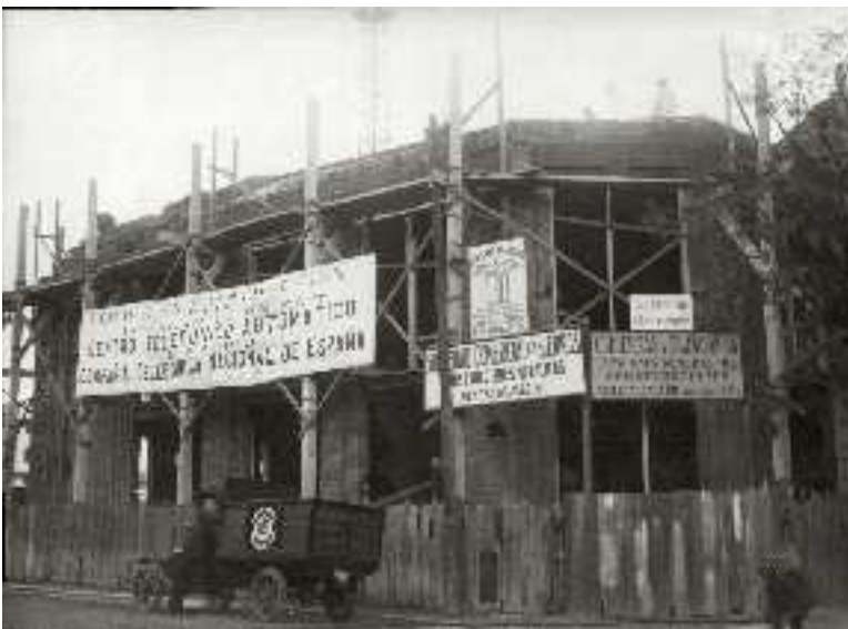
Figura 4.79: Central “Salamanca”, calle Hermosilla (Madrid), 1926, Ignacio de Cárdenas Martín. Construcción del edificio para el equipo automático y aspecto final. Se puede ver la torre metálica por la que llegaba el cableado a la vieja central manual. En la imagen de la derecha se aprecia también la zanja para la red subterránea que se construía para sustituir el sistema antiguo. Fotografías: Alfonso, Archivo Histórico Fotográfico de Telefónica.
