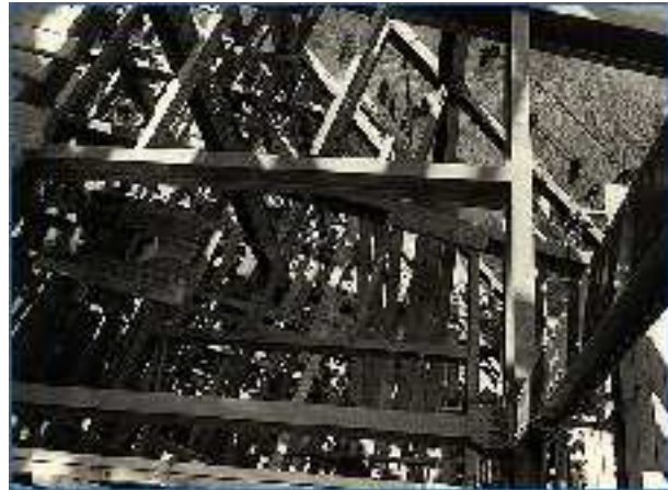
Figura 2.37: El esqueleto metálico de la central convertido en obra de arte fotográfica por Claret. Archivo Histórico Fotográfico de Telefónica.
