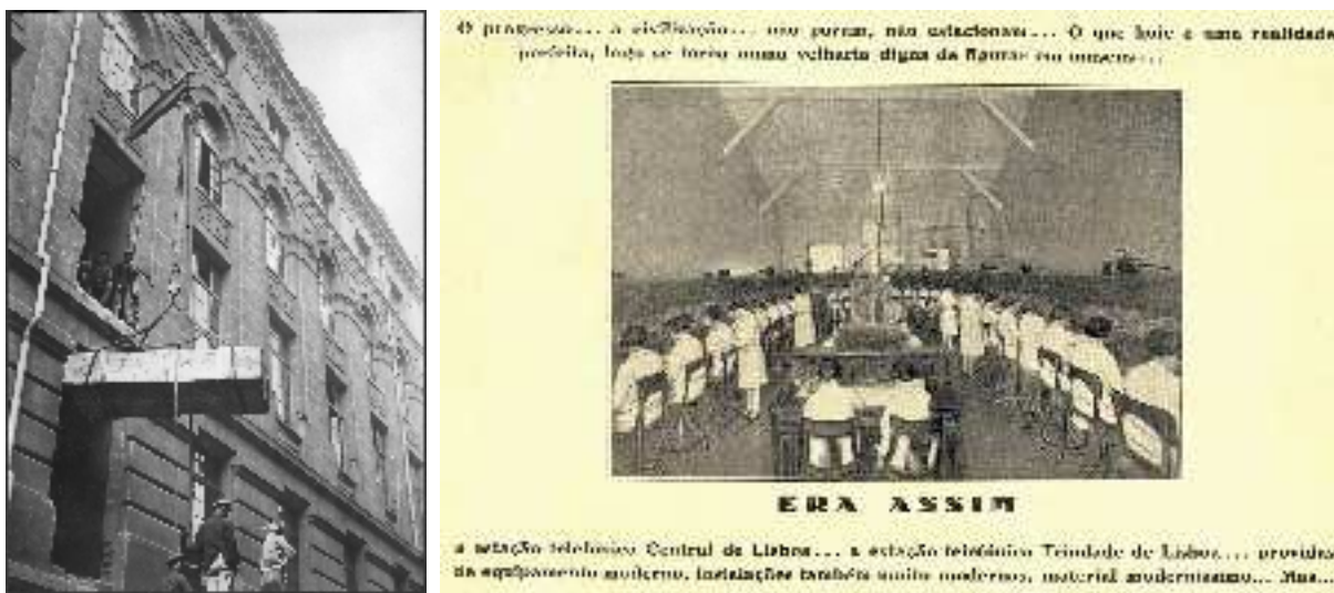
Figura 3.187: Central Trindade , Lisboa (Portugal), inaugurada en 1925. A la izquierda, introducción de equipo para convertirla en la primera automática del país en agosto de 1930. La viga de carga es provisional y ha habido que dismantelar dos balcones para permitir el paso. A la derecha, anuncio de la Anglo Portuguese Telephone Company sobre el acontecimiento. Fuente: Fundação Portuguesa das Comunicações .
