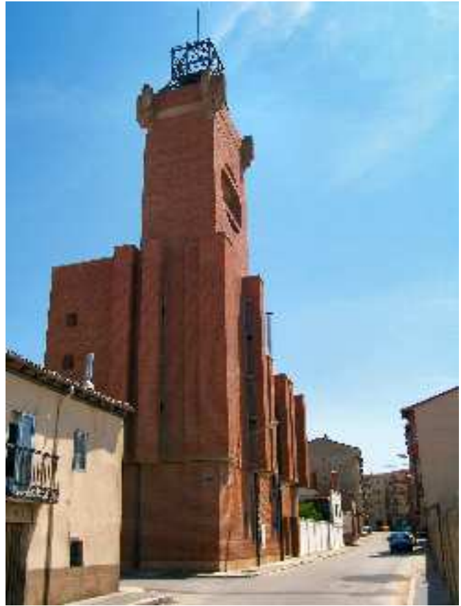
Figura 5.130: Central de Burgo de Osma (Soria), 1972-1973, Antonio Fernández Alba en colaboración con el ingeniero José Ortiz. Colección propia del autor.
