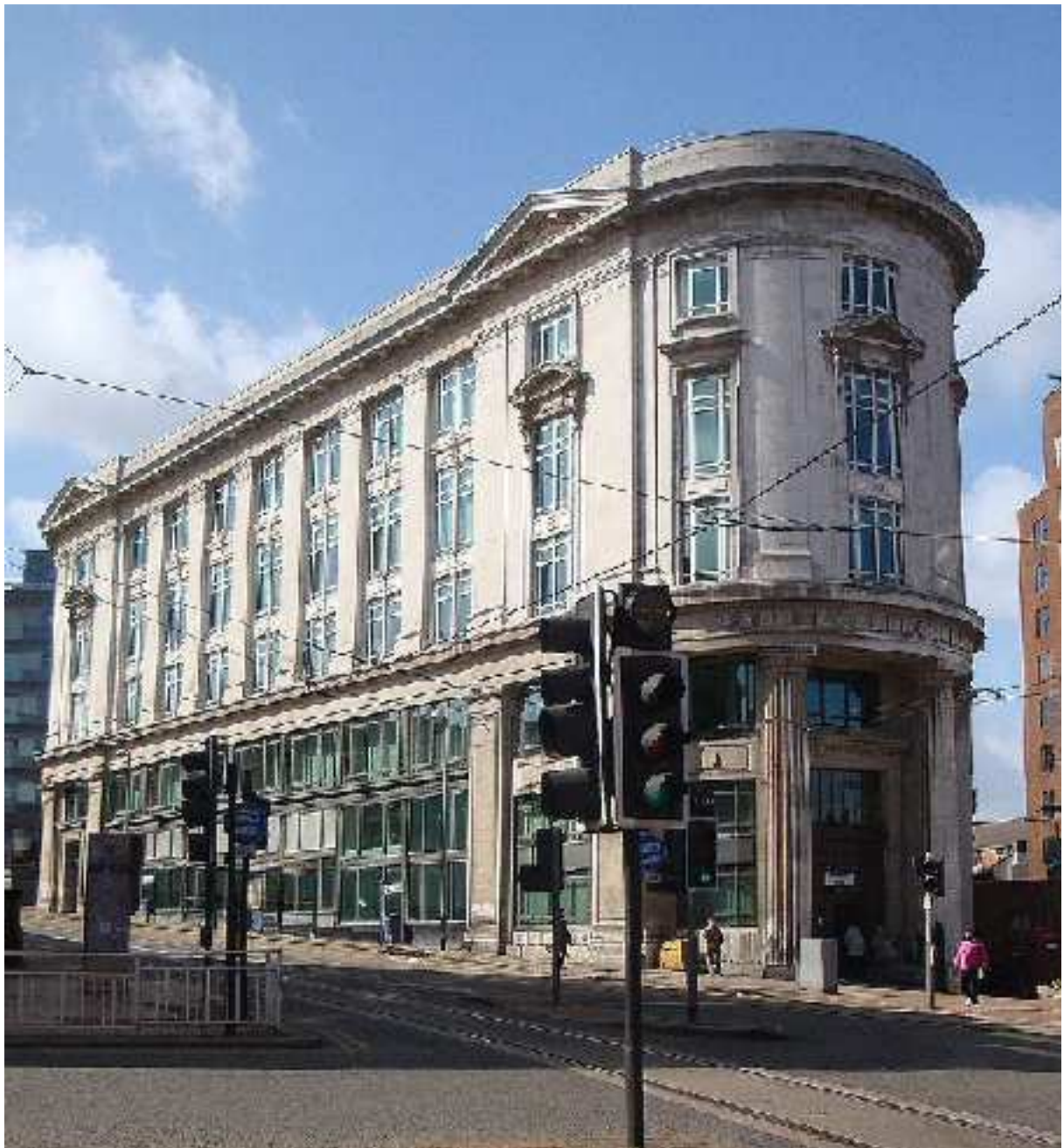
Figura 3.165: GPO Building , Sheffield (Inglaterra), 1927-1928, H. T. Rees, arquitecto de la H.M. Office of Works . El edificio era oficina postal y central telefónica. Fotografía: Philip Wright.
