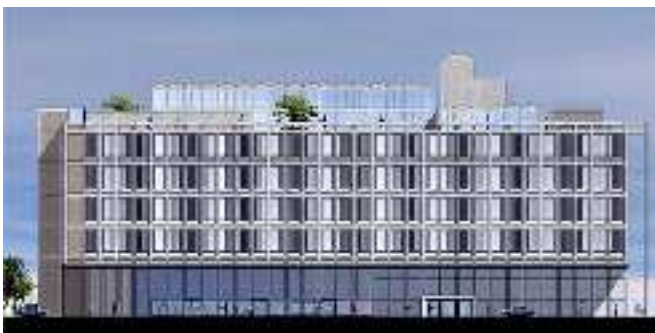
Figura 5.18: Edificio Telex RTT, Bruselas (Bélgica), 1957-1965, Léo Stynen.
