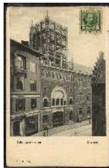
Figura 3.136: Odense (Dinamarca), central de la compañía local, de estilo neorrománico y con un gran templete metálico.
