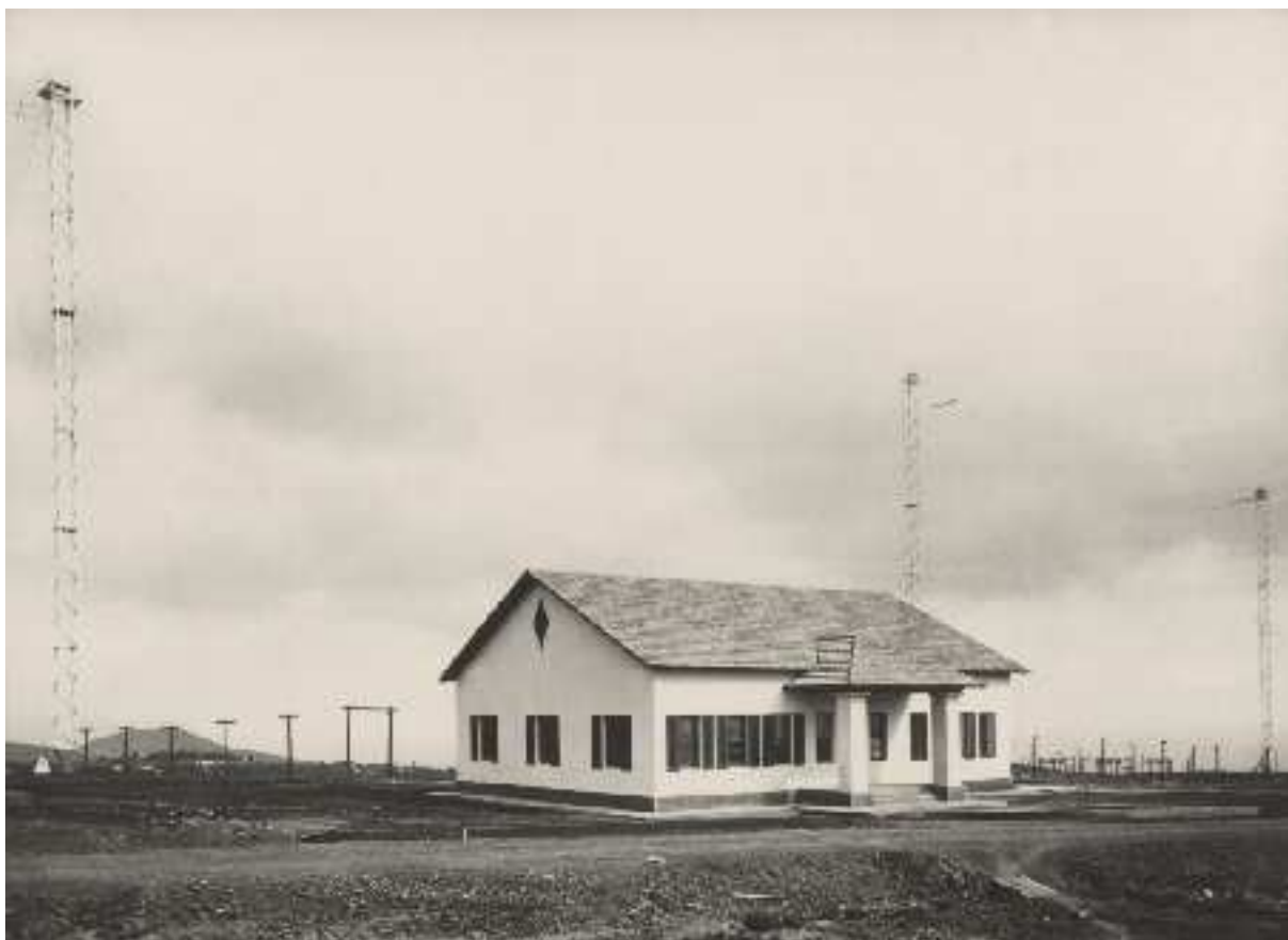
Figura 5.47: Estación radiotelefónica en El Tablero (Tenerife), 1944, Departamento de Edificaciones. Este enlace fue uno de los primeros frutos de la colaboración norteamericana, aun antes de finalizar la Guerra Mundial. Archivo Histórico Fotográfico de Telefónica.
