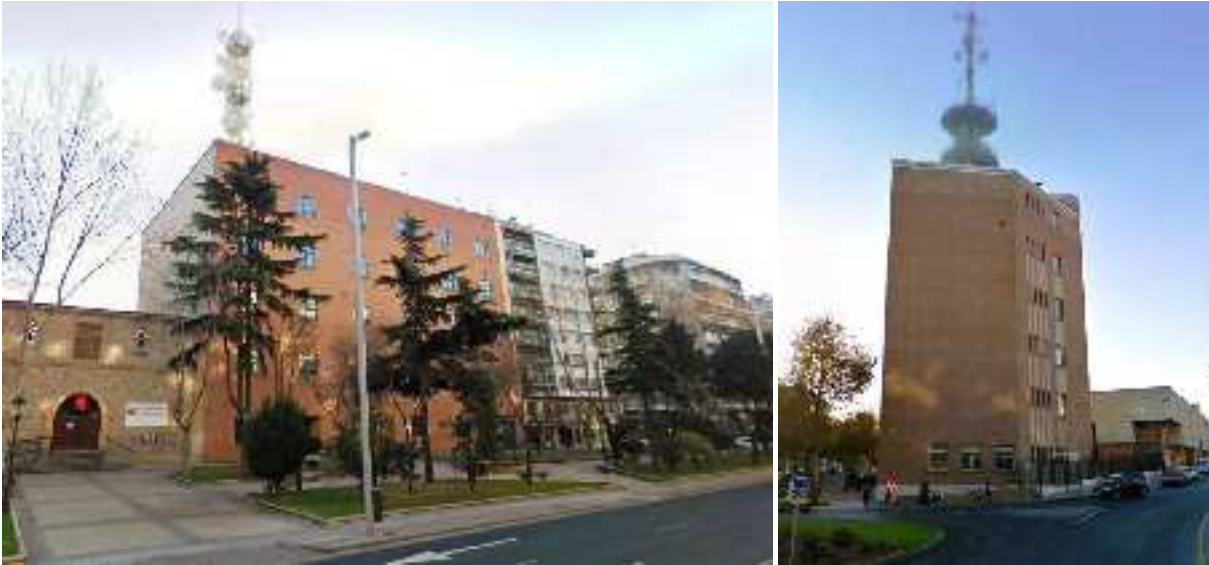
Figura 5.180: A la izquierda, Salamanca "Garrido", 1966, Emilio García de Castro Márquez y Gonzalo González Gómez. Google Street View . A la derecha, Huelva "Onuba", 1966-1969, mismos autores. Google Street View
