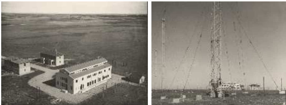
Figura 4.29: Izquierda, Pozuelo del Rey (Madrid), edificio construido para alojar las instalaciones del equipo receptor del radioenlace Madrid-Buenos Aires. Los pequeños edificios auxiliares son viviendas para el personal de mantenimiento y guardeses, que contaban con huerta y gallinero.
