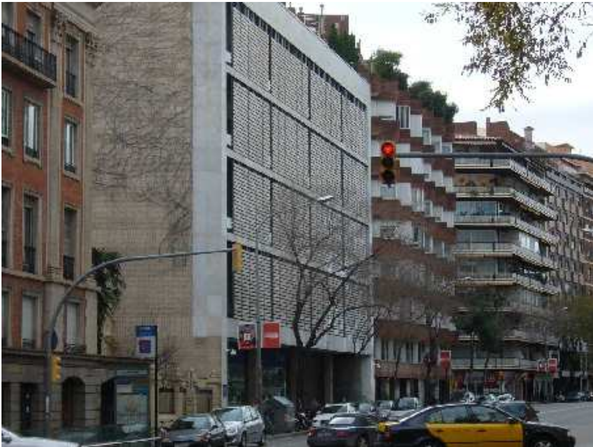
Figura 5.141: Central telefónica “Vía Augusta”, Barcelona, 1972-1977, Francesc Mitjans i Miró. Fuente: Panoramio .
