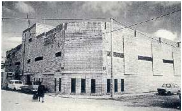
Figura 5.146: Arriba, bocetos de las fachadas de la central "Poniente", Fuenlabrada (Madrid), 1972, Damían Galmés de Fuentes, Manuel García Guerra y Emilio Pardo San Pedro. A la derecha, fotografía anterior a la ampliación de 1978. (CAM XI, 1999, p. 462-464)
