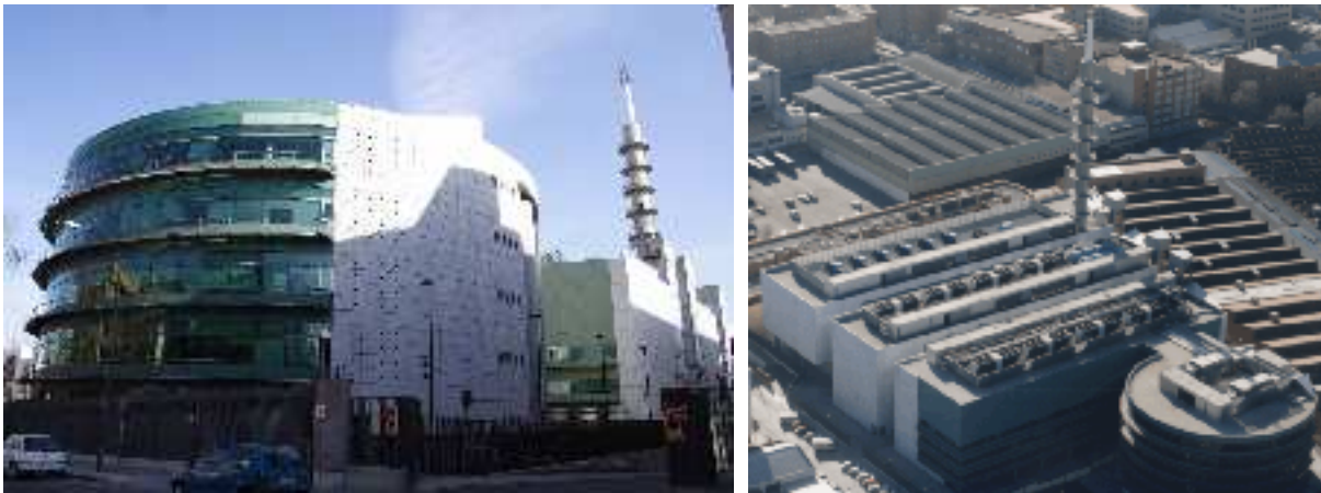
Figura 6.59: Centro de proceso de Datos y central telefónica, Madrid, calle Julián Camarillo, 1989-1994, Francisco José Larrucea Camporró. Fotografías: Archivo DCOMOMO Ibérico y Gop Oficina de Proyectos.
