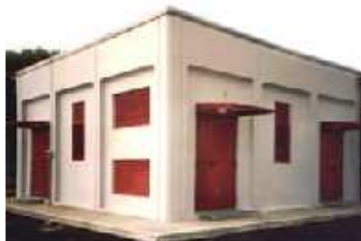
Figura 1.47: Edificio tipo MD6 de Telecom Italia . Fotografía de autor desconocido.
