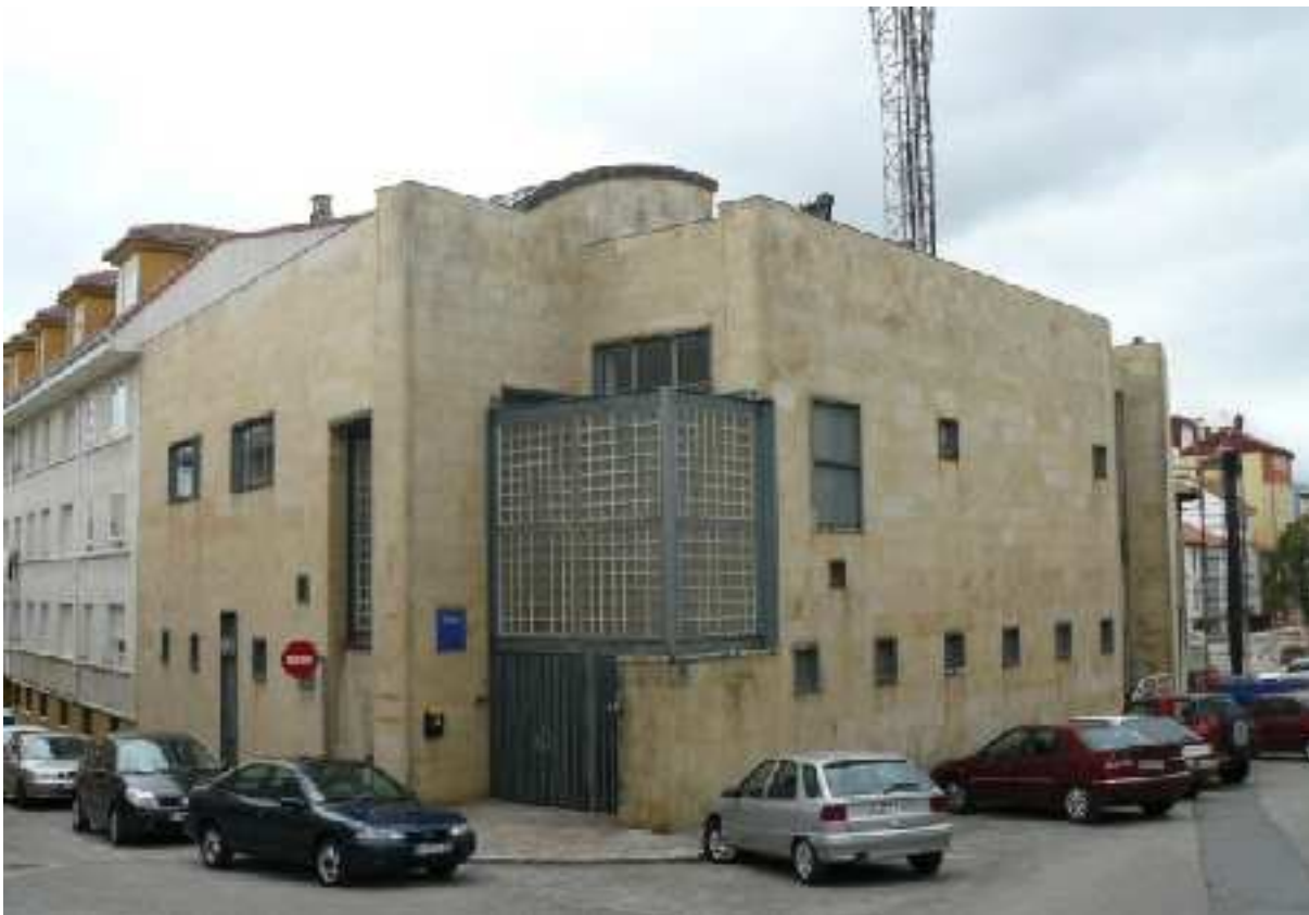
Figura 6.64: Central telefónica, Reinosa (Cantabria), 1994, Clemente Lomba Gutiérrez y Eduardo Manzanares Campo. Colección propia del autor.
