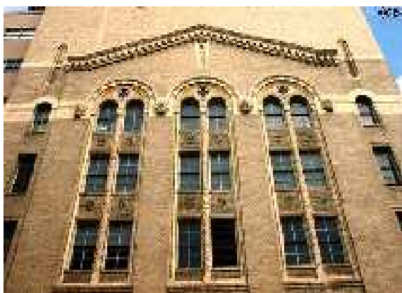
Figura 3.87: Grand Rapids (Michigan), 1926, SH&G. Detalle de la fachada. Fotografía de Jim Steinhart, www.travelphotobase.com
