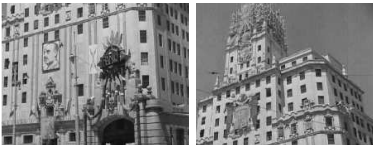
Figura 5.43: Dos fotogramas del NO-DO que muestran el castillo de fuegos artificiales que se montó en el edificio de Gran Vía en mayo de 1939 66 para celebrar la victoria de Franco. No había habido tiempo para reparar los daños de la artillería, así que las banderas y colgantes se colocaron para disimular los boquetes en los muros.
