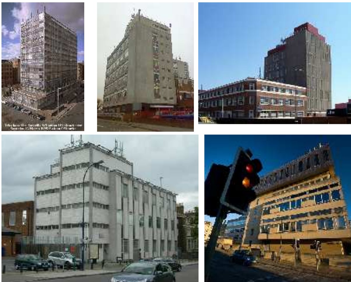
Figura 5.79: Algunos ejemplos de centrales británicas “odiosas” de los años 60 y 70. Arriba, izquierda, Telephone House, Manchester (1961). Fotografía: Aidan O'Rourke. En el centro, central de Newbury 128 . Fotografía de autor desconocido. A la derecha, torre de Grimsby (1973) junto a la antigua central Art Déco. Fotografía: David Wright. Abajo, izquierda, central Forest Hill en Dulwich. Fotografía: Danny Robinson. A su derecha, central de Bath, 1967, W. S. Frost. Fotografía del profesor David Lewis-Baker.
