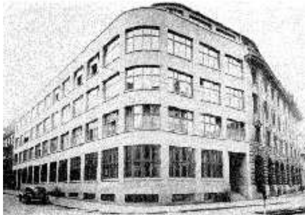
Figura 3.198: Ampliación de la central telefónica de Zurich, 1937. (Klingelfuss, 1948, p. 114)
