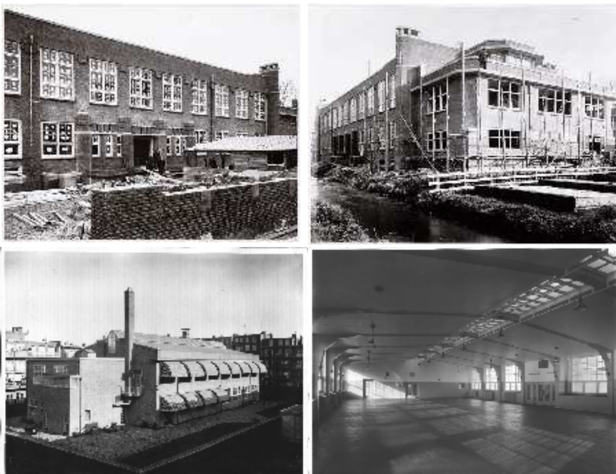
Figura 3.179: Arriba, central Amsterdam Zuid , 1921, Albert Boeken. Abajo, central Amsterdam Oost , 1923-1925, Albert Boeken. Fuente: Amsterdam Gemeentearchief .
