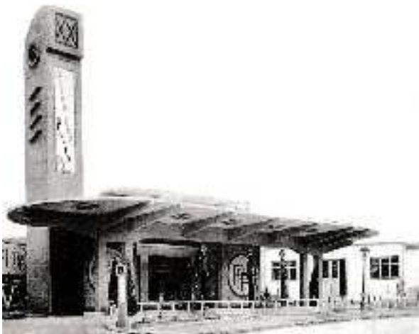
Figura 4.50: Gasolinera de "Petróleos Porto Pi", Madrid, 1927-1935, Casto Fernández Shaw. Fotografía de autor desconocido.
