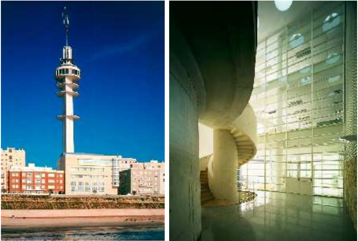
Figura 6.54: Edificio y torre de Telefónica , Cádiz, 1989-1992, Guillermo Vázquez Consuegra. El ingeniero Julio Martínez Calzón fue responsable del diseño estructural. Vista exterior desde la Playa de Santa María e interior del vestíbulo con el arranque de la escalera de caracol. Fotografías: Duccio Malagamba, Estudio Vázquez Consuegra.
