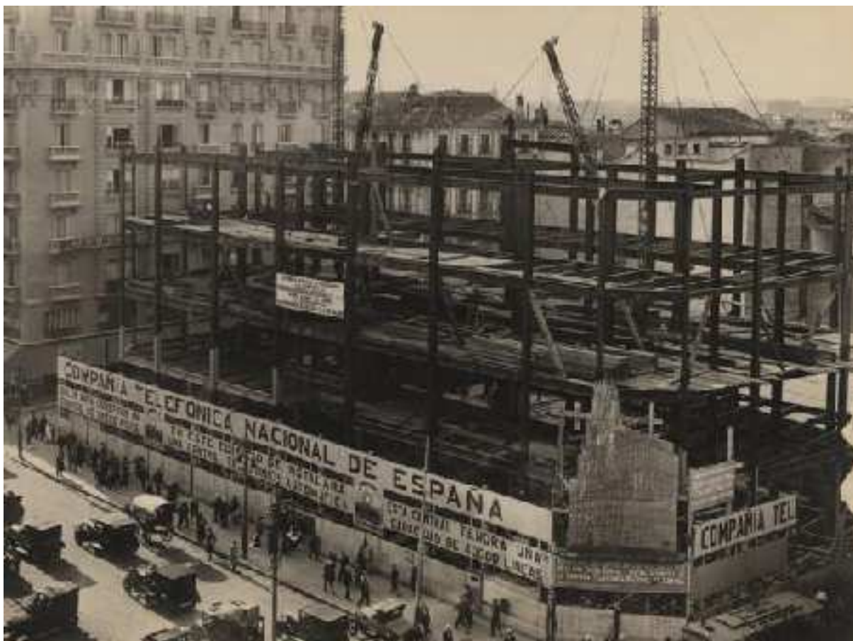
Figura 1.1: El edificio anuncio. Esta imagen, tomada por Alfonso dentro de una serie concebida con fines publicitarios, muestra la sede de Gran Vía en construcción. La valla anuncia la nueva compañía, la maravilla tecnológica que se está construyendo y la imagen final del edificio. La idea se atribuye a Kenneth McKim, primer director de publicidad de la CTNE. Archivo Histórico Fotográfico de Telefónica.
