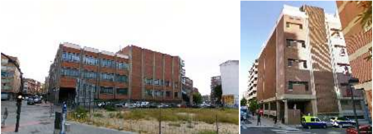
Figura 5.148: A la izquierda, Valladolid “Vadillos”, 1974, Damián Galmés de Fuentes y Manuel García Guerra. Google Street View . Derecha, Derecha, Zamora “Avenida”, 1972, mismos autores. Google Street View .
