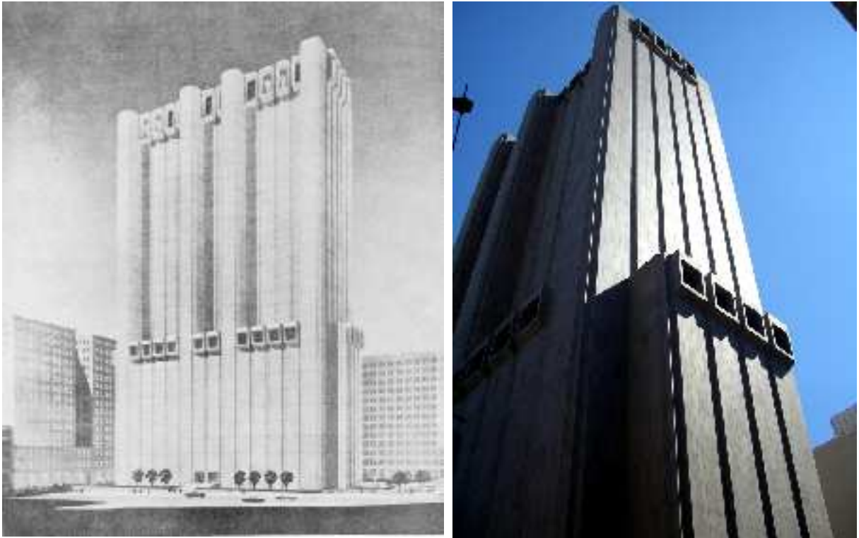
Figura 5.72: AT&T Long Lines Building, Nueva York, 1974, John Carl Warnecke & Associates. A la izquierda, un boceto publicado en el documento “Long Lines Plans for Survivable Communications”, como ejemplo de edificio diseñado para operar tras un ataque nuclear. (AT&T, 1974, p.16), cortesía del archivo histórico de AT&T. A la derecha, fotografía de 2007. De los tres cuerpos previstos, el de la izquierda no llegó a construirse. Fotografía: Lucca Zappa.
