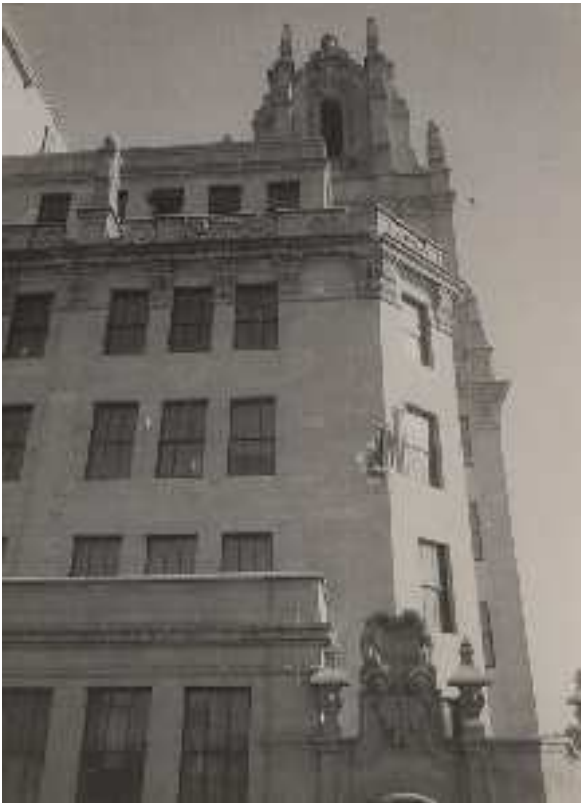
Figura 4.153: Efecto de los bombardeos en Gran Vía. Arriba, una fila de ventanas reventadas, con huellas de incendio interior. Abajo, a la izquierda, boquete en la esquina de Valverde. A la derecha, impactos próximos al balcón principal. Fuente: El Archivo Rojo, Ministerio de Cultura.
