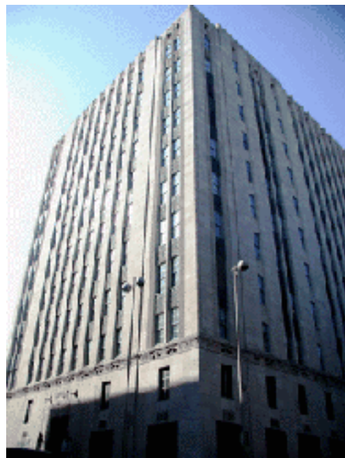
Figura 3.92: Cincinnati Bell , Elm Street , 1930, Harry Hake. Fotografía: CH Architects.
