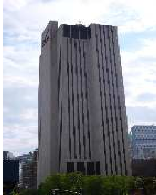
Figura 5.82: Verizon (originalmente NYTC), central de Pearl Street, Nueva York, 1972-1976, Rose, Beaton & Rose. Fotografía: Jack Cheng.
