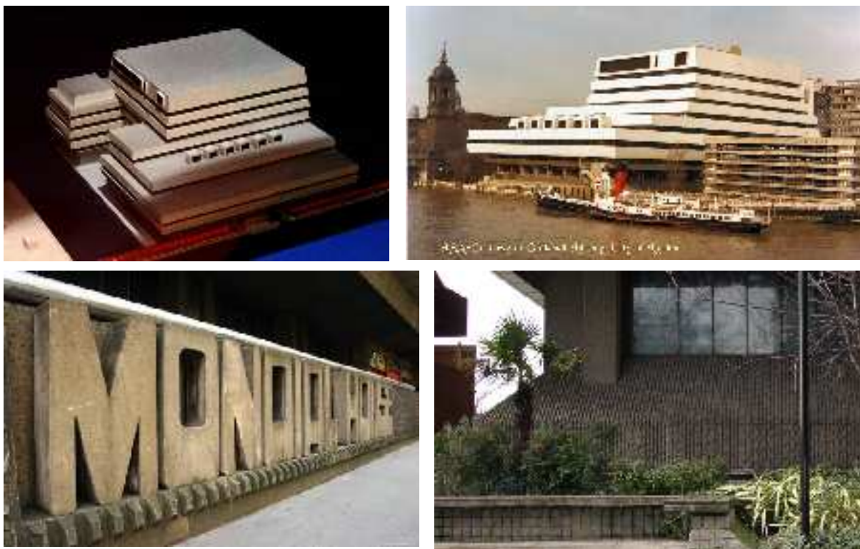
Figura 5.76: Mondial House , Londres, 1970-1975, Hubbard, Ford & Partners , Arriba a la izquierda, maqueta del proyecto de 1969, Fotografía: Paul Mison. Arriba, a la derecha, vista desde el Támesis en 1979. El edificio estaba flanqueado por las torres de la estación de ferrocarril de Cannon Street y un aparcamiento en altura demolido poco después. Fuente: Guildhall Library , reproducida en www.lighstraw.com . Debajo, dos detalles del uso decorativo del hormigón. Fuente: www.lighstraw.com
