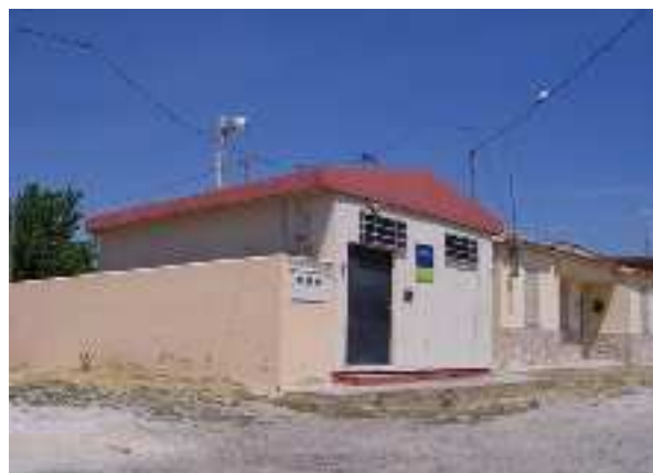
Figura 1.49: Edificio tipificado T-1 de Telefónica en Navas de San Antonio (Segovia). Colección del autor.
