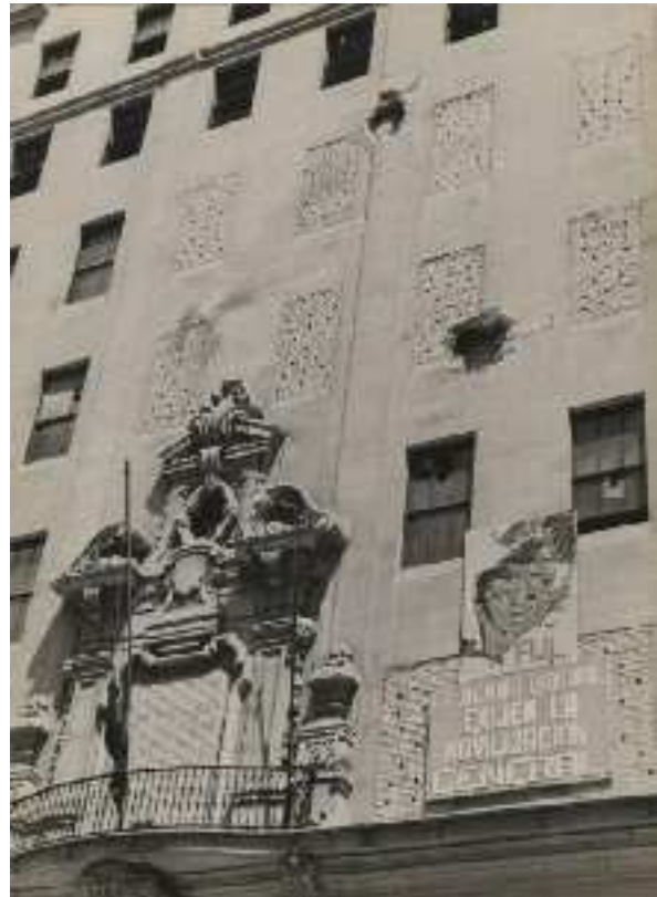
Figura 4.153: Efecto de los bombardeos en Gran Vía. Arriba, una fila de ventanas reventadas, con huellas de incendio interior. Abajo, a la izquierda, boquete en la esquina de Valverde. A la derecha, impactos próximos al balcón principal. Fuente: El Archivo Rojo, Ministerio de Cultura.
