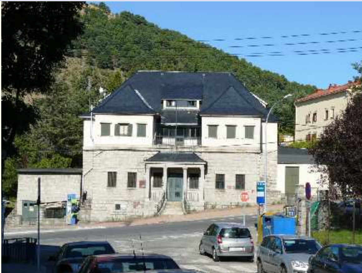
Figura 5.64: Central telefónica de San Rafael (Segovia), 1945, José María de la Vega Samper. Fotografía tomada en octubre de 2008, colección propia del autor.
