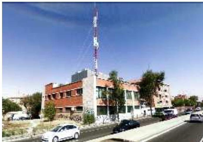
Figura 5.113: Arriba, central telefónica “Moscardó”, Madrid, 1960-1964, Francisco Riestra Limeses. Guía COAM 184 , ficha 363. Fotografía COAM. Sobre estas líneas, central “Campamento”, Madrid, 1962, Francisco Riestra Limeses. Google Street View.
