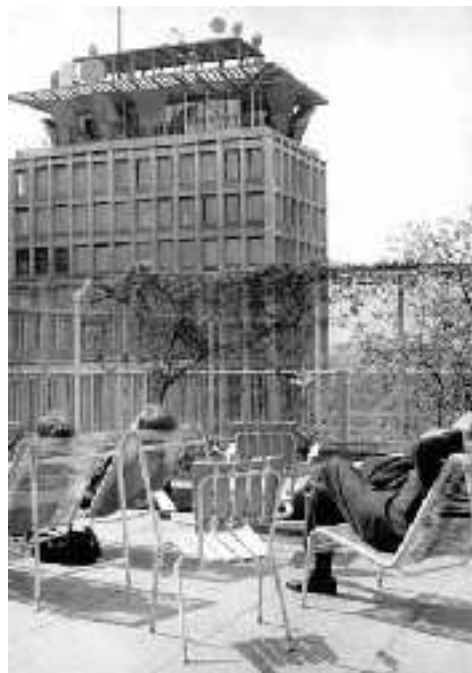
Figura 5.24: Un detalle de ortodoxia corbusieriana, el solarium en la azotea del edificio N23, anejo a la cafetería. Estaba pensado como zona de descanso. Fuente: Oberpostbaurat.
