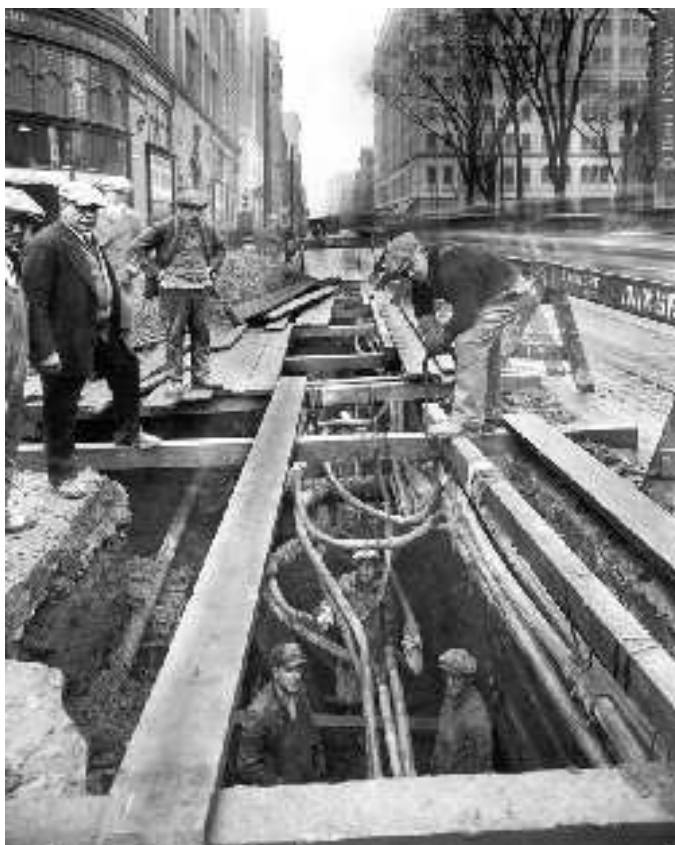
Figura 2.12: Izquierda, Instalación de cables subterráneos en Montréal, 1930. Fotografía: Millar Studio, Museo McCord. Derecha, caja de registro con un operario trabajando en su interior. Se pueden ver los conductos de cable. ( Pole , 1894, p. 258).
