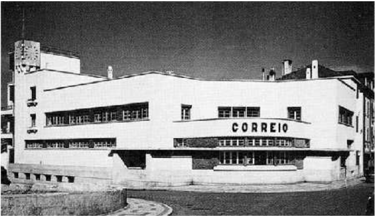
Figura 3.189: Edificios diseñados por Adelino Nunes. Arriba, sede de CTT Estoril, 1939-1942. Este edificio no es central porque el servicio lo prestaba la APT en esa ciudad. En el centro, a la izquierda, Figueira da Foz (1939-1943), a la derecha Setúbal (1937-1941). Abajo, Leiria (1938-1946). Fotografías: Fundação Calouste Gulbenkian. Plano: DOCOMOMO Ibérico. 315
