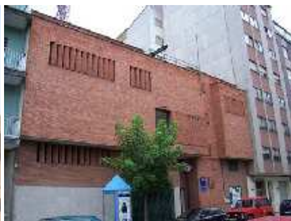
Figura 2.21: Vigas de carga y puertas de materiales. A la izquierda, en la central “Florida” de Alicante. Están situadas en un extremo de la fachada. Arriba, central de Monforte de Lemos (Lugo), 1972, Jaime Martínez Ramos y José Luis de Miguel Rodríguez. En este edificio sólo hay una puerta para dar servicio a la primera planta. El modelo de viga es normalizado para todas las centrales. En este segundo caso se observa con claridad como el hueco de la puerta no se abre en la vertical de la entrada principal, para no bloquear el acceso al edificio con las operaciones de carga y descarga. Colección propia del autor.
