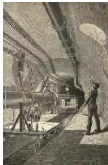
Figura 2.27: Instalación de líneas telefónicas en las cloacas de París. Colección de Jean Godi.
