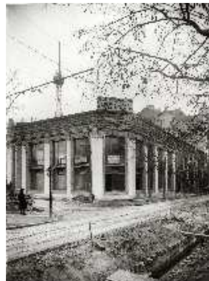
Figura 4.79: Central “Salamanca”, calle Hermosilla (Madrid), 1926, Ignacio de Cárdenas Martín. Construcción del edificio para el equipo automático y aspecto final. Se puede ver la torre metálica por la que llegaba el cableado a la vieja central manual. En la imagen de la derecha se aprecia también la zanja para la red subterránea que se construía para sustituir el sistema antiguo. Fotografías: Alfonso, Archivo Histórico Fotográfico de Telefónica.
