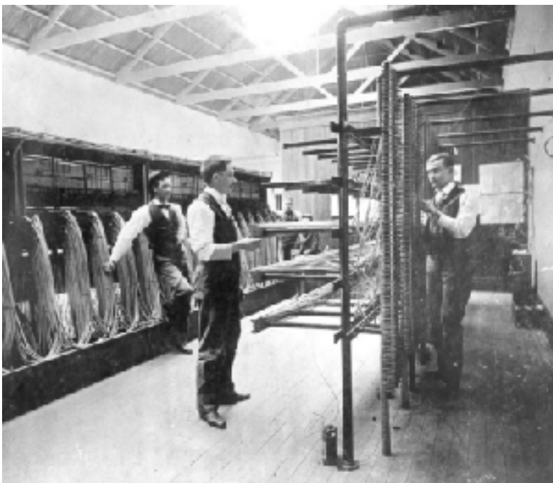
Figura 2.18. En esta imagen de principios del siglo XX, unos operarios están empezando a trabajar en un pequeño repartidor, aun prácticamente vacío de cables. A la izquierda están los equipos de conmutación manual abiertos. Fotografía de autor desconocido.
