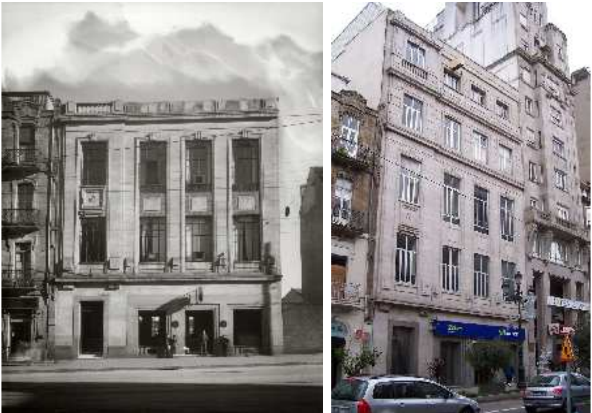
Figura 4.88: Central telefónica, Vigo, avenida Urzáiz, 1929, José María de la Vega Samper. A la izquierda, imagen de la época de la construcción ( Archivo Histórico Fotográfico de Telefónica ); a la derecha, aspecto en diciembre de 2006 ( Colección propia del autor ).
