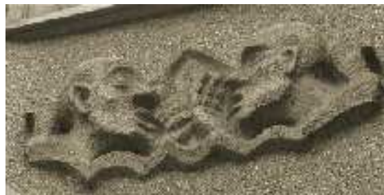
Figura 3.177: Arriba, sala de descanso de la Winterfeldtstrasse . Abajo, detalle decorativo en la central Elberfeld , Wuppertal (Alemania), 1928.
