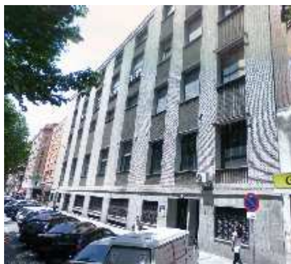
Figura 5.104: Central “Peñuelas”, Madrid, 1971, José María de la Vega Samper y Paulino J. Gayo Notario. Google Street View.
