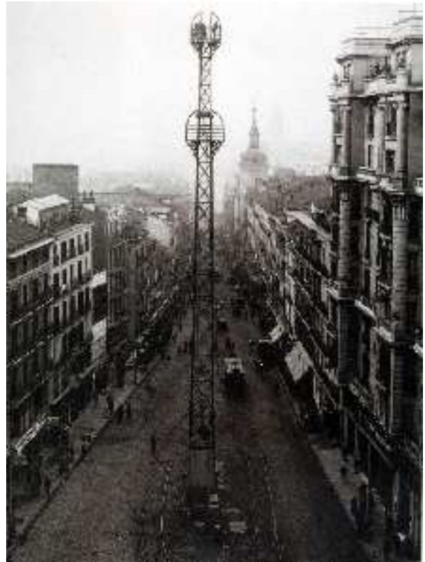
Figura 4.39: Desmontaje de la torre metálica de la Red de San Luis de Madrid, 1929. Fotografía: Alfonso. Archivo Histórico Fotográfico de Telefónica.
