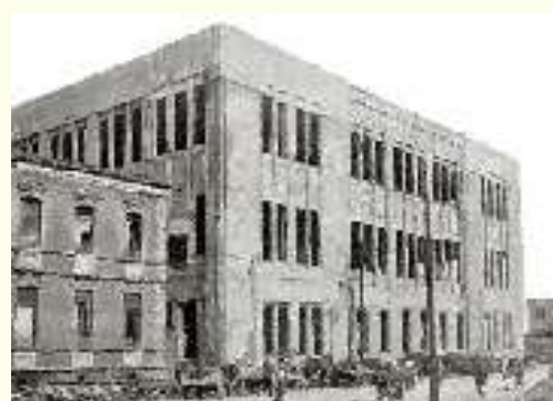
Figura 2.40: Interior y exterior de la central Hamacho de Tokyo, un edificio moderno de estructura de hormigón, cuyo equipo se perdió por el incendio.
