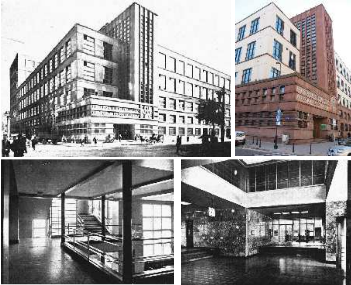
Figura 3.202: Edificio de telecomunicaciones de Varsovia (Polonia), 1928-1924, Julian Puterman. Arriba, vista general en 1934 y en la actualidad. Abajo, detalle de uno de los pasillos y del vestíbulo principal. Las fotografías aparecen en el artículo de Puterman de 1934, excepto la actual, de Colin Rose.
