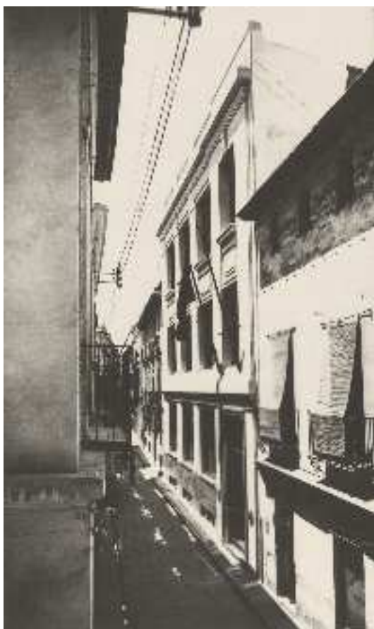
Figura 4.125: Central telefónica, Murcia, 1929, Ignacio de Cárdenas Pastor. Archivo Histórico Fotográfico de Telefónica.
