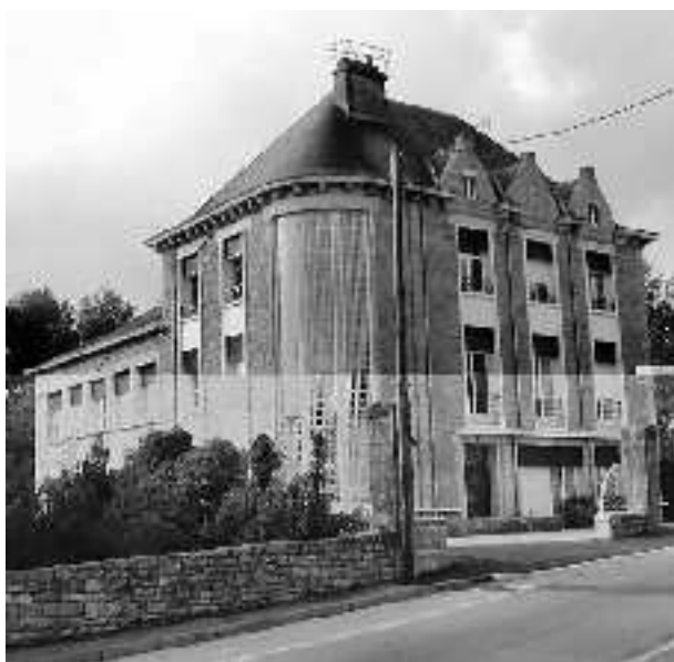
Figura 3.169: Arriba a la izquierda, central de Angers (Francia), 1928, Auguste Labussière y Reby Marcel. Edificio de hormigón y ladrillo de tendencia expresionista.
