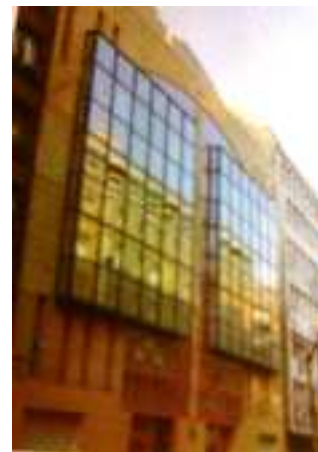
Figura 6.40: Centro de Proceso de Datos, Bilbao, 1984. Carlos Lázaro Intxausti.
