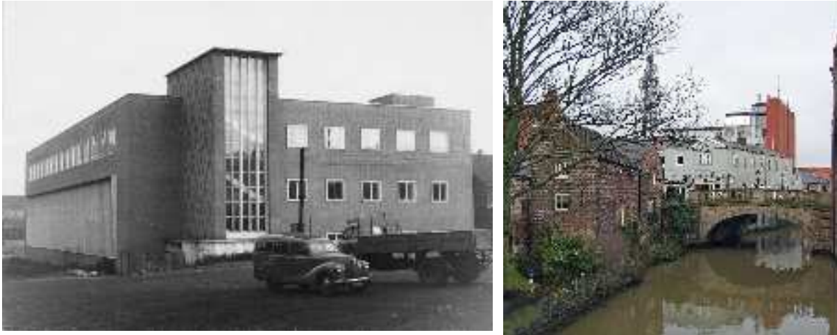
Figura 5.27: Central Stonebow , York (Inglaterra), A. Lloyd Spencer, 1950-1955. La fotografía fue tomada en 1958 y pertenece al archivo de la ciudad de York. Con los años, ha experimentado múltiples ampliaciones. En la imagen de la derecha se ve su aspecto actual, en medio de un caserío tradicional. Fotografía: Michael Wilson.
