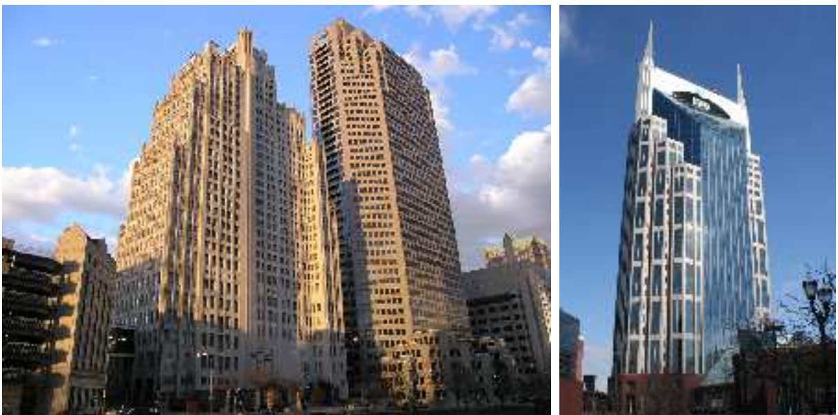
Figura 6.9: Izquierda, AT&T Center (en origen, One Bell Center ), St. Louis (Missouri, EEUU), 1986, Hellmuth, Obata & Kassabaum , junto al Bell Building de 1925. Fotografía de autor desconocido. Derecha, BellSouth Building , Nashville (Tennessee, EEUU), 1994, Earl Swensson Associates . La imagen es posterior a 2006, el emblema de BellSouth ha sido sustituido por el de AT&T . Fotografía: Wikimedia Commons .
