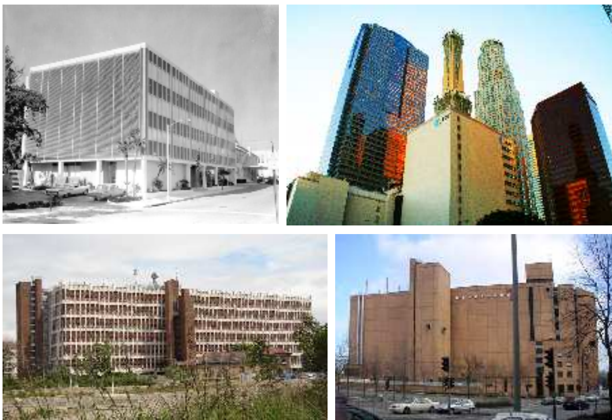
Figura 5.65: Arriba, a la izquierda, central de GTE en Ocala, Florida (EEUU), 1965. Fuente: State Library and Archives of Florida . A la derecha, central de AT&T en el Downtown de Los Angeles (EEUU), 1961, Donald D. Parkinson, John D. Parkinson. Fotografía: Kenneth Han . Fuente: Wikimedia Commons . Abajo, a la izquierda, central Lacassagne, Lyon (Francia), 1972, André Gutton, Fuente: Rues de Lyon . Abajo, a la derecha, central telefónica en Hamburgo (Alemania), 1978. Fotografía de autor desconocido.
