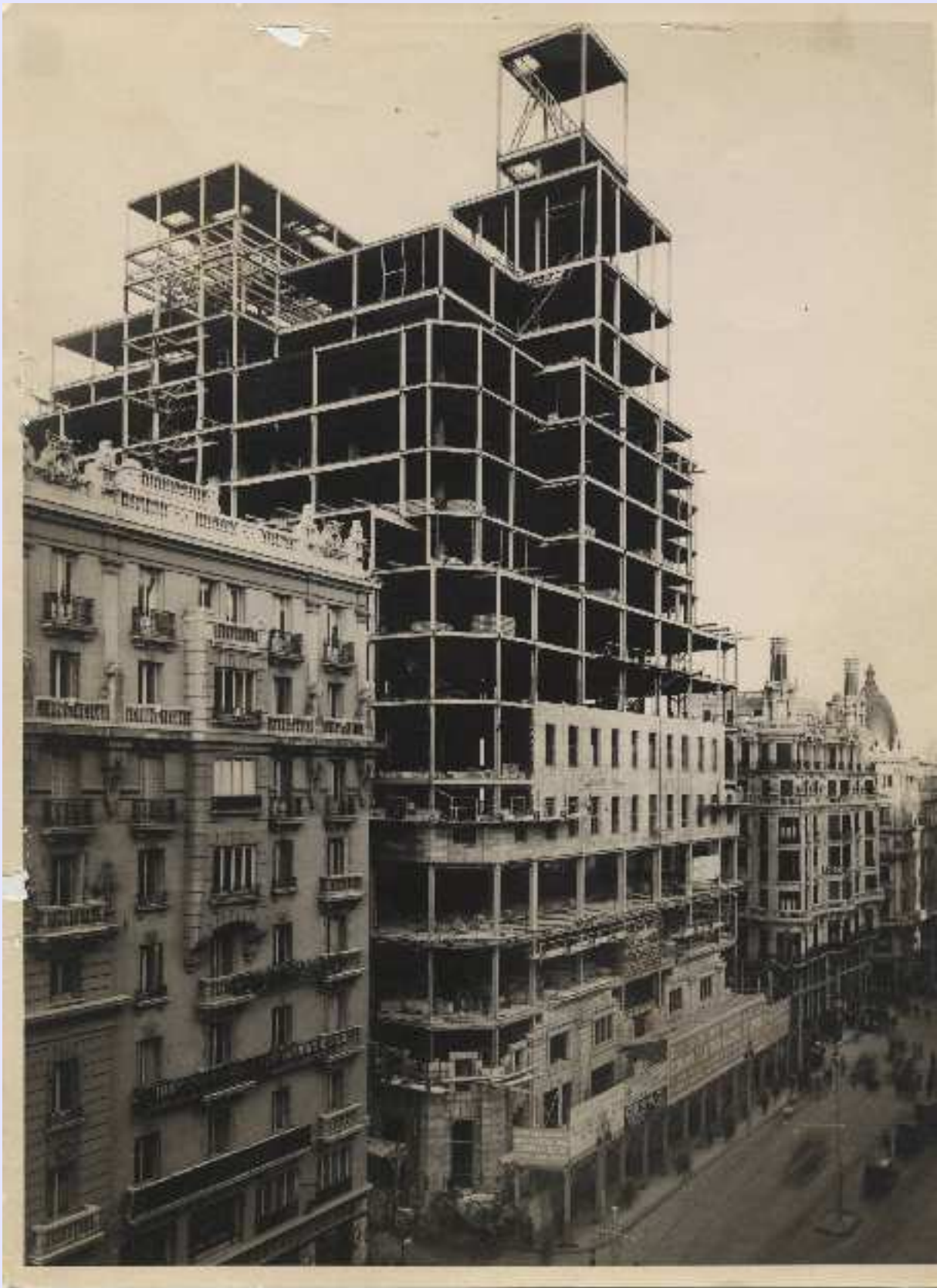
"Como floración que el sol del verano alienta y fecunda, el edificio de la Telefónica se adorna todos los días con un nuevo piso de ramaje de hierro, apareciendo esa gran araucaria japonesa que es como un esqueleto de pagoda en construcción moderna. Los que han salido en el ómnibus del '¡Adiós Madrid, que te quedas sin gente!', cuando vuelven se encuentran con varios rascacielos, nidos de máquinas de escribir, atalayadores del negocio, archivadores automáticos del mundo". Ramón Gomez de la Serna. "Elucidario de Madrid", 1931. Fotografía de Alfonso, enero de 1928, Archivo Histórico Fotográfico de Telefónica.
