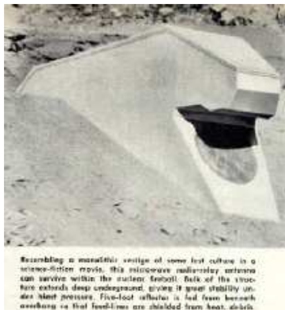
Figura 5.71: Antena de microondas de un repetidor subterráneo. Estética y retórica para una situación inimaginable. (AT&T, 1969, p. 43)
