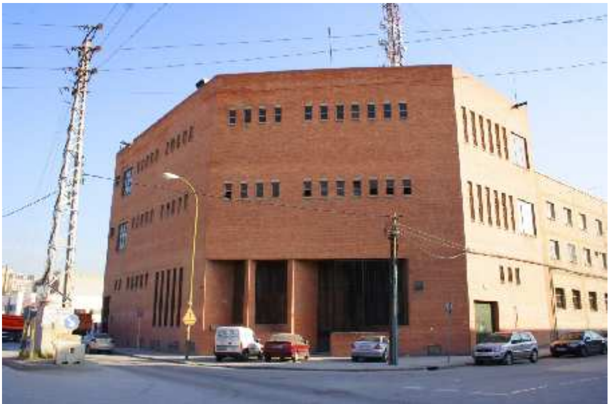
Figura 5.177: Arriba, central telefónica "Moratalaz", Madrid, 1968-1970, Dionisio Hernández Gil y Juan Antonio Ridruejo Brieva. Guía COAM, ficha 262. Colección propia del autor. Abajo, central telefónica "San Dalmacio", Madrid, 1967-1969, Dionisio Hernández Gil y Juan Antonio Ridruejo Brieva. Guía COAM, ficha 370. Fotografía COAM.
