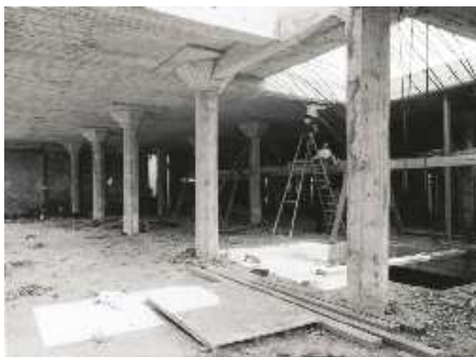
Figura 4.107: En esta fotografía de Claret, de 1927, se ve la estructura de hormigón en las obras de la central de Clot. Archivo Histórico Fotográfico de Telefónica.
