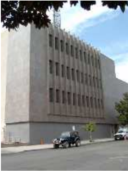
Figura 5.36: Central de Modesto (California), 1949, Clarence Peterson y Wendell Spackman. Fotografía: Bob Barzan.
