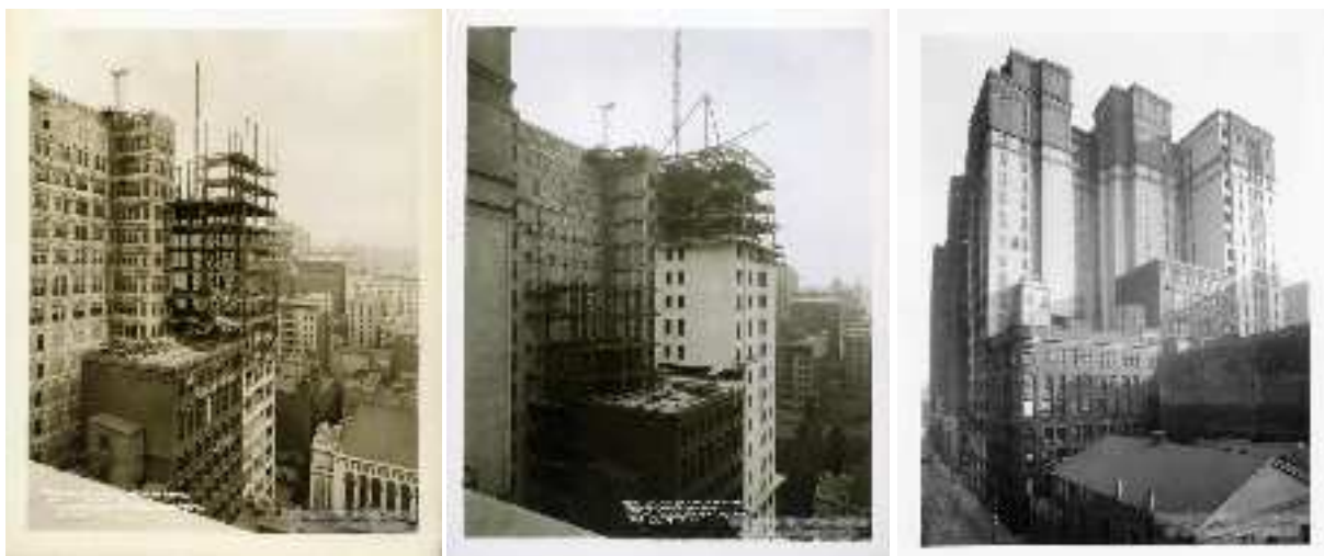
Figura 2.33: Ampliación de una central en Pittsburgh (1929-1931). Frederick F. Osterling proyectó la central primitiva en estilo neorrománico en los años noventa del siglo XIX. En 1929 comenzaron las obras para construir un nuevo edificio de gran porte del arquitecto John T. Windrim 38 . La empresa constructora, Trimbley Co. , llevó a cabo un registro fotográfico de los trabajos. Estas tres instantáneas muestran dos momentos intermedios y el resultado final, con el edificio de Osterling abajo a la izquierda. Fuente: University of Pittsburgh, Digital Research Library .
