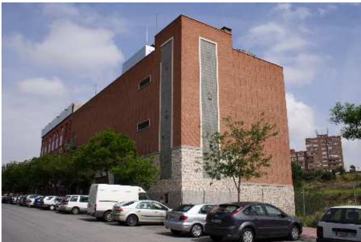
Figura 5.103: Central telefónica de Vicálvaro (Madrid), 1971, José María de la Vega Samper. Fotografía: COAM.
