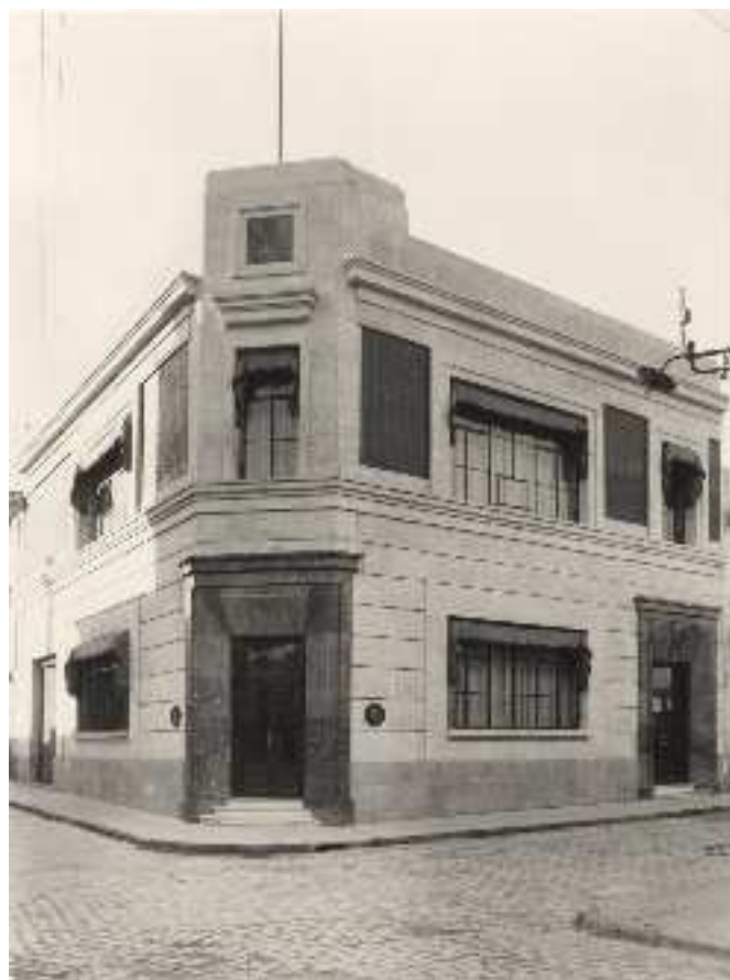
Figura 4.130: Central telefónica, Castellón, 1935, Archivo Histórico Fotográfico de Telefónica.
