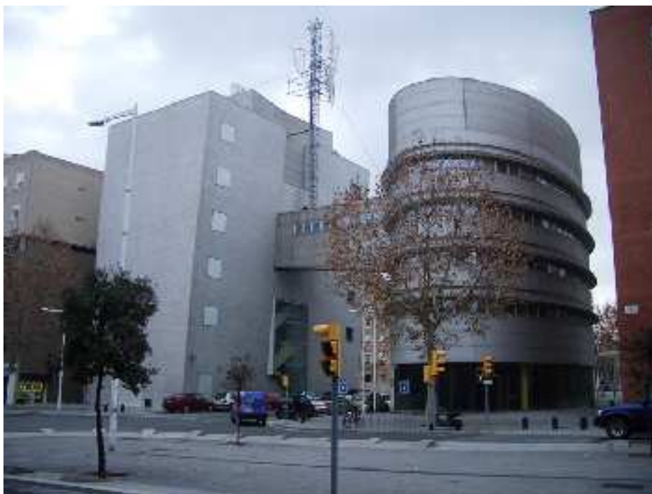
Figura 6.51: Central telefónica de la Villa Olímpica, calle Joan d'Àustria Barcelona, 1989-1992, Jaume Bach y Gabriel Mora. Fotografía de autor desconocido. Fuente: descobrisanmarti.org
