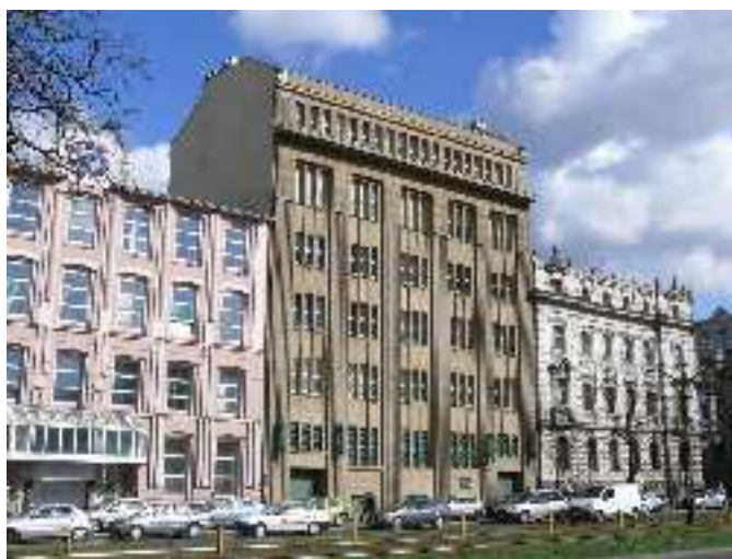
Figura 3.201: Central telefónica de Lodz (Polonia), 1927-1928, Jozef Kaban. Fue la primera del país con equipo automático. Fuente: Wikimedia Commons .
