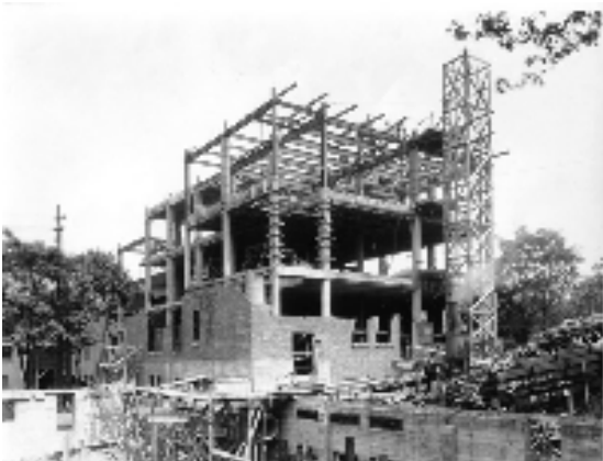
Figura 2.36: Battle Creek, Michigan, 1926. Montaje de la estructura metálica en una pequeña central. Fuente: Willard Library
