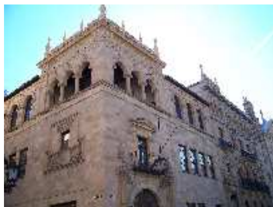
Figura 4.84: Salamanca, julio de 2006, con la galería sobre la calle del Concejo que se construyó después. Colección propia del autor.
