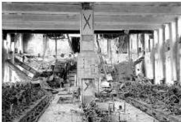
Figura 5.22: Arriba, Sala de conmutación de la antigua central de Fráncfort tras un bombardeo en abril de 1944. Fuente: Oberpostbaurat . Izquierda, Fernmeldehochhaus , Fráncfort (Alemania), 1951-1956, Heinrich Ebert. En esta vista cenital se ve la torre oeste y el cuerpo principal. En primer plano, el patio y entrada restaurados del palacio Thurn und Taxis . Todavía se ven escombros de las construcciones anteriores. Fuente: Oberpostbaurat
