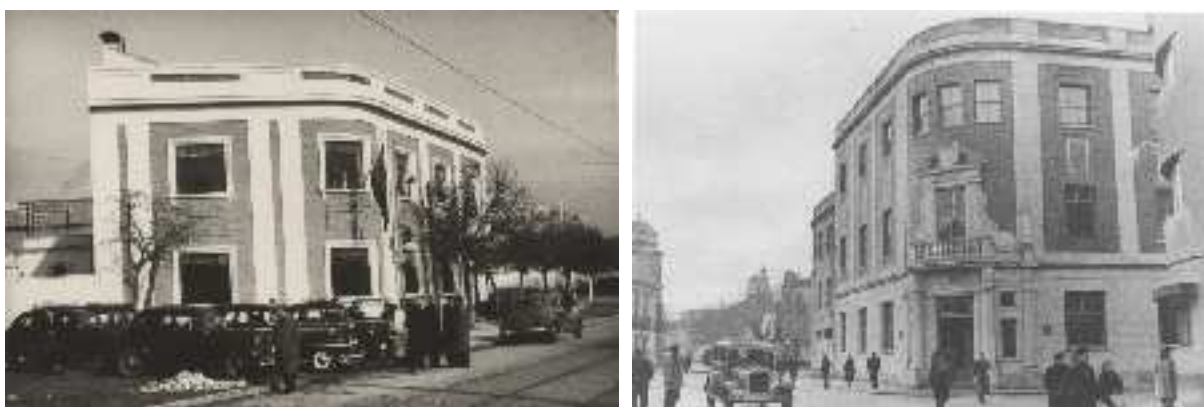
Figura 5.54: Izquierda, Central de Carabanchel (Madrid), 1949, Departamento de Edificaciones. Derecha, central telefónica "Imperio" de Ciudad Real, plaza de Cervantes, 1953, José María de la Vega Samper. Archivo Histórico Fotográfico de Telefónica.
