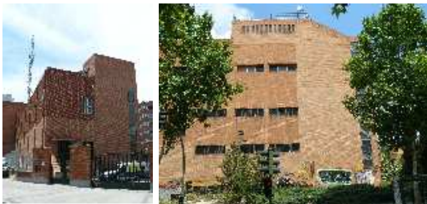
Figura 5.124: “Bellas Vistas”, Madrid, 1966, Julio Cano Lasso, Estado en mayo de 2011. Se distinguen con facilidad las ampliaciones por el distinto tono del ladrillo Colección propia del autor.
