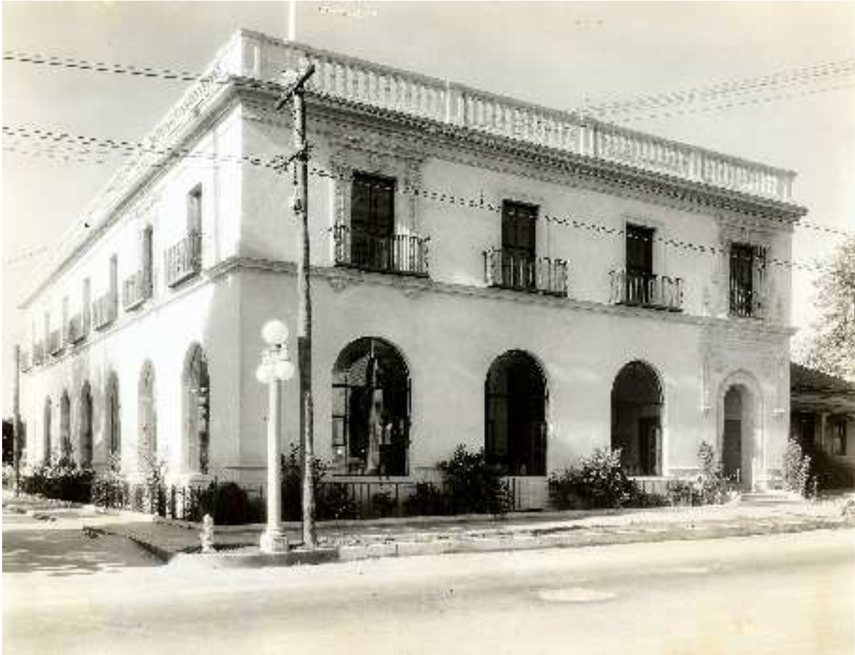
Figura 3.104: AT&T Toll Building, San Bernardino (California), 1930, no constan datos de autoría. Cortesía del archivo histórico de AT&T.
