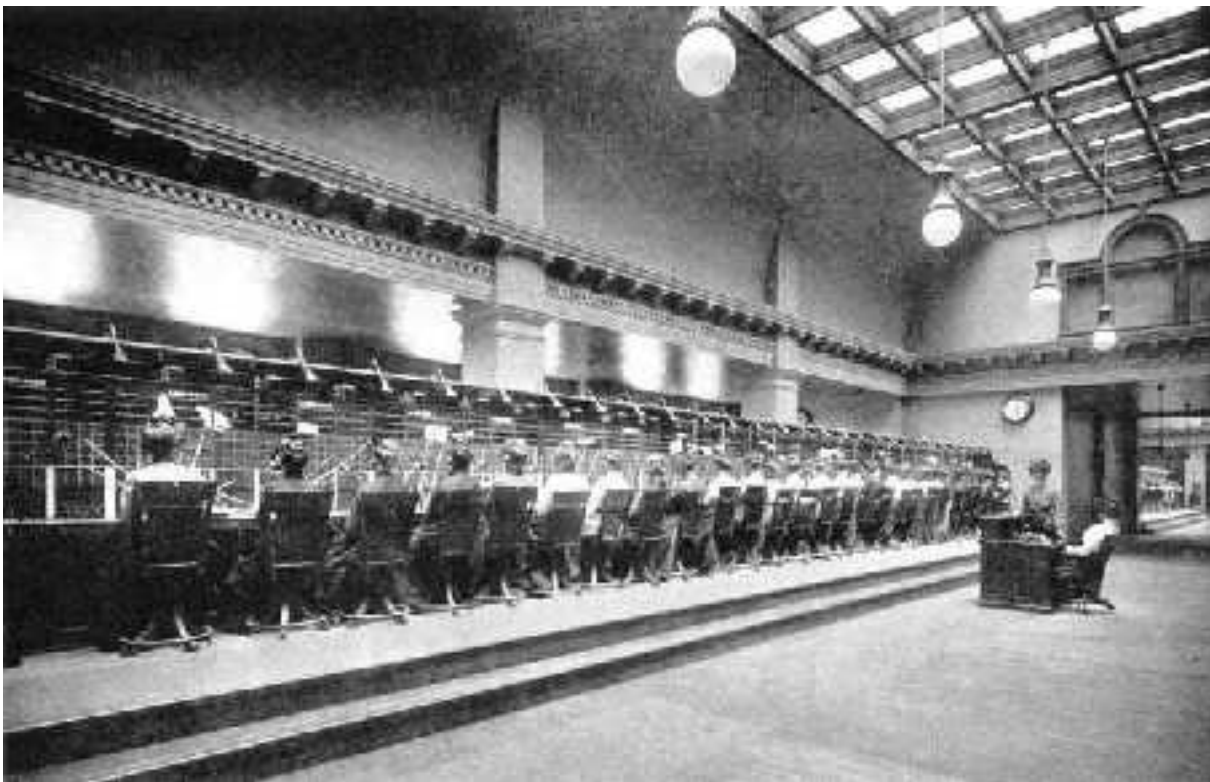
Figura 3.1: Interior de una gran central en Cleveland (Ohio), a principios del siglo XX. Orden, limpieza y buena iluminación natural para facilitar la labor de las operadoras. “ Cyclopedia of Telephony & Telegraphy ”, Chicago, 1919
