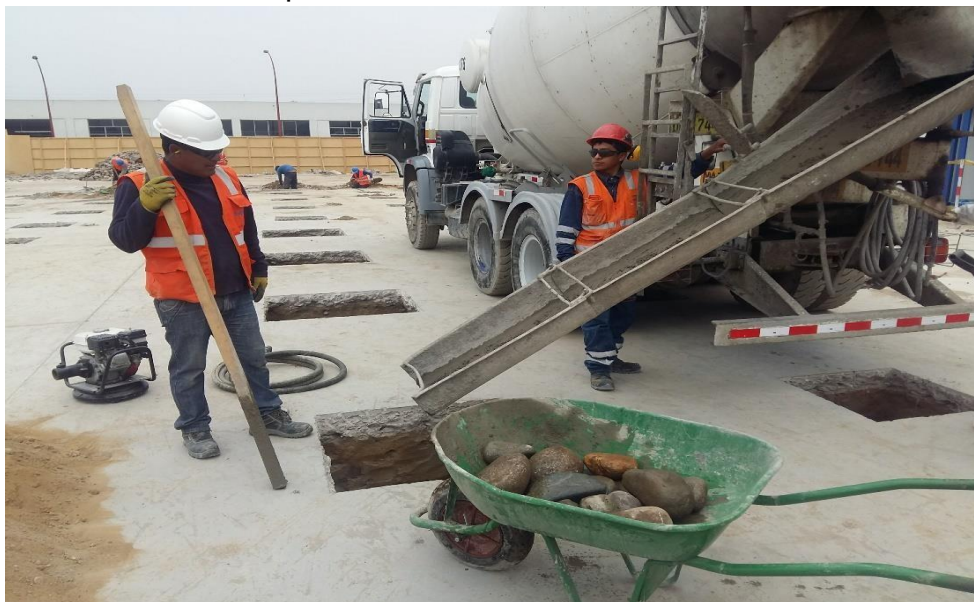
Figura 2 Vaciado de zapatas
