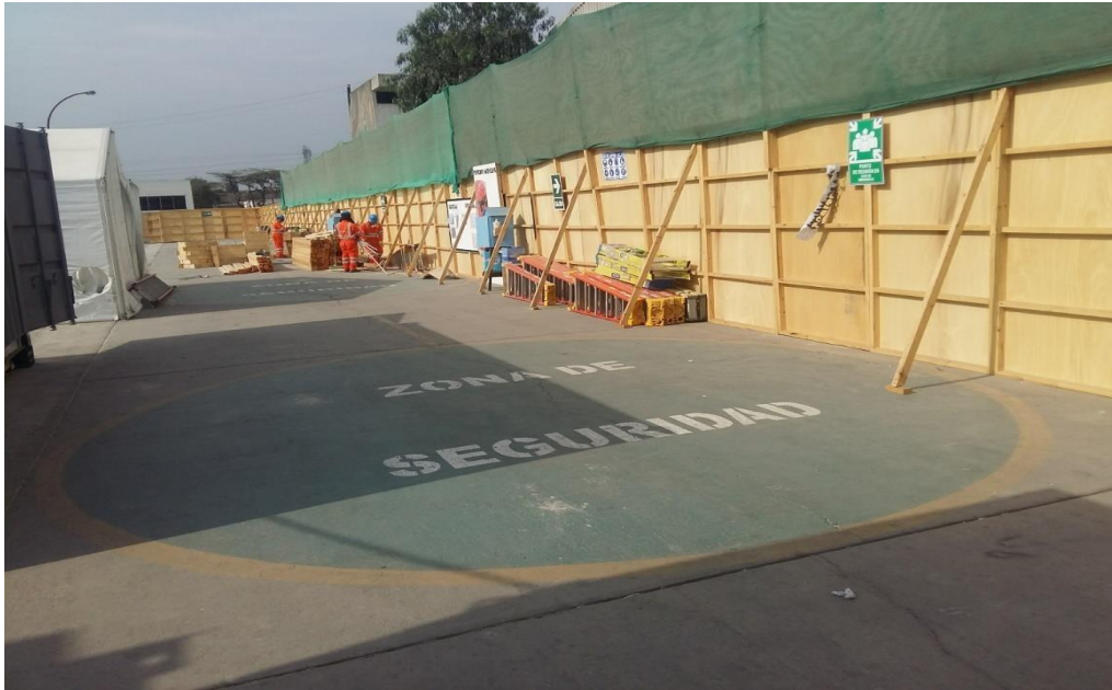
Figura 1 Ejecución de la instalación
