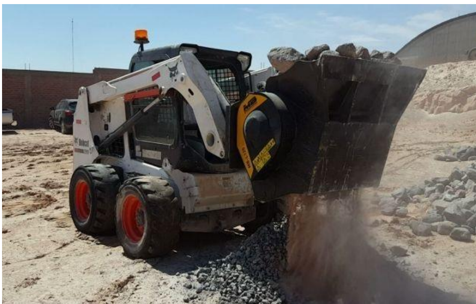
Figura 4 Maquinaria pesada en plena ejecución de trabajo
