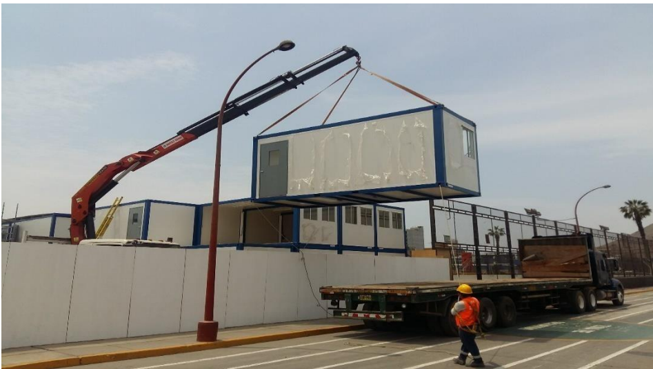
Figura 3 Instalación de bloques de habitación
