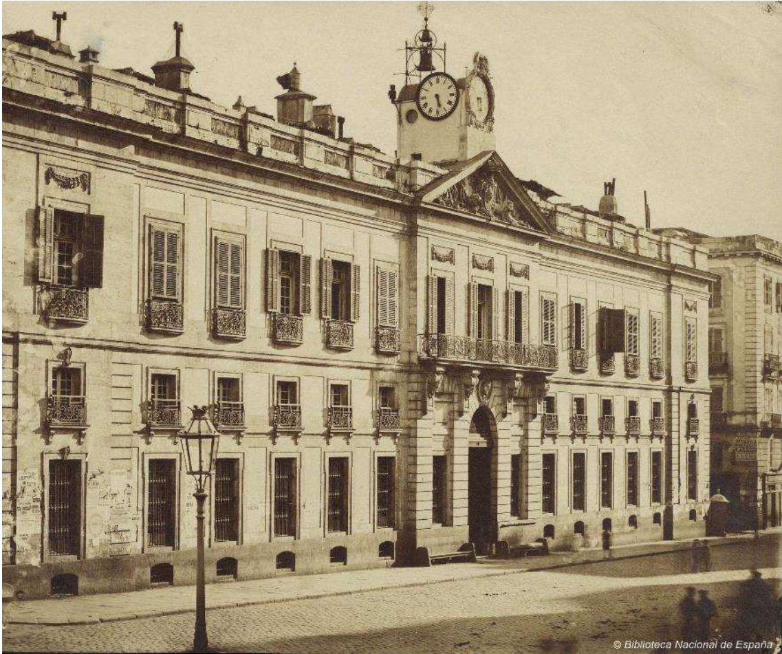
Lámina 61. Anónimo, Fachada del edificio de Gobernación en la Plaza del Sol , Madrid, h. 1860, papel albúmina (Biblioteca Nacional de España).
