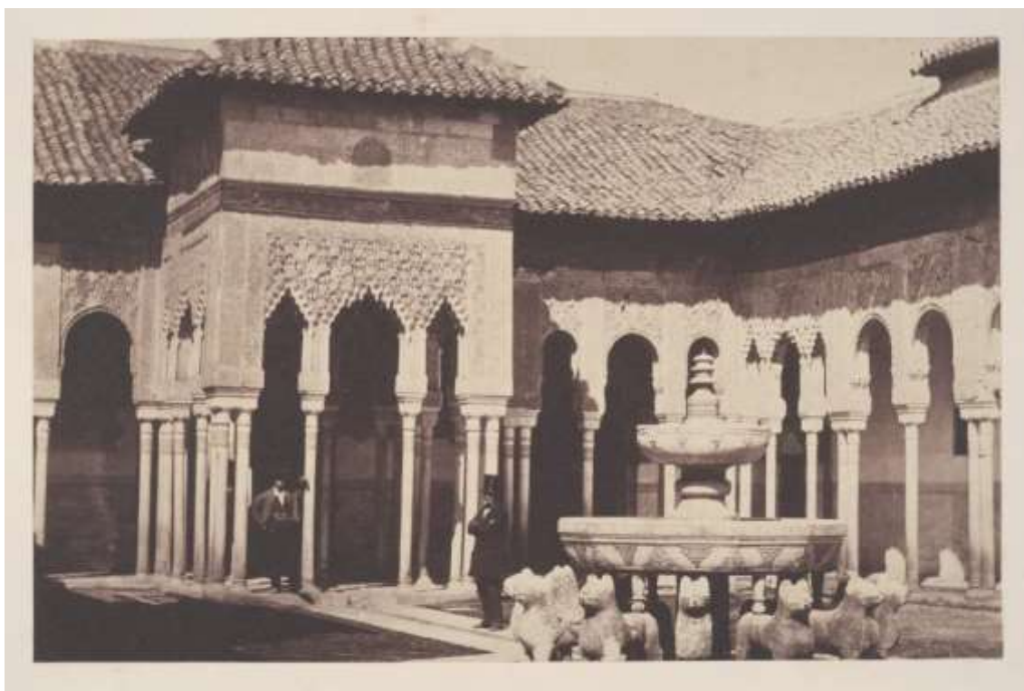
Lámina 14. John Gregory Crace, El Patio de los Leones de la Alhambra , Granada, 1855, papel albúmina (The Metropolitan Museum of Art).
