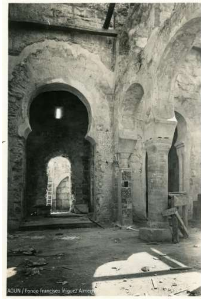
Lámina 186. ¿Francisco Íñiguez Almech?, Vista interior de la iglesia del Monasterio de Suso durante la restauración , San Millán de la Cogolla, h. 1934-1935, copia positiva de época (Fondo Francisco Íñiguez Almech, AGUN).
