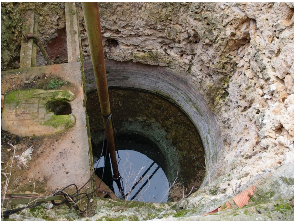
Fig. 5. Ejemplo del interior de un pozo, donde se puede apreciar el nivel freático y el paquete de calizas.
