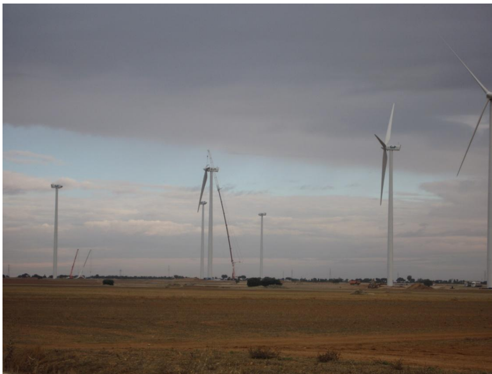
Fig. 33. Construcción del un parque eólico (Fecha: 08/10/2010).
