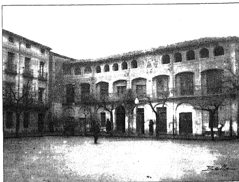
Foto 10. Antiguo Ayuntamiento de Calaborra situado en la Plaza del Raso.
