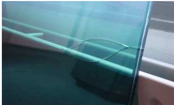
Figura 3.4.2: Rotura vidrio por choque térmico
