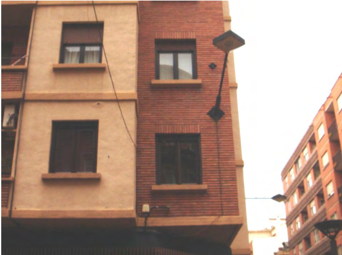
Lám. 409. Edificio de viviendas, c/ Doctores Castroviejo 16, detalle de fachada, Logroño, J. Carceller 1960
