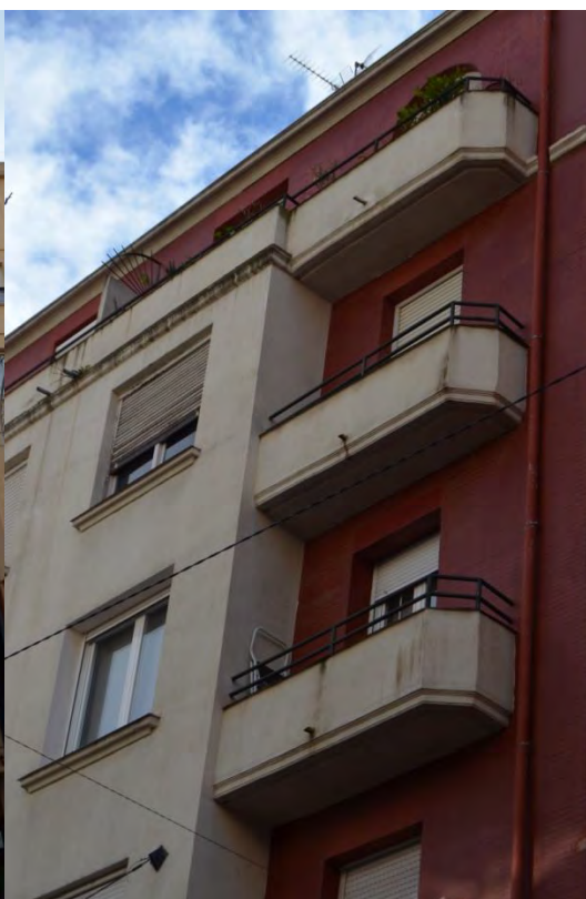
Lám. 161. Edificio de 19 viviendas y locales, c/ Doctores Castroviejo 36, detalle fachada, Logroño. L. González. 1953
