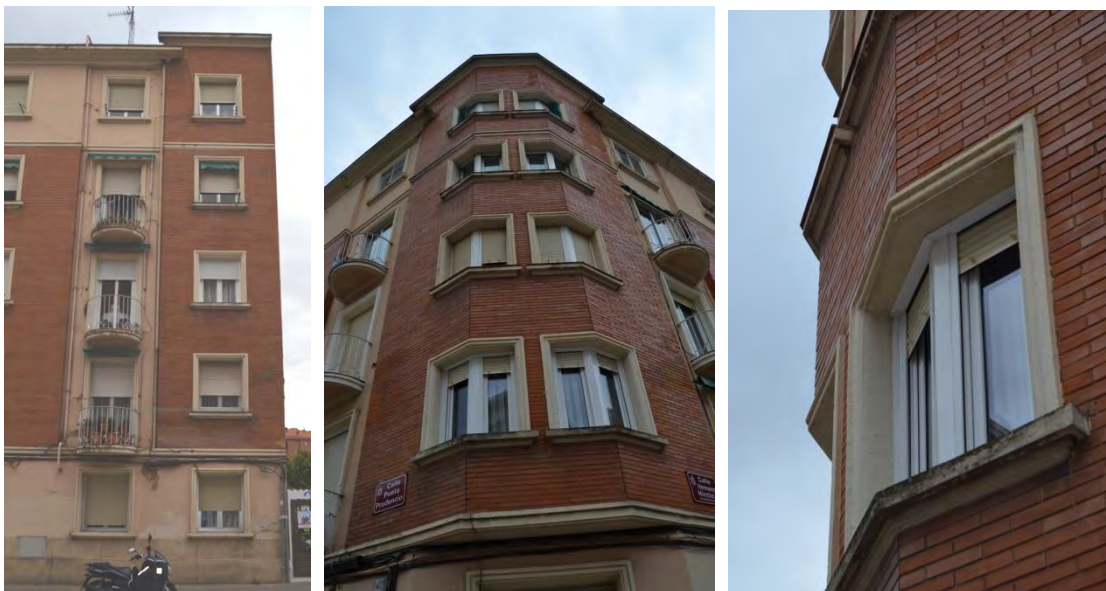
Lam. 223. Edificio de 45 viviendas, calles Hermanos Hircio 3 y Poeta Prudencio 16-18, detalles de fachada, Logroño, J. M a Carreras y R. Fontán 1955 (AML PU 122/1955)
