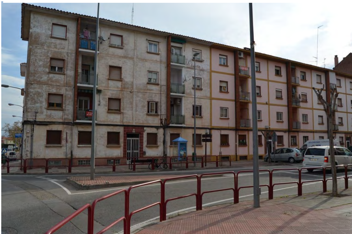
Lám. 398. 72 viviendas en 3 bloques, C/ Piqueras 101 a 105 y c/ C Cerezos 1 a 6, fachada del bloque de la calle Piqueras, Logroño, F. Ruiz Río 1959
