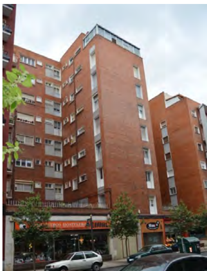
Lám. 390. Edificio de viviendas, c/ Huesca 11, Logroño, R. Gil Albarellos 1959
