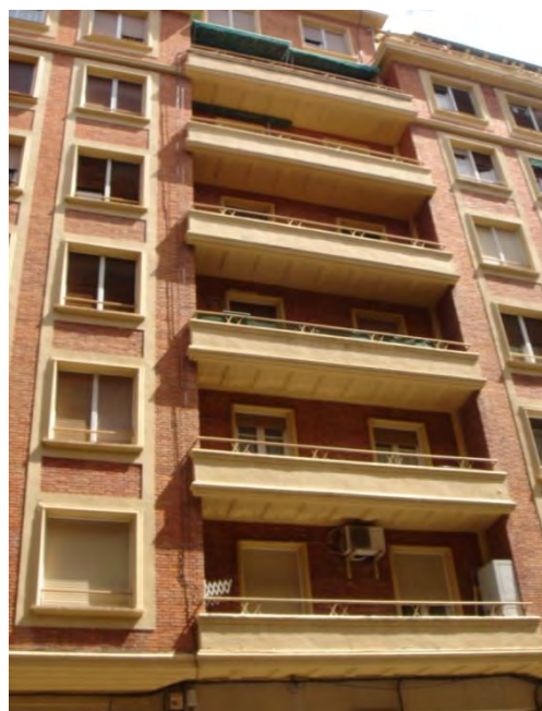
Lám. 163. Edificio de viviendas, c/ General Vara de Rey 48, detalle de fachada, Logroño, J. Carceller, 1954
