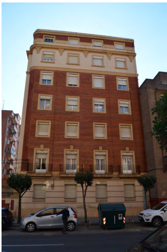
Lam. 121. Grupo de 114 viviendas en 4 bloques, C/ Duquesa de la Victoria 74-80 y Pdre Claret 5-7 y 6-8, detalles de fachada, Logroño, A. Cadarso del Pueyo. 1949
