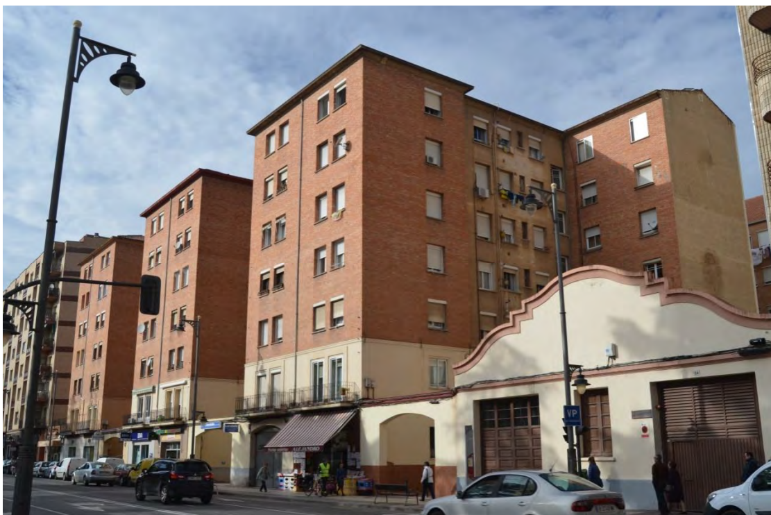
Lám. 114. Grupo de 72 viviendas en calle Marqués de Murrieta 56-60, Logroño, E. de Calonge, 1949
