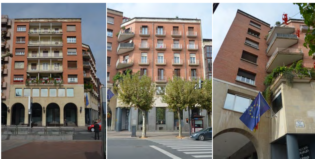
Lám. 419. Edificio de viviendas, c/ Muro del Carmen 1, fachadas a Muro de la Mata, Muro del Carmen y detalle de la esquina, Logroño, L. González 1961.
