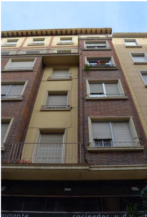
Lám. 287. Edificio de 30 viviendas, c/ Huesca 2-4, detalle de fachada, Logroño, J. M a . Carreras y R. Fontán, Logroño 1957
