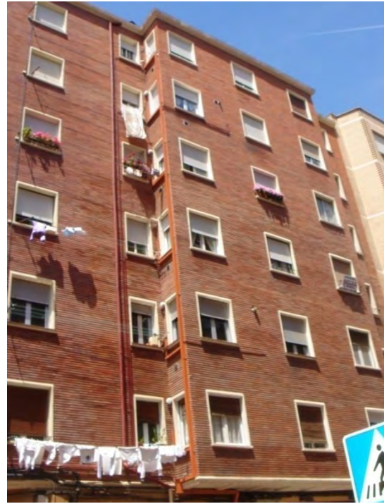
Lám. 333. Edificio de viviendas, a/ Pérez Galdós 74, fachada a c/ Vélez de Guevara, Logroño, J. Carceller 1958
