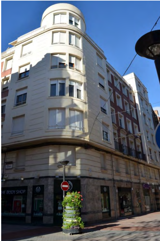
Lám. 89. Edificio de 24 viviendas, c/ Calvo Sotelo 13 y a/ Juan XXIII 6, vista desde A/Juan XXIII, Logroño, A. del Valle, 1947
