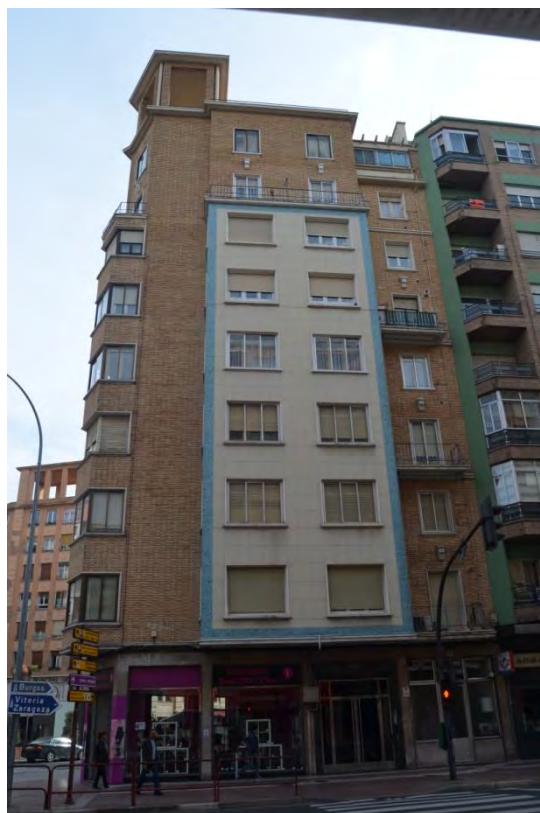
Lám. 364. Edificio de viviendas, vista frontal desde General Vara de Rey, Logroño. J. M a . Carreras y R. Fontán 1958
