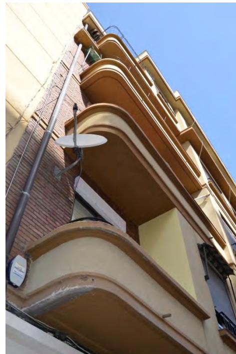
Lam. 249. Edificio de 12 viviendas, a/ Doce Ligeros de Artillería 3, detalle de fachada, Logroño, L. González, Logroño 1955
