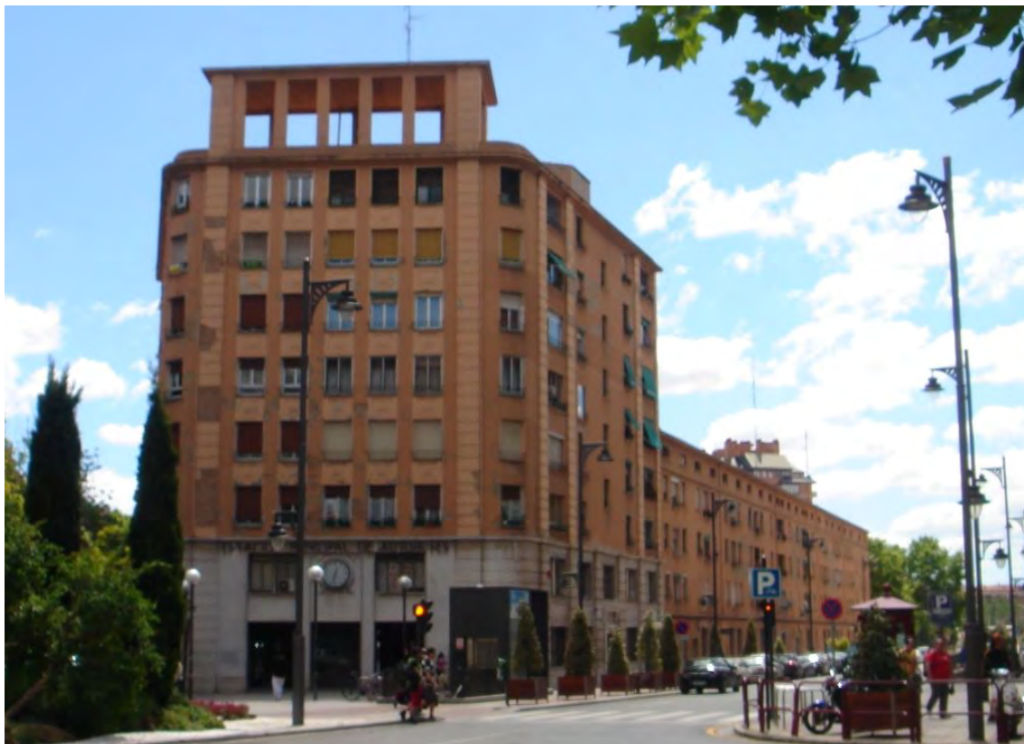
Lám.109. Edificio de viviendas y Estación de autobuses, A/ España 1 a 11 y A/ Pío XII 2 a 10, , Logroño, J. Carceller y Luis González, 1949
