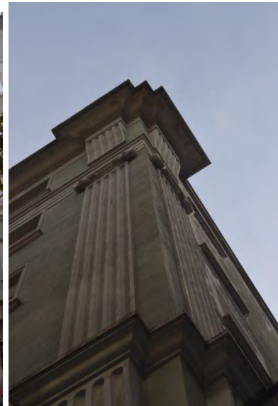
Lám. 50. Edificio de 16 viviendas, tiendas y oficinas, c/ Hermanos Moroy 1, detalle de fachada, Logroño, L. González, 1946.
