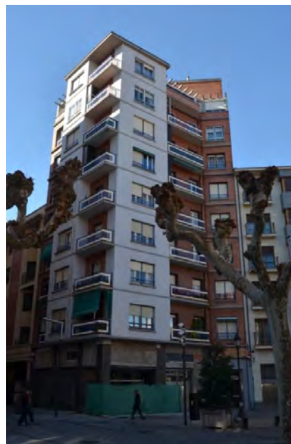
Lám. 446. Edificio de viviendas, c/ Once de junio 1, Logroño, A. Fernández Ruiz-Navarro
