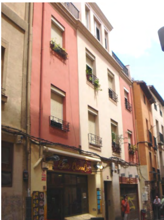
Lám. 19. Edificio de 6 viviendas, c/ Laurel 22, Logroño, J. Carceller 1953
