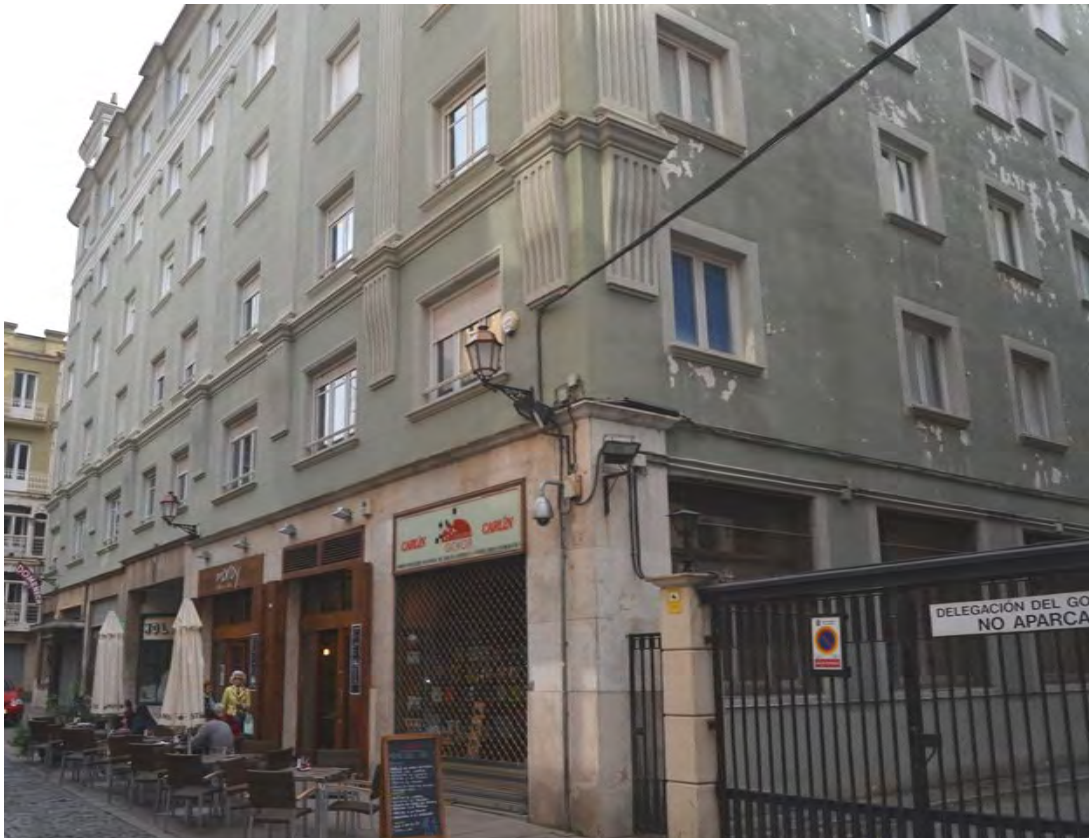
Lám. 12. Edificio de 16 viviendas, tiendas y oficinas, c/ Hermanos Moroy 1 esquina Marqués de Vallejo y fachada a Hermanos Moroy, Logroño, L. González, 1946.
