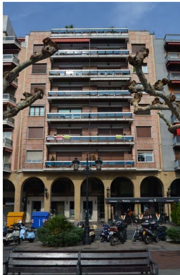
Lám. 412. Edificio de viviendas, c/ Muro de la Mata 6, Logroño, F. del Valle 1960
