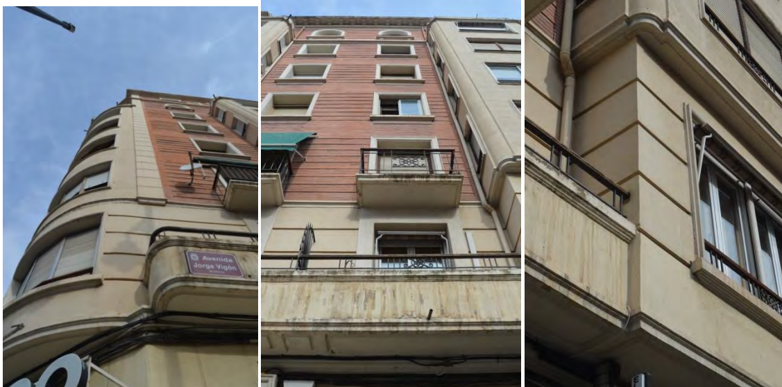
Lám. 98. Edificio de 24 vivienda y almacenes, a/ Jorge Vigón 1 y c/ General Vara de Rey 17, detalles de fachada, Logroño, J. M a Carreras y R. Fontán 1947
