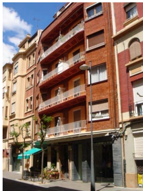
Lám. 180. Edificio de viviendas, c/ García Morato 4, vista desde la calle Logroño, J. Carceller. 1954
