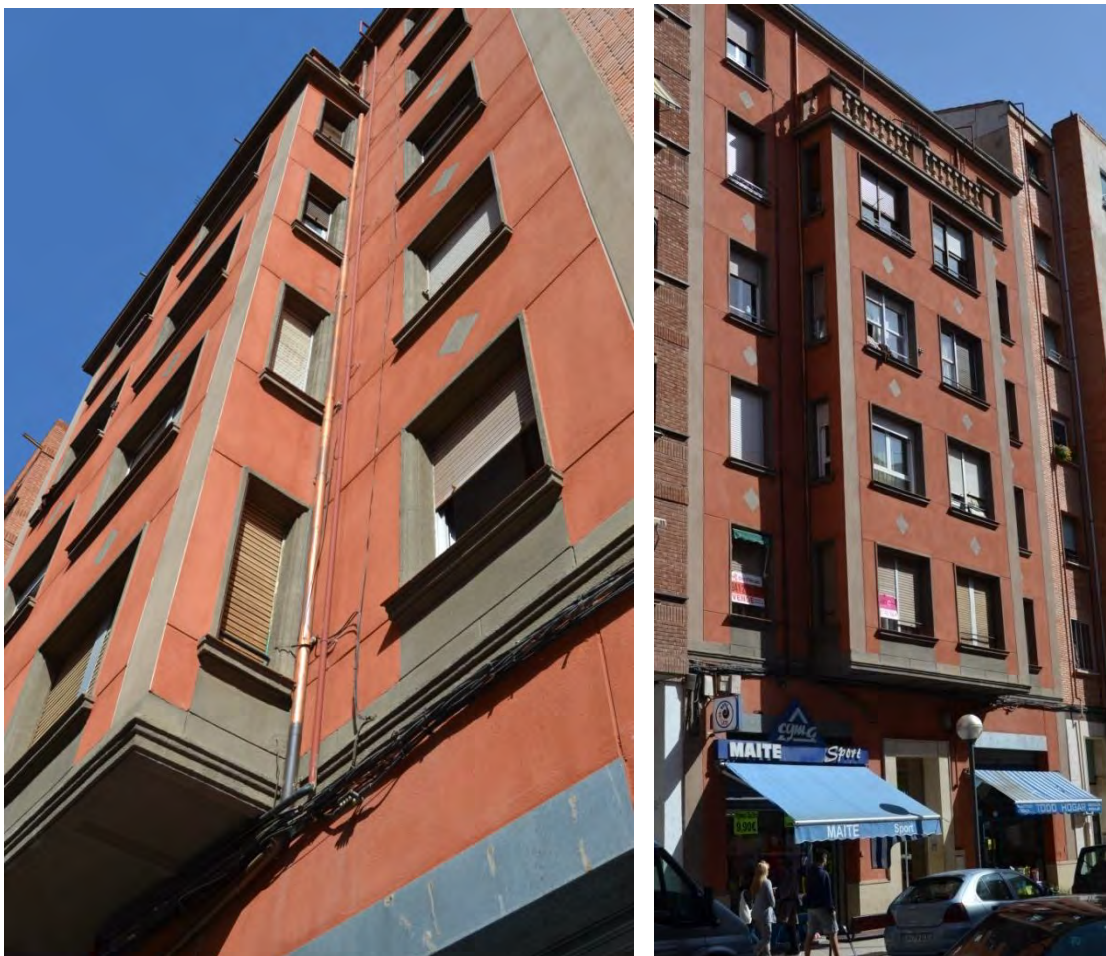
Lam. 261. Edificio de 10 viviendas, c/ Cigüeña 13, fachada, Logroño, R. Fontán 1956
