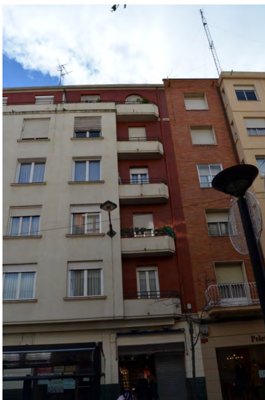
Lám. 160. Edificio de 19 viviendas y locales, c/ Doctores Castroviejo 36, detalle fachada, Logroño. L. González. 1953
