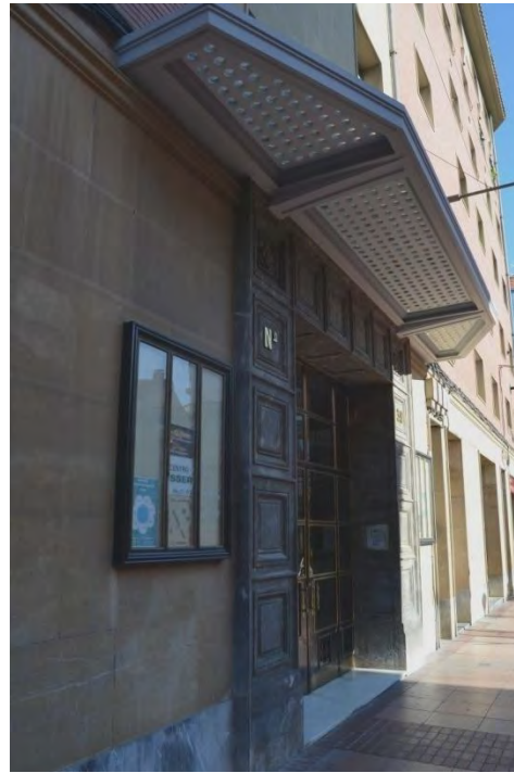
Lam. 135. Edificio de 36 viviendas, c/ Calvo Sotelo 39, portal y marquesina, Logroño, A. del Valle, 1950
