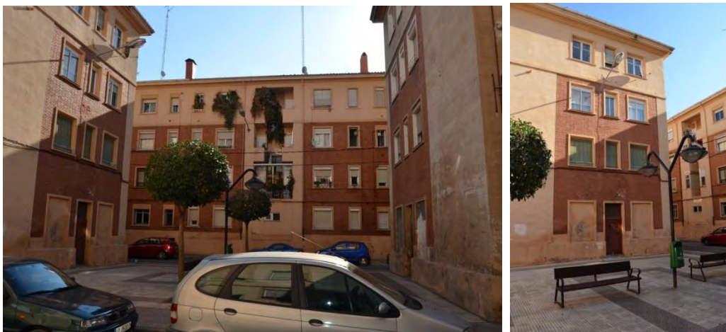
Lam. 214. Edificio de 112 viviendas en 4 bloques en las calles Oyón, Cervera y Beatos Mena y Navarrete, vistas de calles interiores, Logroño, G. Cadarso y L. González, 1955
