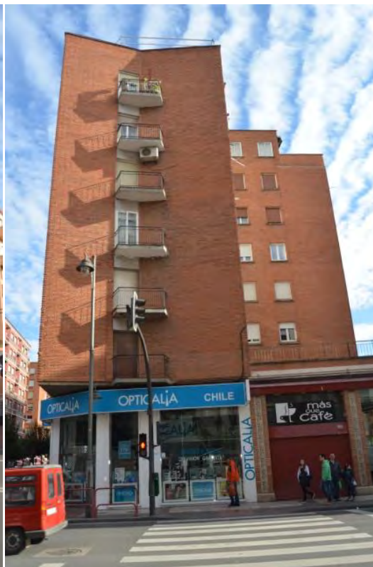
Lám. 343. Edificio de viviendas, a/ Pérez Galdós 53, vista desde c/ Chile, Logroño, R. Gil Albarellos 1958
