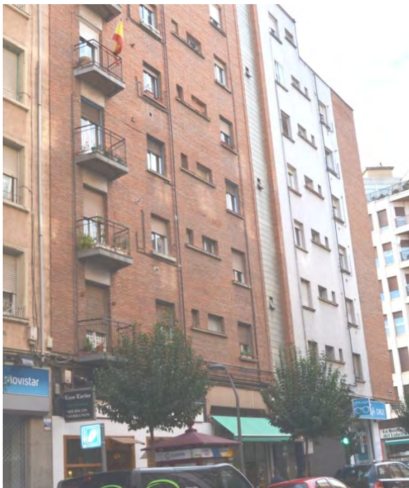
Lám. 339. Edificio de viviendas, a/ Pérez Galdós 53, vistas desde a/ Pérez Galdós, Logroño, R. Gil Albarcellos 1958
