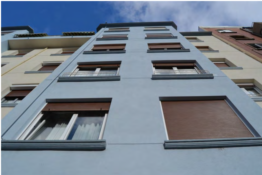
Lam. 200. Edificio de 25 viviendas, a/ Jorge Vigón 31, detalle de fachada, Logroño, L. González. 1955 (AML PU 86/1955)
