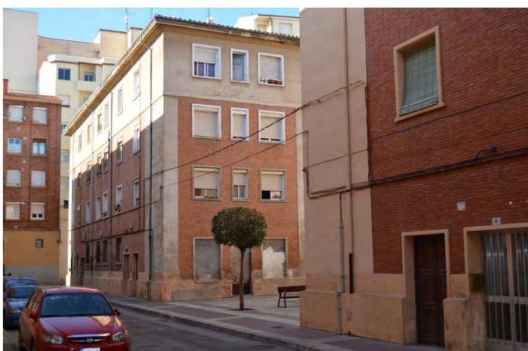
Lam. 215. Edificio de 112 viviendas en 4 bloques en las calles Oyón, Cervera y Beatos Mena y Navarrete, vista de calle interior, Logroño, G. Cadarso y L. González, 1955
