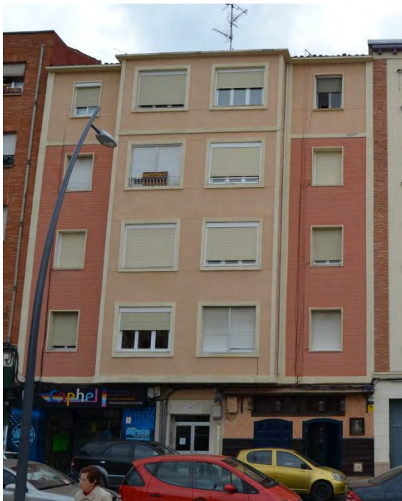
Lám. 319. Edificio de 8 viviendas, c/ Lardero 29, Logroño, A. Fernández Ruiz-Navarro 1958
