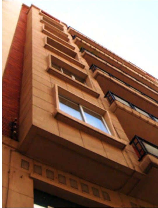
Lám. 395. Edificio de viviendas, a/ Pío XII 1, detalle de fachada, Logroño, J. Carceller 1959
