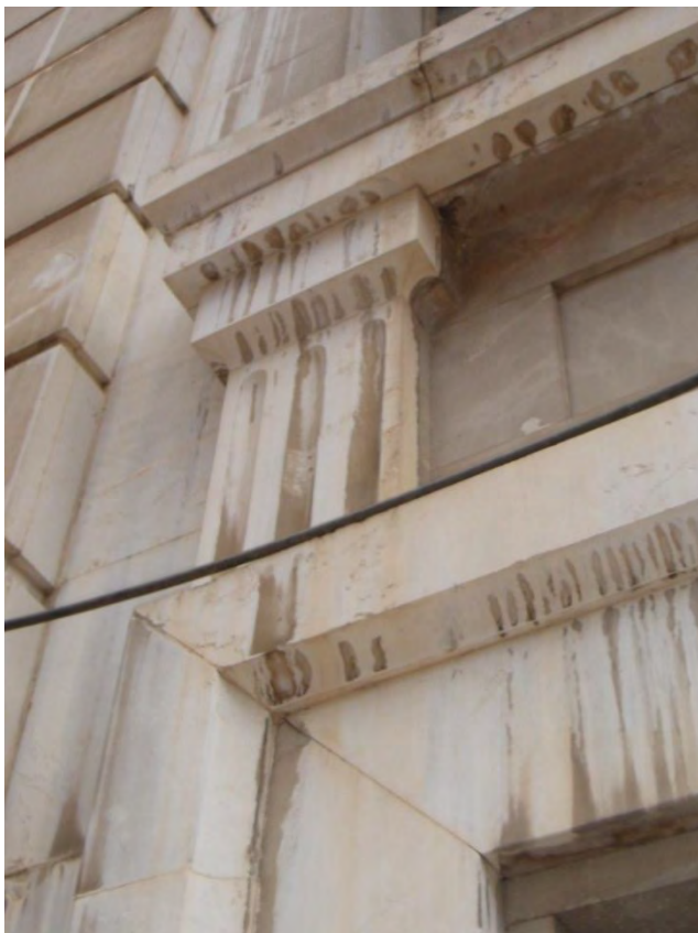
Lám. 113. Edificio de viviendas y Estación de autobuses, A/ España 1 a 11 y A/ Pío XII 2 a 10, Logroño, J. Carceller y Luis González, 1949
