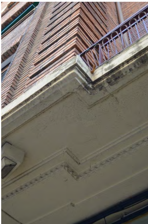
Lam. 190. Edificio de viviendas, c/ Duquesa de la Victoria 18-22, detalle de fachada, sofito, Logroño, R. Gil Albarellos. 1954
