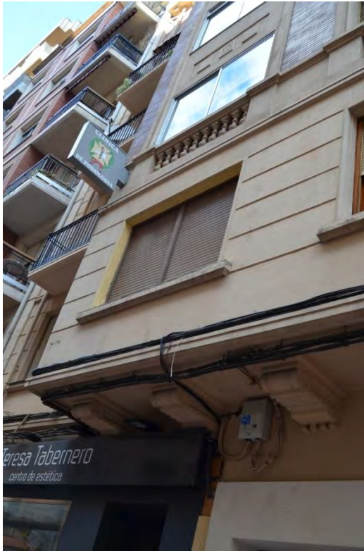
Lám. 85. Edificio de 12 viviendas y almacenes, c/ Doctores Castroviejo 1bis, detalle de fachada, sofito, balastrada y ménsulas, Logroño, J. M a Carreras y R. Fontán 1947
