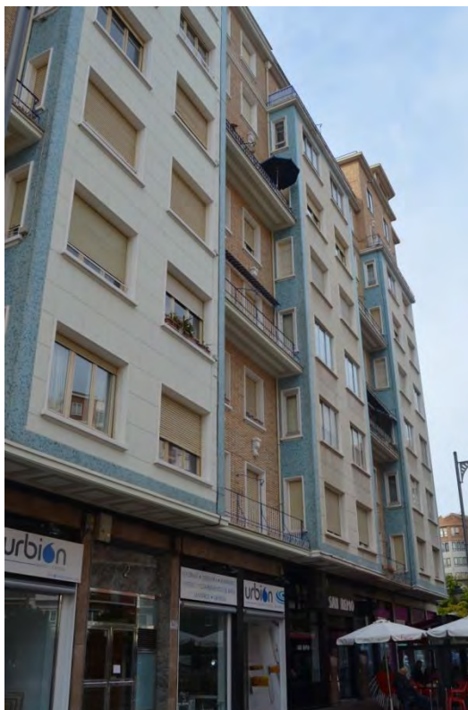
Lám. 360. Edificio de viviendas, esquina a/ España y c/ General Vara de Rey, fachada a a/ España, Logroño, J. M a . Carreras y R. Fontán 1958
