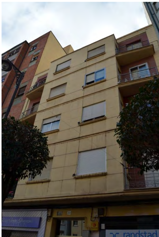
Lam. 306. Edificio de 8 viviendas, a/ Jorge Vigón 30, Logroño, A. Fernández Ruiz-Navarro 1957
