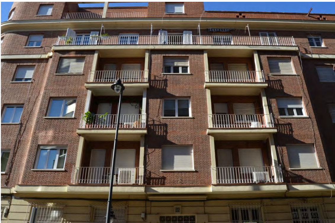
Lam. 146. Edificio de 41 viviendas, c/ Marqués de la Ensenada 28-32 y a/ Jorge Vigón 45, Logroño, vista desde Marqués de la Ensenada, M. L. Pedraza, 1951, (AML PU 278/1951)
