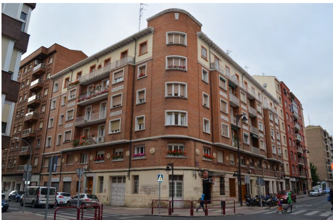
Lam. 23. Edificio de 44 viviendas, c/ Marqués de la Ensenada 19-21 y c/ Milicias 12, Logroño, J. M o Carreras 1954
