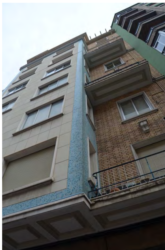
Lám. 366. Edificio de viviendas, esquina a/ España y c/ General Vara de Rey, detalle de sofitos, Logroño, J. M a . Carreras y R. Fontán 1958
