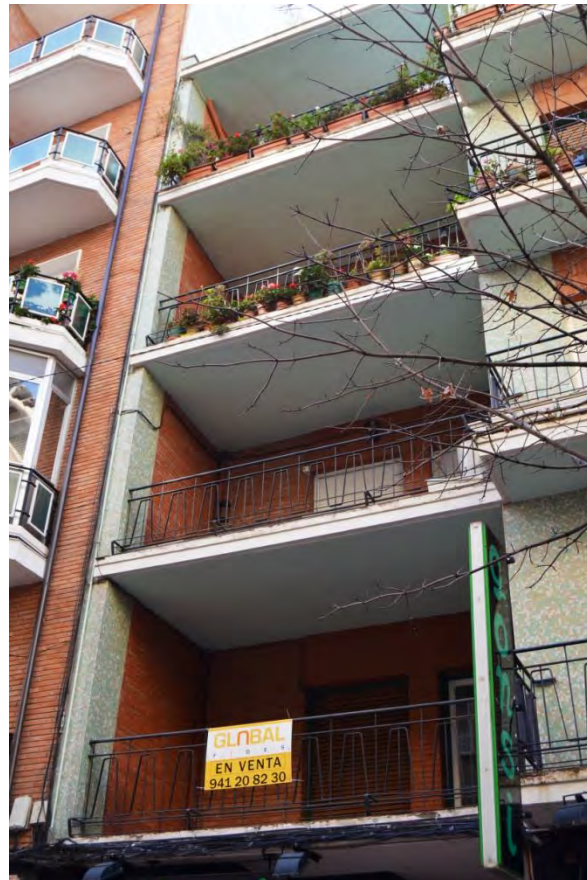
Lam. 422. Edificio de viviendas, c/ Doctores Castroviejo 30, detalle de fachada, Logroño, F. Ruiz 1961
