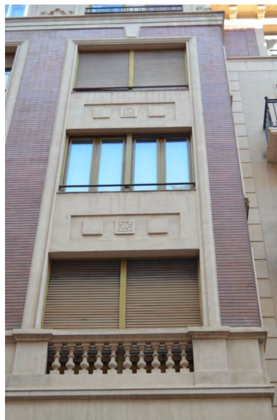
Lám. 83. Edificio de 12 viviendas y almacenes, c/ Doctores Castroviejo 1bis, detalle de fachada, Logroño, J. M a Carreras y R. Fontán 1947
