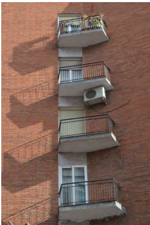
Lám. 344. Edificio de viviendas, a/ Pérez Galdós 53, detalle de fachada Logroño, R. Gil Albarellos 1958
