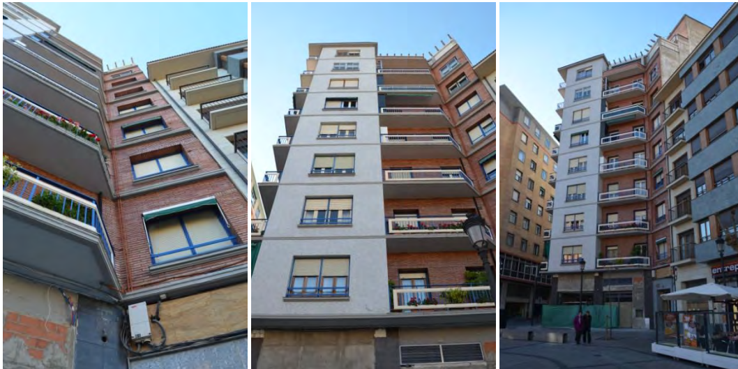
Lám. 450. Edificio de viviendas, c/ Once de junio 1, detalles de fachada y vista de la misma, Logroño, A. Fernández Ruiz-Navarro 1963.
