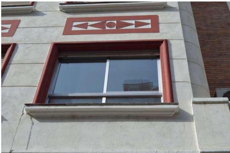
Lám. 68. Edificio de 13 viviendas, almacenes y carboneras, c/ General Vara de Rey 52, detalle fachada, Logroño, R. Fontán 1947
