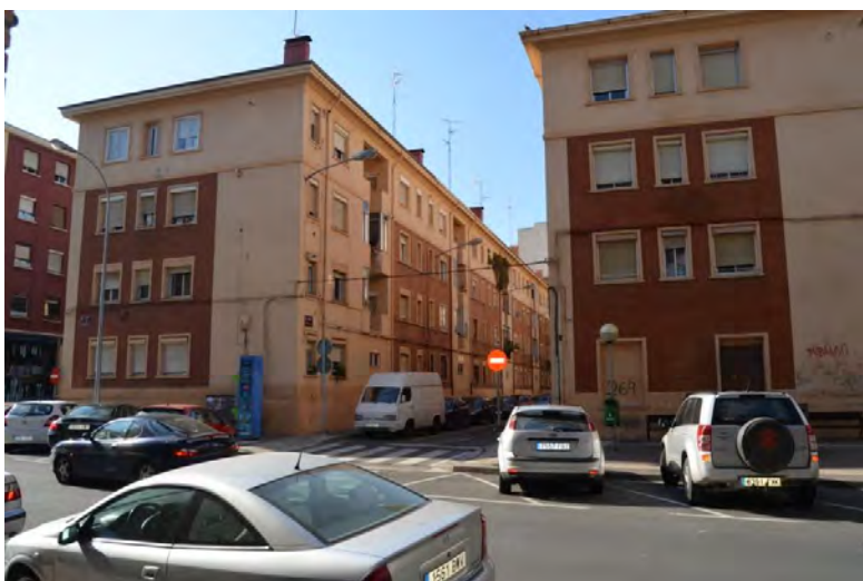
Lam. 217. Edificio de 112 viviendas en 4 bloques en las calles Oyón, Cervera y Beatos Mena y Navarrete, vista desde calle de Cigüeña, Logroño, G. Cadarso y L. González, 1955
