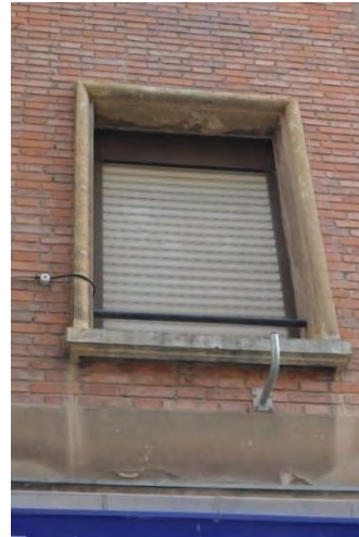
Lám. 282. Edificio de 19 viviendas, c/ Vélez de Guevara 19, detalle de fachada, Logroño. G. Cadarso 1957
