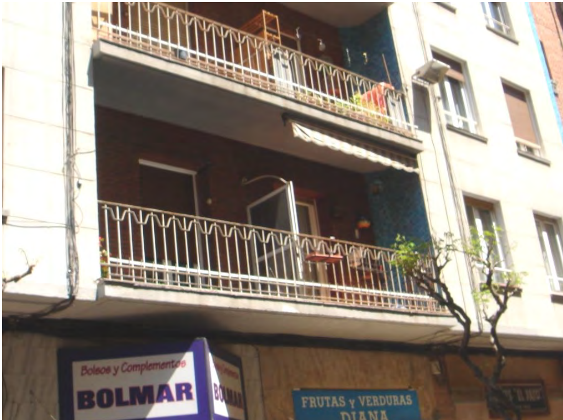
Lám. 442. Edificio de viviendas, a/ a/ Colón 11, detalle de fachada, Logroño, J. Carceller y Luis González 1962
