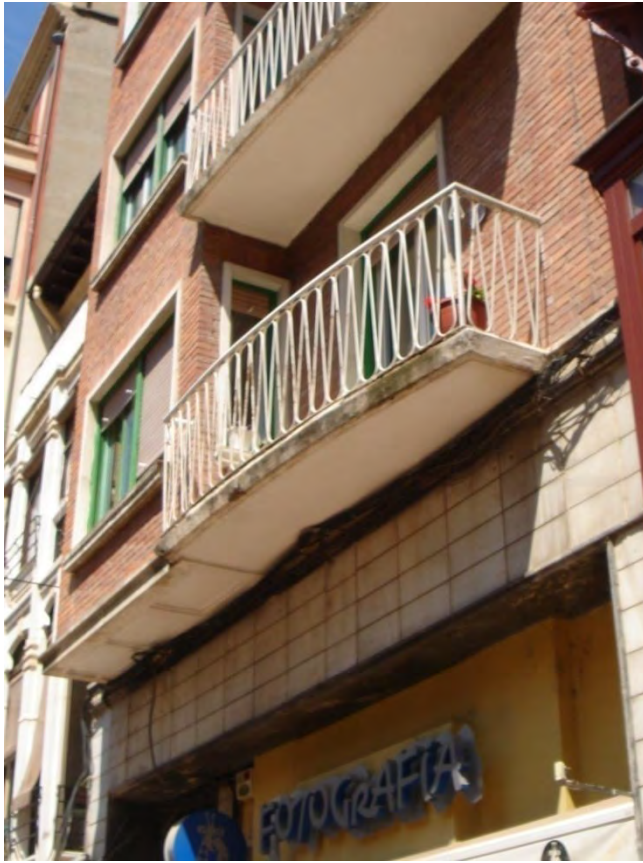
Lám. 259. Edificio de 6 viviendas, c/ Portales 10, fachada detalle, Logroño, L. González y J. Carceller, Logroño 1956
