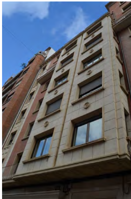
Lam. 291. Edificio de 14 viviendas, a/ Jorge Vigón 13, detalle de fachada, Logroño, J. Mª. Carreras y R. Fontán 1957
