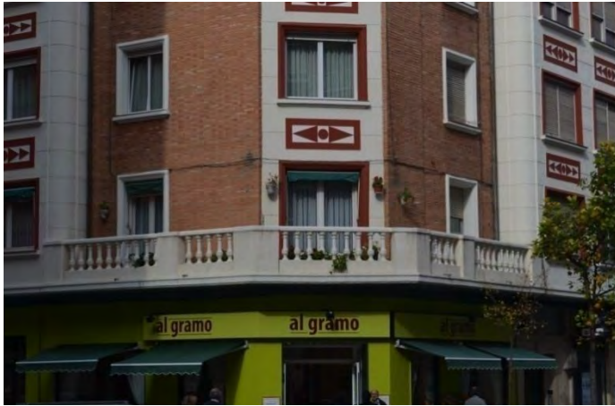
Lám. 67. Edificio de 13 viviendas, almacenes y carboneras, c/ General Vara de Rey 52, detalle de cartela y balaustrada en chaflán, Logroño, R. Fontán 1947
