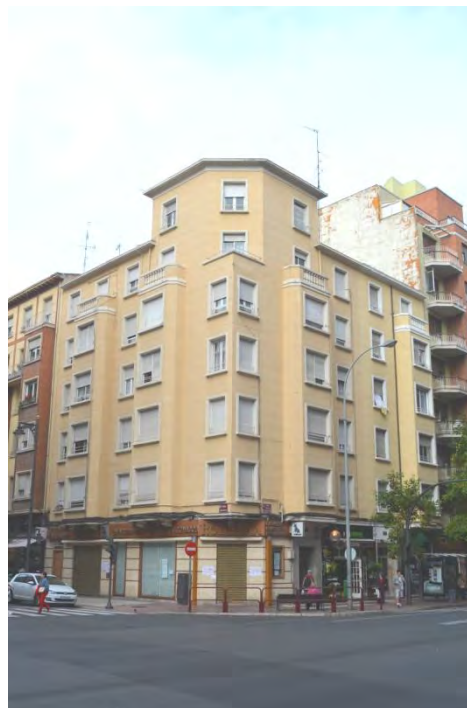
Lám.9. Edificio de 9 viviendas y almacén, c/ General Vara de Rey 60 esquina c/ Huesca, Logroño, R Fontán 1947
