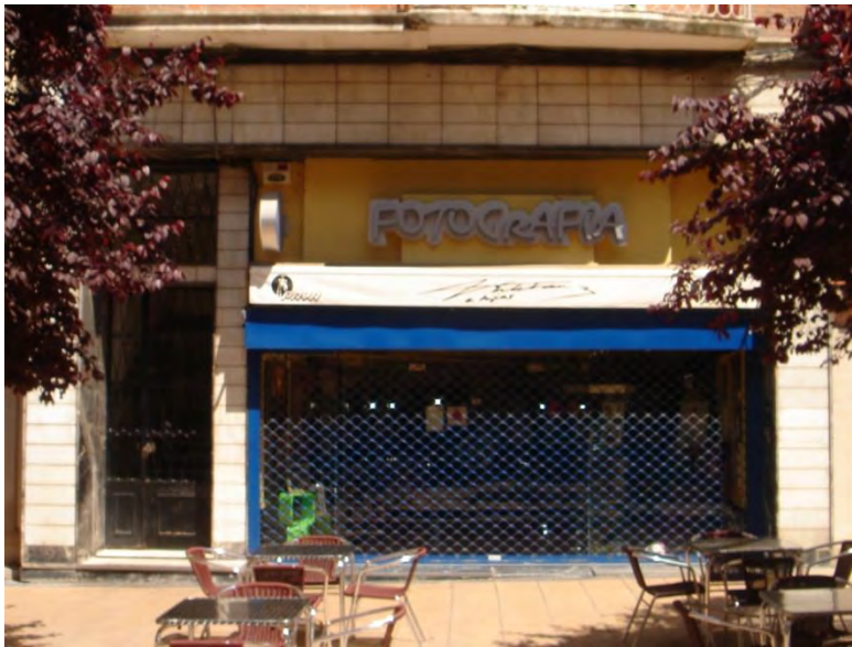
Lám. 256. Edificio de 6 viviendas, c/ Portales 10, fachada detalle, Logroño, L. González y J. Carceller, Logroño 1956
