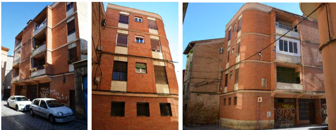
Lam. 358. Edificio de viviendas, c/ Cofradía del Pez, detalles de fachada, Logroño, J. Encio 1958
