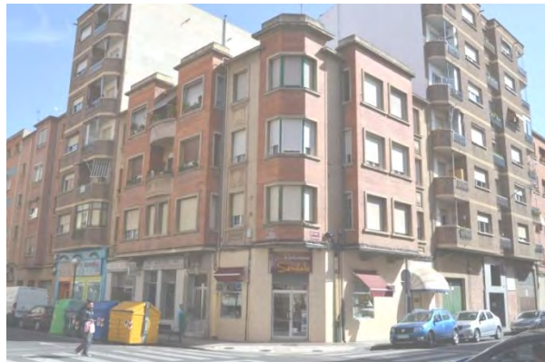
Lam. 240. Edificio de 5 viviendas, c/ Teniente Coronel Santos Ascarza 26, Logroño, R. Fontán, Logroño 1955
