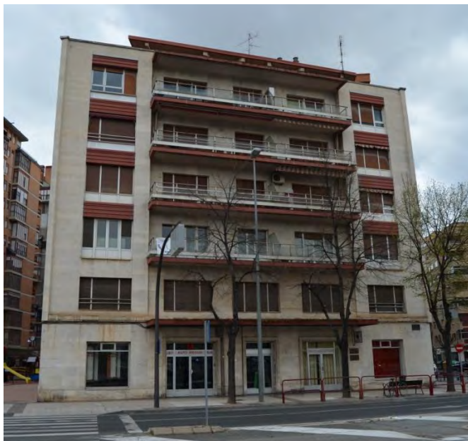
Lám. 425. Edificio de viviendas, pza/ Europa 7, Logroño, R. San Pedro 1961
