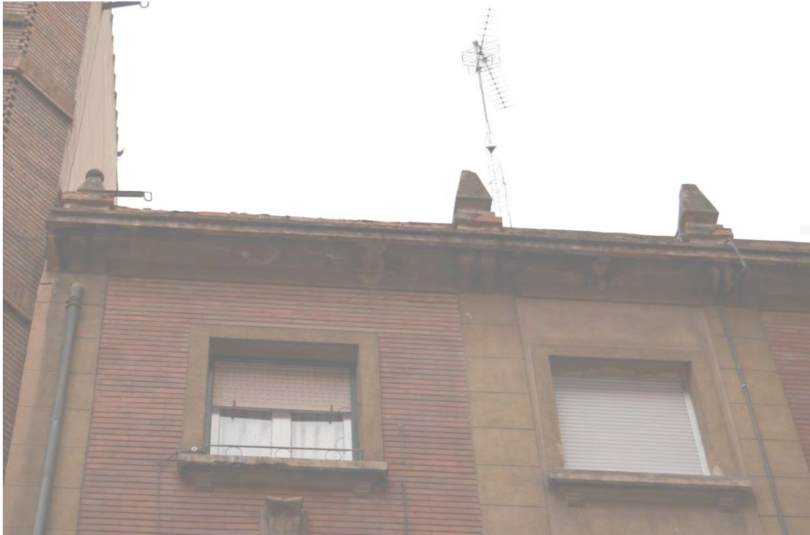
Lam. 238. Edificio de 14 viviendas, c/ Galicia 12, detalle de fachada, alero y pináculos, Logroño, J. M a Carreras 1955
