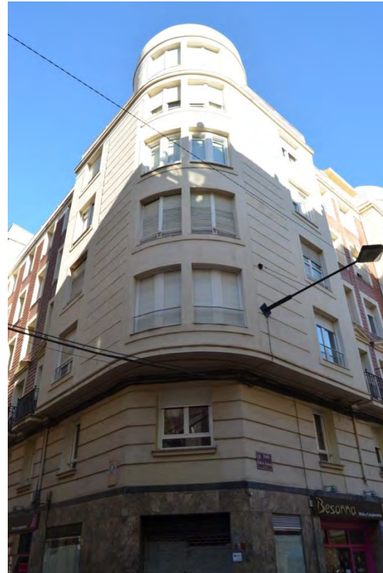
Lám. 90. Edificio de 24 viviendas, c/ Calvo Sotelo 13 y a/ Juan XXIII 6, detalle de fachada, esquina, Logroño, A. del Valle. 1947
