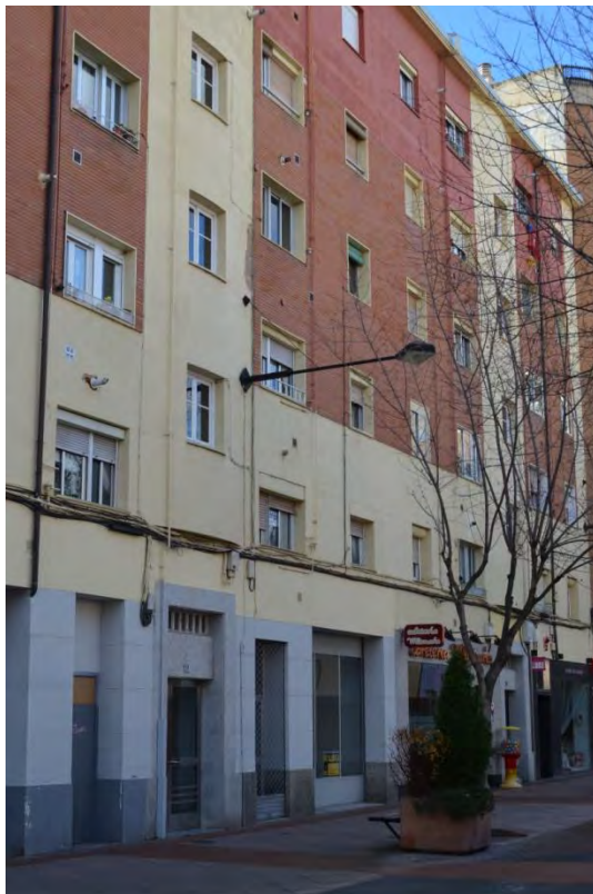
Lám. 174. Edificio de 32 viviendas, c/ Ciriaco Garrido 10-12, Logroño, A. del Valle. 1954
