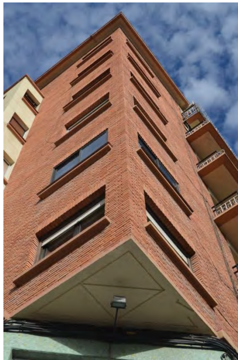
Lám. 348. Edificio de viviendas, c/ Beratúa 2, detalle de la esquina, Logroño, J. Carceller 1958
