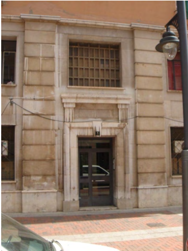
Lám. 112. Edificio de viviendas y Estación de autobuses, A/ España 1 a 11 y A/ Pío XII 2 a 10, Logroño, J. Carceller y Luis González, 1949
