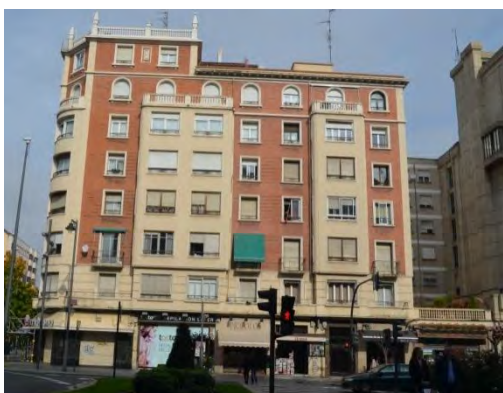
Lám. 96. Edificio de 24 vivienda y almacenes, a/ Jorge Vigón 1 esquina c/ General Vara de Rey 17, fachada Jorge Vigón, Logroño, J. M a Carreras y R. Fontán 1947
