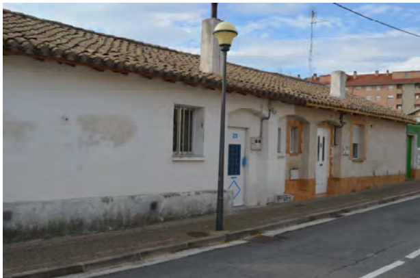
Lam. 104. Grupo de 198 viviendas ultraeconómicas General Yagüe, zona a/ Burgos, Logroño, J. M a Carreras, 1949
