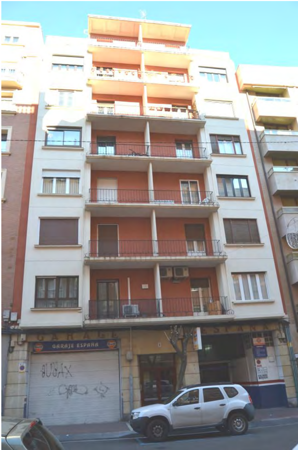
Lam. 226. Edificio de 14 viviendas, c/ Duquesa de la Victoria 5, Logroño, L. González. 1955
