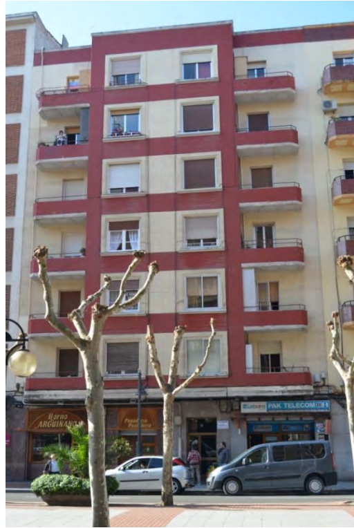
Lam. 30. Edificio de 24 viviendas, a/ de la Paz 72, Logroño, Agapito del Valle y Félix del Valle 1958
