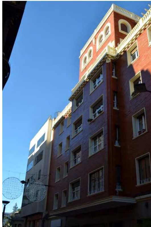
Lám. 140. Edificio de 12 viviendas, c/ Calvo Sotelo 1bis, detalle de fachada, remate superior, Logroño, R. Fontán. 1950
