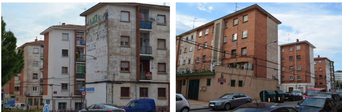
Lám. 396. 72 viviendas en 3 bloques, C/ Piqueras 101 a 105 y c/ C Cerezos 1 a 6, Logroño, F. Ruiz Río 1959
