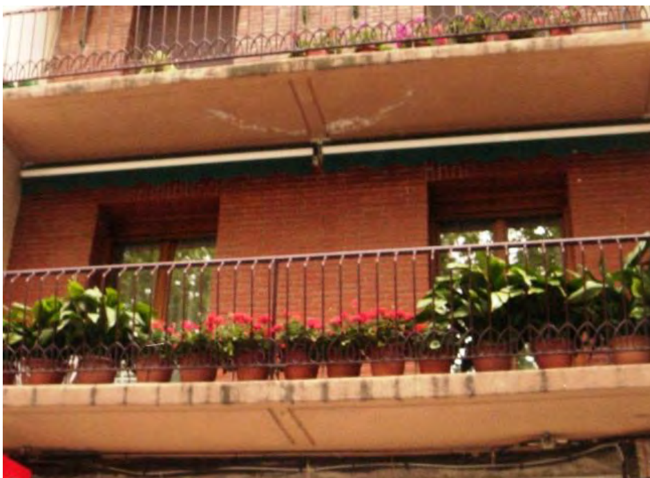
Lám. 235. Edificio de viviendas, a/ de La Paz 2, detalle de soffitos y terrazas centrales, Logroño, J. Carceller. 1955
