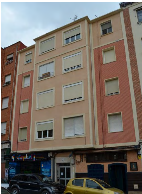
Lám. 317. Edificio de 8 viviendas, c/ Lardero 29, Logroño, A. Fernández Ruiz-Navarro 1958
