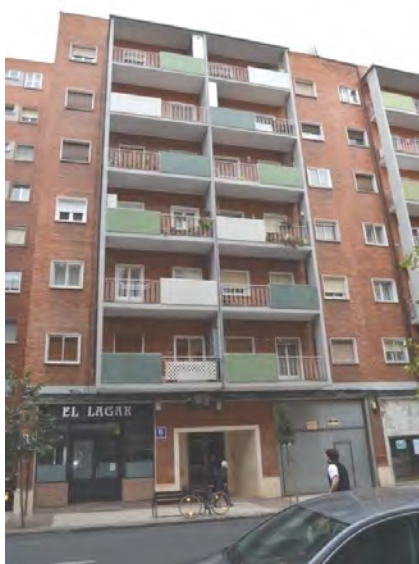
Lám. 432. Edificio de viviendas, c/ Huesca 13, Logroño, R. Gil Albarellos 1962
