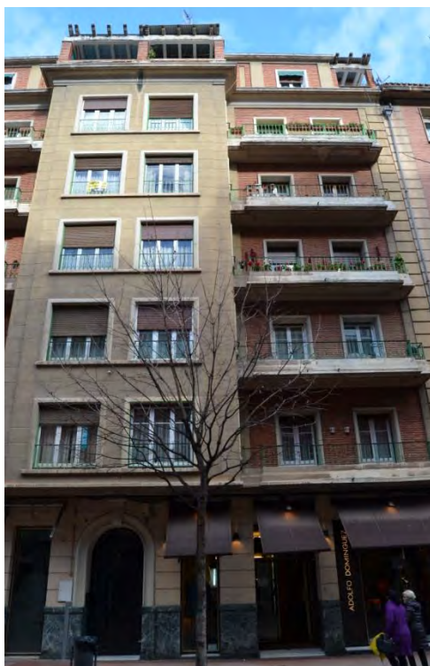
Lam. 293. Edificio de 12 viviendas, c/ Doctores Castroviejo 21, fachada, parcial, Logroño, G. Cadarso 1957
