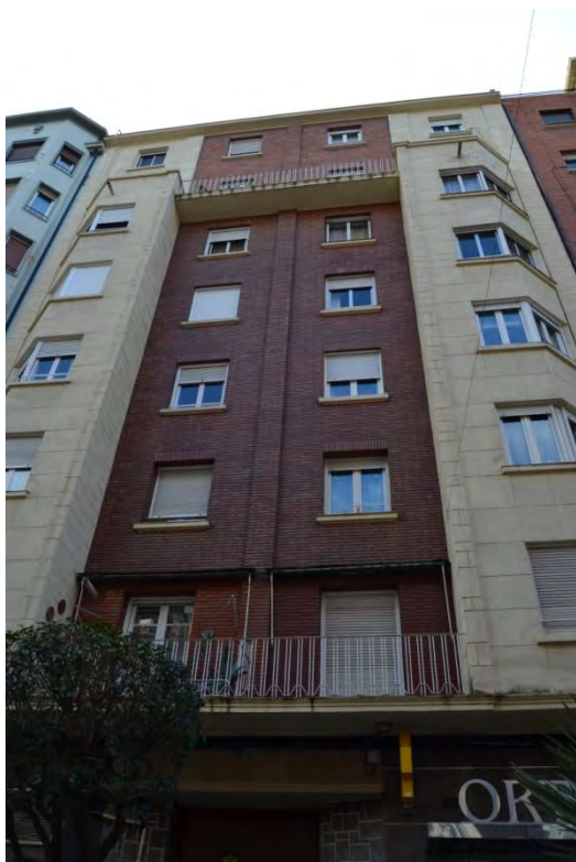
Lam. 322. Edificio de 28 viviendas, a/ Jorge Vigón 26, Logroño, J. M a . Carreras y R. Fontán 1958
