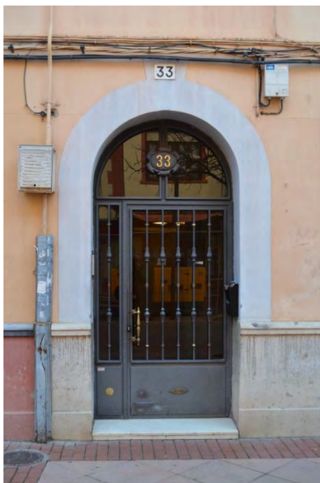
Lam. 62. Edificio de 10 viviendas y locales, c/ Doctores Castroviejo 33, detalle de fachada, portal, Logroño, A. del Valle 1947
