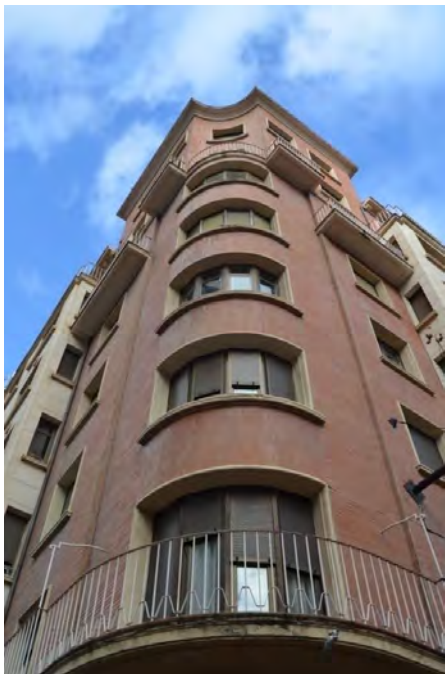
Lam. 290 Edificio de 14 viviendas, a/ Jorge Vigón 13, esquina, Logroño, J. Mª. Carreras y R. Fontán 1957
