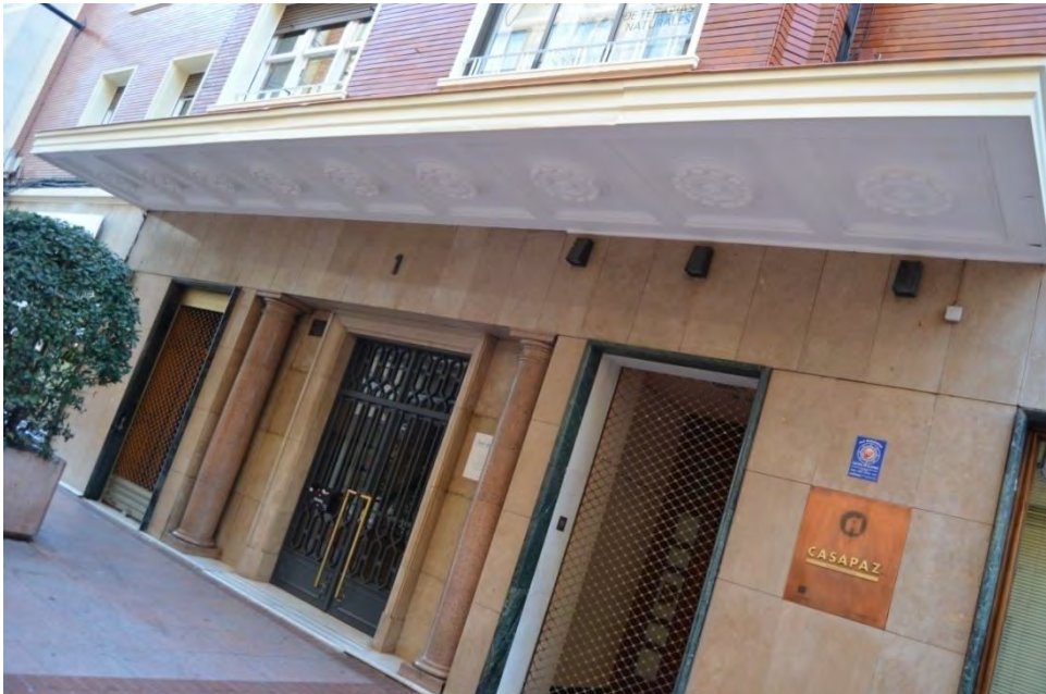
Lám. 138. Edificio de 12 viviendas, c/ Calvo Sotelo 1bis, detalle de fachada, marquesina de entrada, Logroño, R. Fontán. 1950
