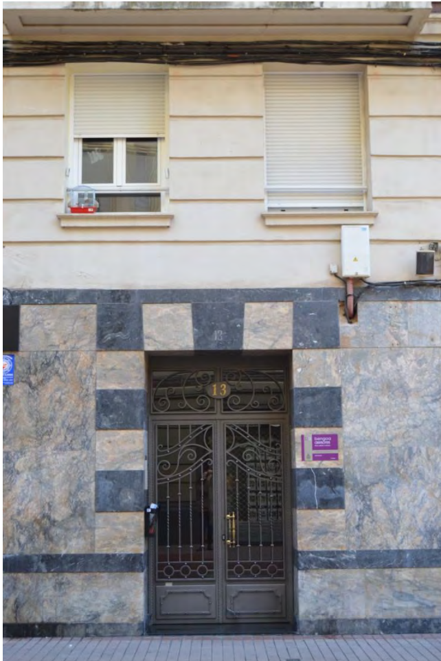
Lám. 93. Edificio de 24 viviendas, c/ Calvo Sotelo 13 y a/ Juan XXIII 6, detalle de fachada, portal, Logroño, A. del Valle, 1947
