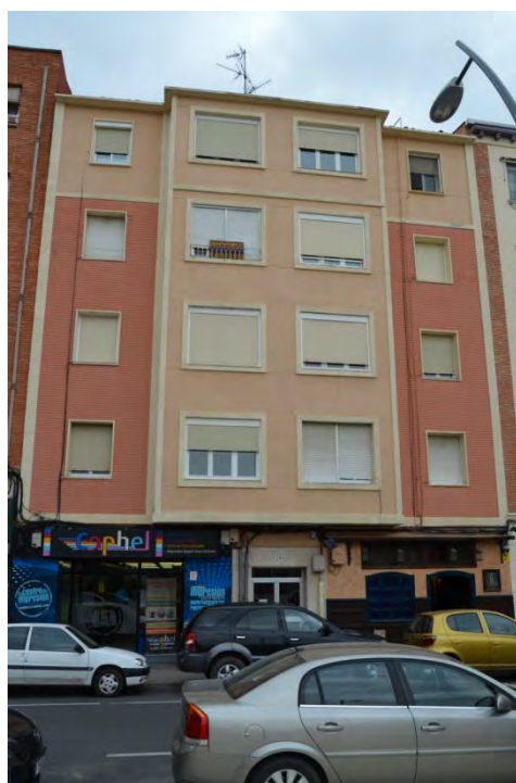
Lám. 318. Edificio de 8 viviendas, c/ Lardero 29, Logroño, A. Fernández Ruiz-Navarro 1958
