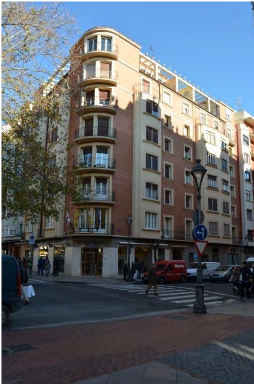
Lam. 141. Edificio de 16 viviendas, c/ Duquesa de la Victoria 3, Logroño, L. González. 1951
