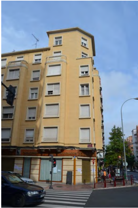
Lám. 71. Edificio de 9 viviendas y almacén, c/ General Vara de Rey 60, fachada a c/ Huesca, Logroño, R. Fontán 1947
