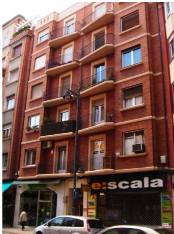
Lám. 313 Edificio de viviendas, a/ República Argentina 18, Logroño, J. Carceller 1958
