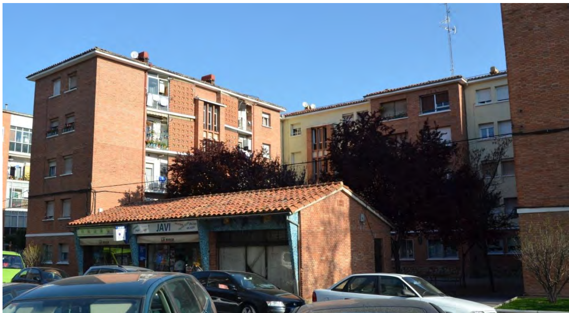
Lám. 400. Grupo Sindicatos, 100 viviendas en calles Río Oja 2-8, Luis Ulloa 9-17 y San José 30-32, bloque sur, Logroño J. M a Carreras 1959
