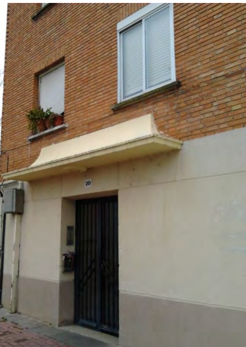
Lam. 210. Edificio de 122 viviendas de Bodegas Franco Españolas, c/ Ebro 2-20, detalle de marquesina y portal, Logroño, E. Apraiz y J. Guinea, 1955
