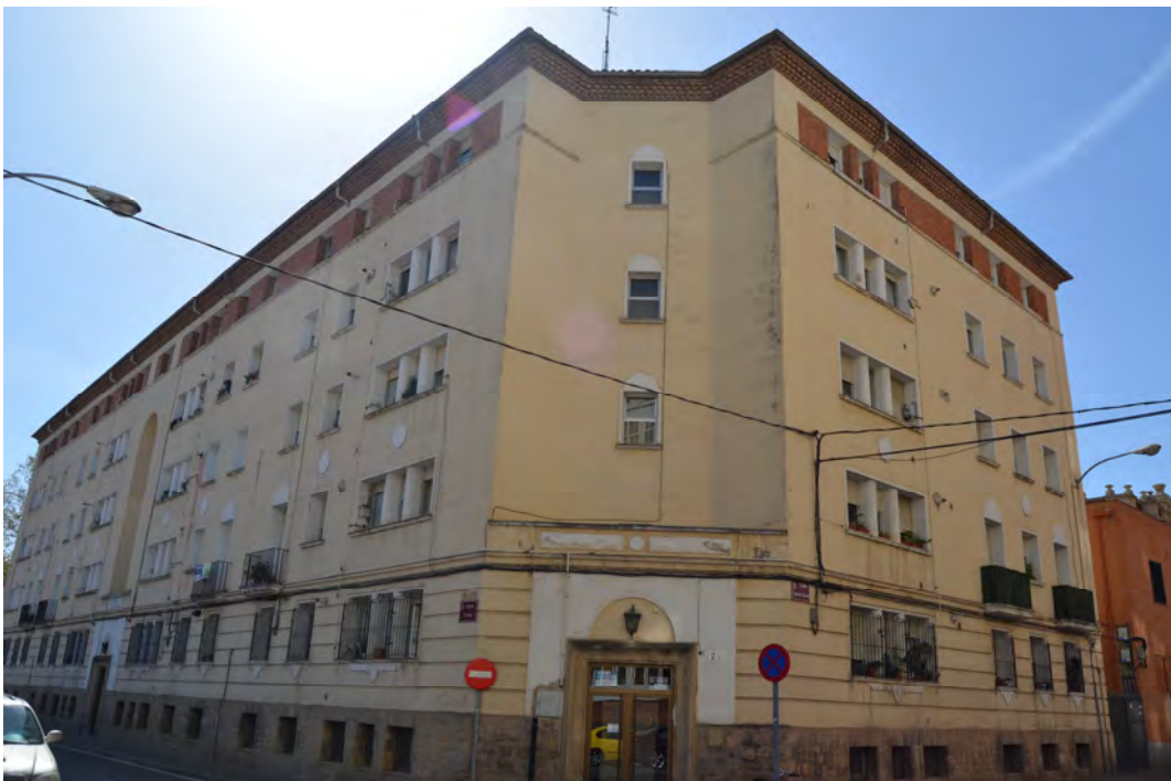
Lam. 55. Edificio de viviendas, c/ Obispo Bustamante 7, esquina calles Capitán Gaona y Tricio, Logroño, J. Gordillo, M. Niubo y T. Asensio, 1946
