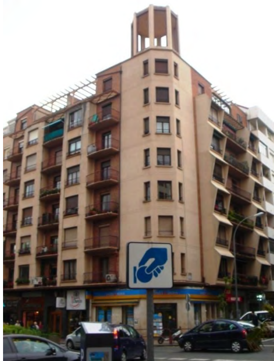
Lám. 227. Edificio de viviendas, a/ de La Paz esquina a/ Juan XXIII, Logroño. J. Carceller. 1955
