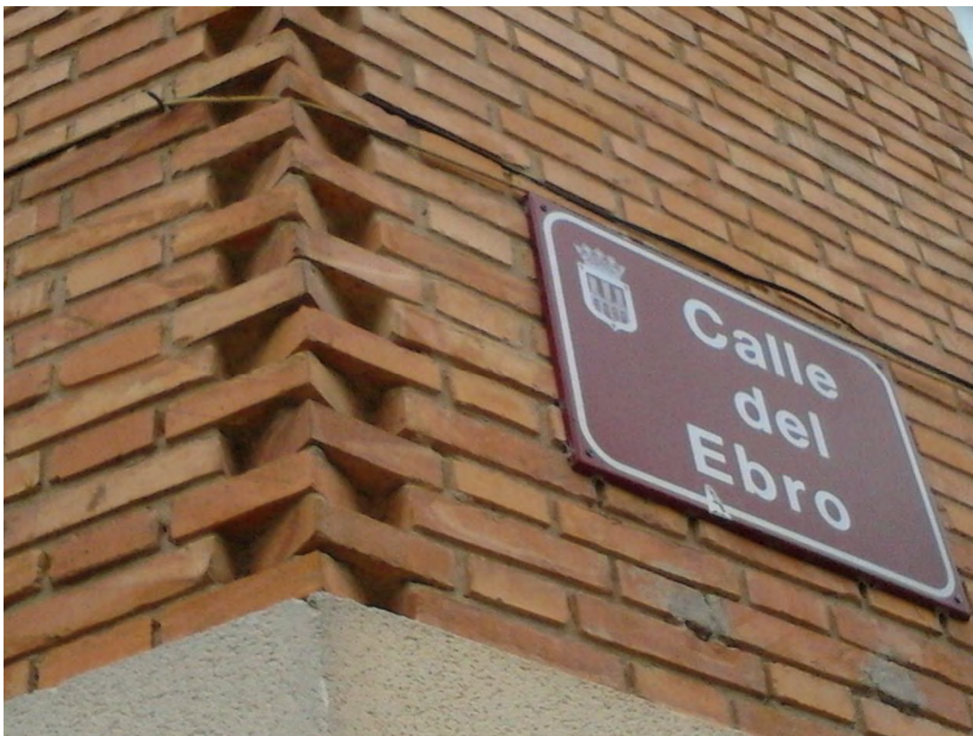
Lam. 212. Edificio de 122 viviendas de Bodegas Franco Españolas, c/ Ebro 2-20, detalle de la esquina, Logroño, E. Apraiz y J. Guinea, 1955
