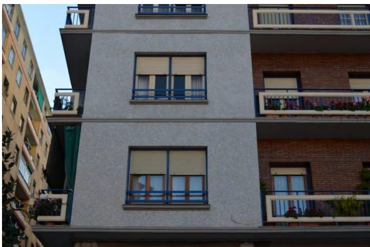
Lám. 447. Edificio de viviendas, c/ Once de junio 1, detalle de fachada, Logroño, A. Fernández Ruiz-Navarro 1963.
