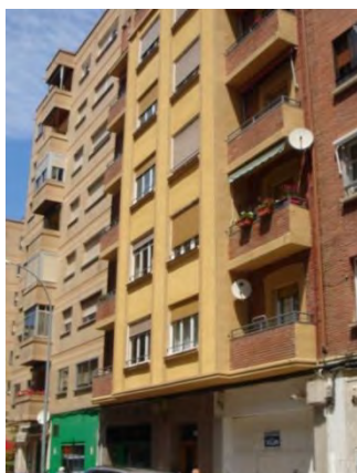
Lám. 301. Edificio de viviendas, c/ Milicias 15, Logroño, J. Carceller 1957
