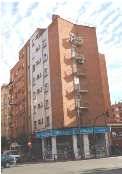
Lám. 338. Edificio de viviendas, a/ Pérez Galdós 53 esquina c/ Chile, Logroño, R. Gil Albarellos 1958
