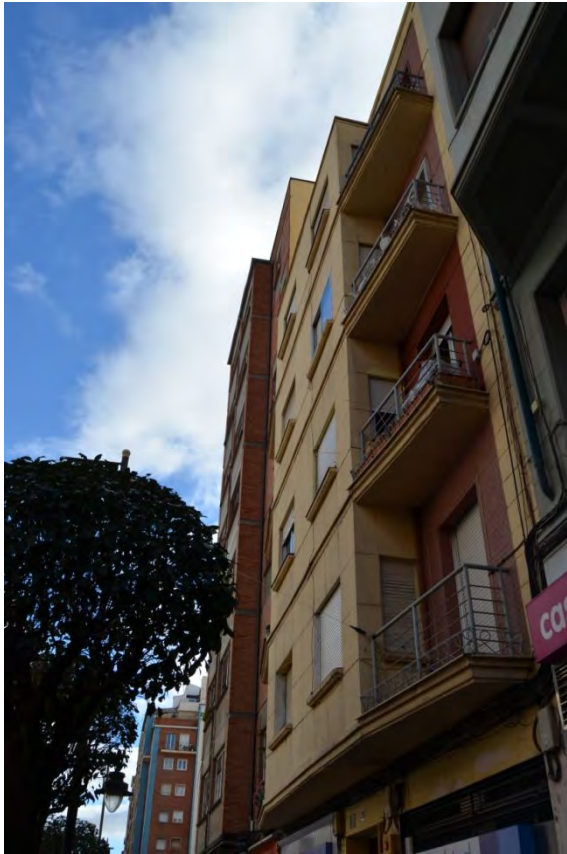
Lam. 307. Edificio de 8 viviendas, a/ Jorge Vigón 30, Logroño, A. Fernández Ruiz-Navarro 1957
