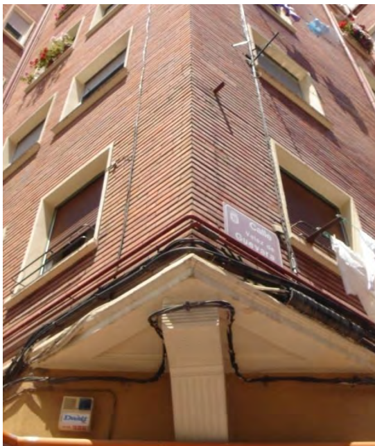
Lám. 334. Edificio de viviendas, a/ Pérez Galdós 74, detalle de la esquina, Logroño, J. Carceller 1958
