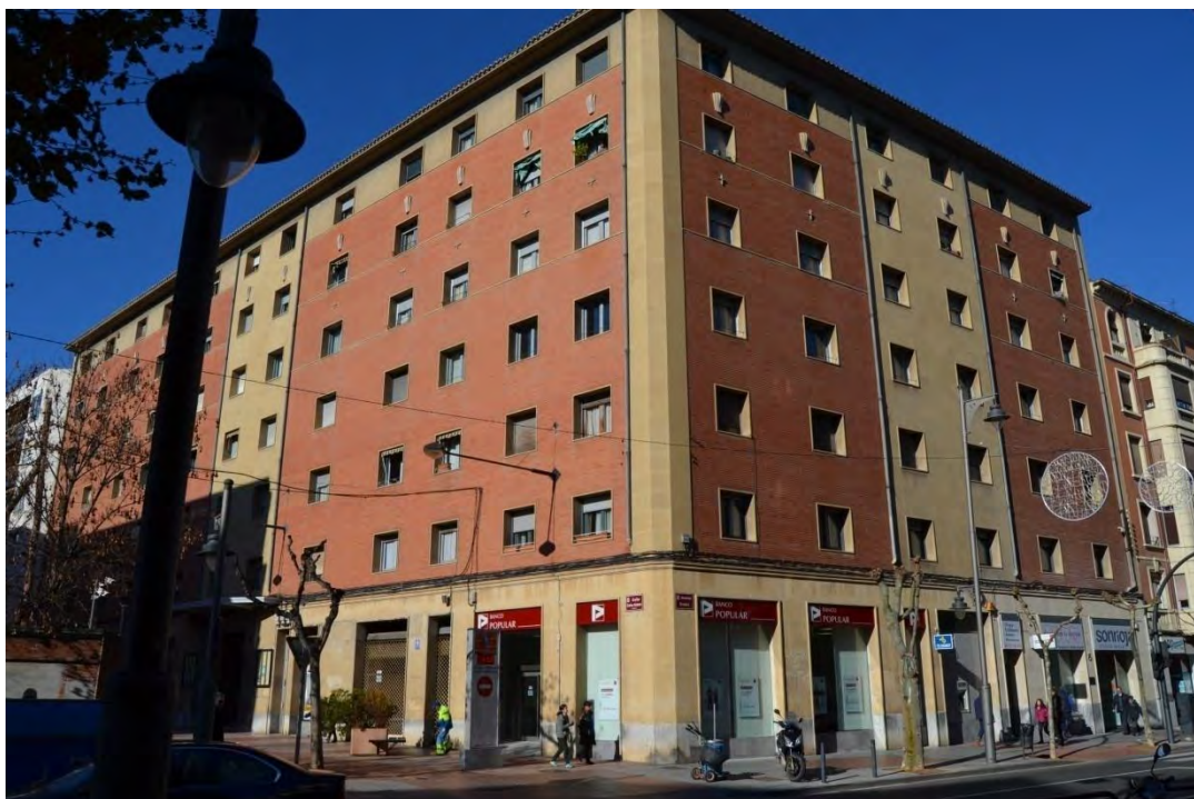
Lam. 133. Edificio de 36 viviendas, c/ Calvo Sotelo 39, Logroño, A. del Valle, 1950
