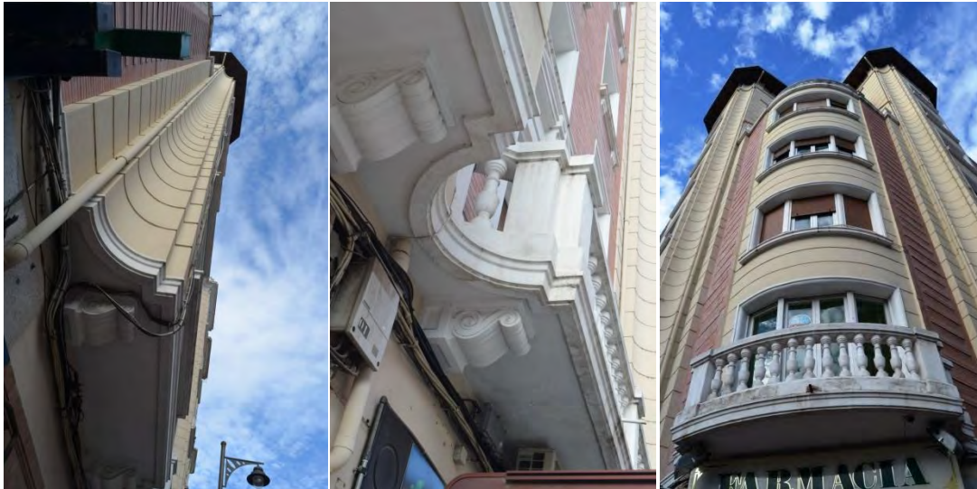
Lám. 80. Edificio de 24 viviendas y almacenes, a/ República Argentina 24-26, detalles de fachada, Logroño, J. M a Carreras 1947
