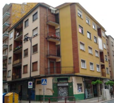
Lam. 31. Edificio de 16 viviendas, c/ Marqués de la Ensenada 7 y c/ Calvo Sotelo 51, Logroño, F. Ruiz 1960
