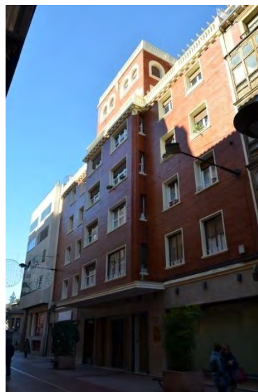
Lám. 137. Edificio de 12 viviendas, c/ Calvo Sotelo 1bis, Logroño, R. Fontán. 1950
