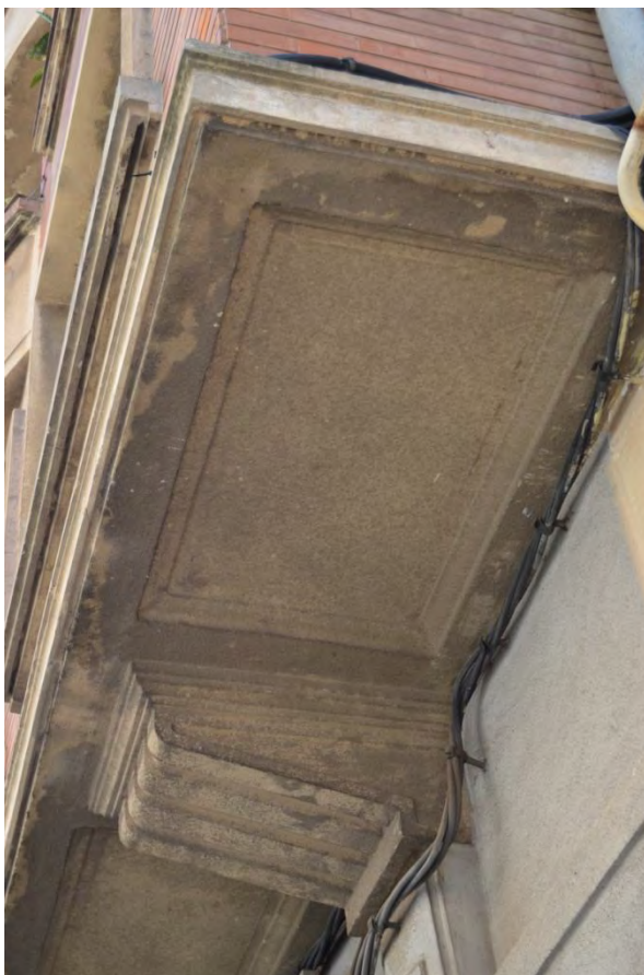
Lam. 243. Edificio de 5 viviendas, c/ Teniente Coronel Santos Ascarza 26, ménsula y sofíto, Logroño, R. Fontán, Logroño 1955
