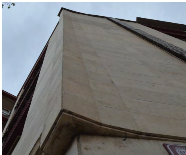
Lám. 428. Edificio de viviendas, pza/ Europa 7, detalle de fachada, Logroño, R. San Pedro 1961
