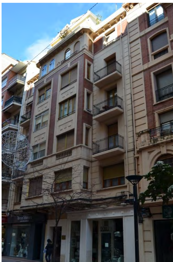
Lám. 82. Edificio de 12 viviendas y almacenes, c/ Doctores Castroviejo 1bis, Logroño, J. M a Carreras y R. Fontán 1947
