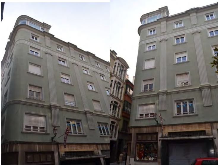
Lám. 49. Edificio de 16 viviendas, tiendas y oficinas, c/ Hermanos Moroy 1 esquina Marqués de Vallejo y fachada a Hermanos Moroy, Logroño, L. González, 1946.
