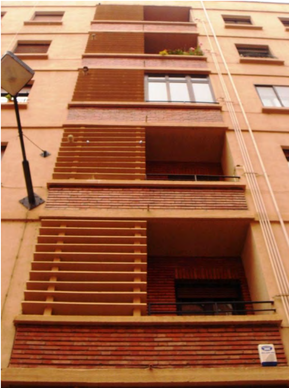
Lám. 411. Edificio de viviendas, c/ Doctores Castroviejo 16, detalle de fachada, Logroño, J. Carceller 1960
