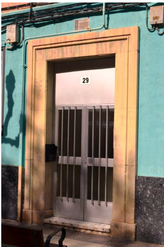
Lám. 377. Edificio de viviendas, calles Cantabria 27-31, Quintiliano 10-14 y Manzanera 12-16, detalle de fachada, portal, Logroño, J. M a Carreras y R.
