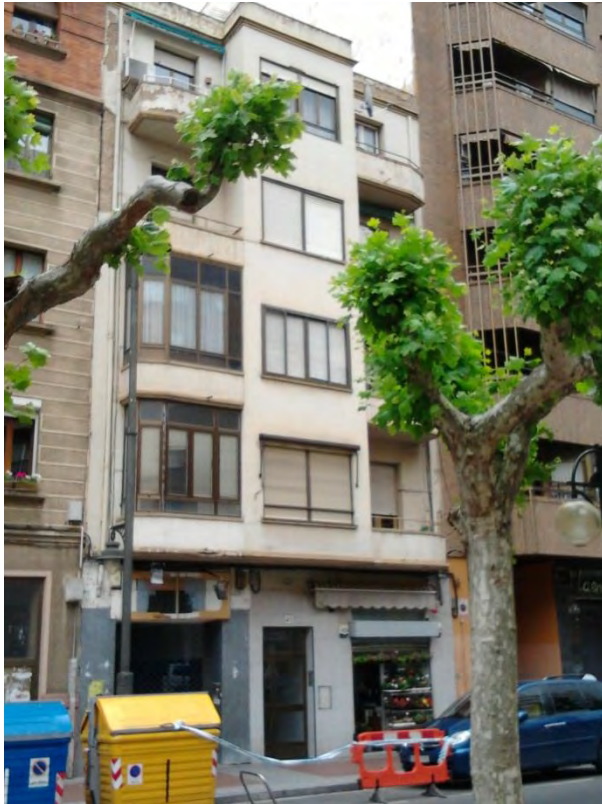
Lám. 4. Edificio de viviendas y locales, a/ de la Paz 41, Logroño, L. González 1946
