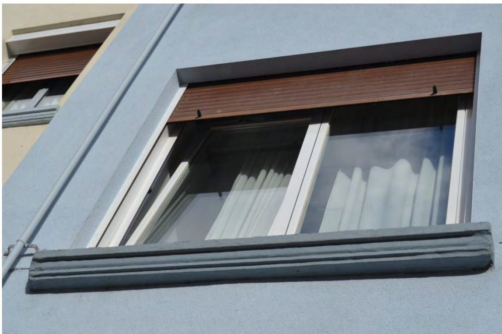
Lam. 201. Edificio de 25 viviendas, a/ Jorge Vigón 31, detalle de fachada, Logroño, L. González. 1955 (AML PU 86/1955)
