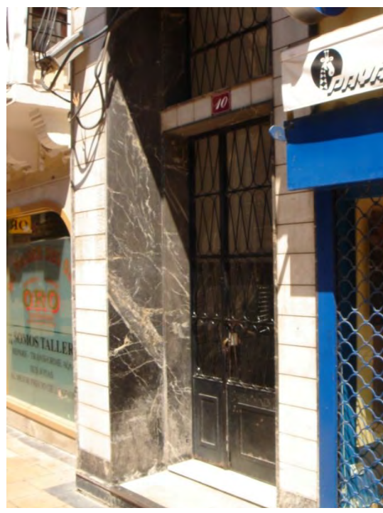
Lám. 258. Edificio de 6 viviendas, c/ Portales 10, fachada detalle, Logroño, L. González y J. Carceller, Logroño 1956
