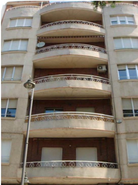
Lám. 267. Edificio de viviendas, c/ Villamediana 9, detalle de fachada, Logroño, J. Carceller, 1956
