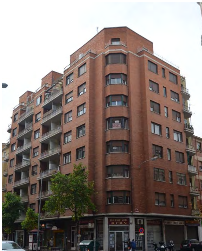
Lám. 431. Edificio de viviendas, c/ General Vara de Rey 54-56 esquina c/ Santa Isabel, Logroño, J. M a Carreras y R. Fontán 1962
