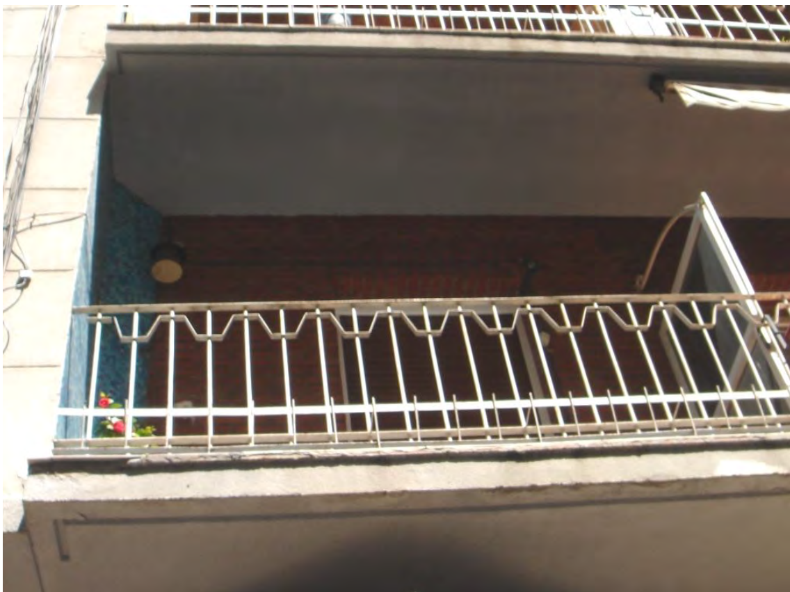
Lám. 443. Edificio de viviendas, a/ a/ Colón 11, detalle de fachada, Logroño, J. Carceller y Luis González 1962
