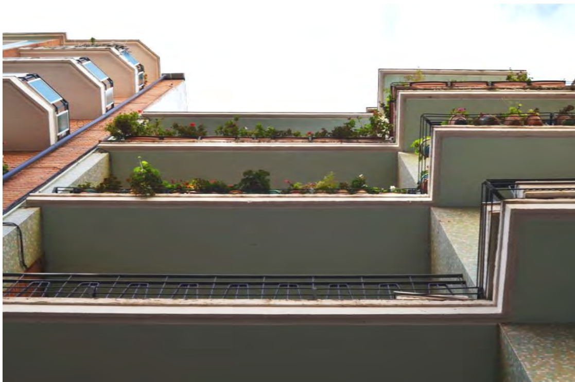
Lam. 421. Edificio de viviendas, c/ Doctores Castroviejo 30, detalle de fachada, Logroño, F. Ruiz 1961
