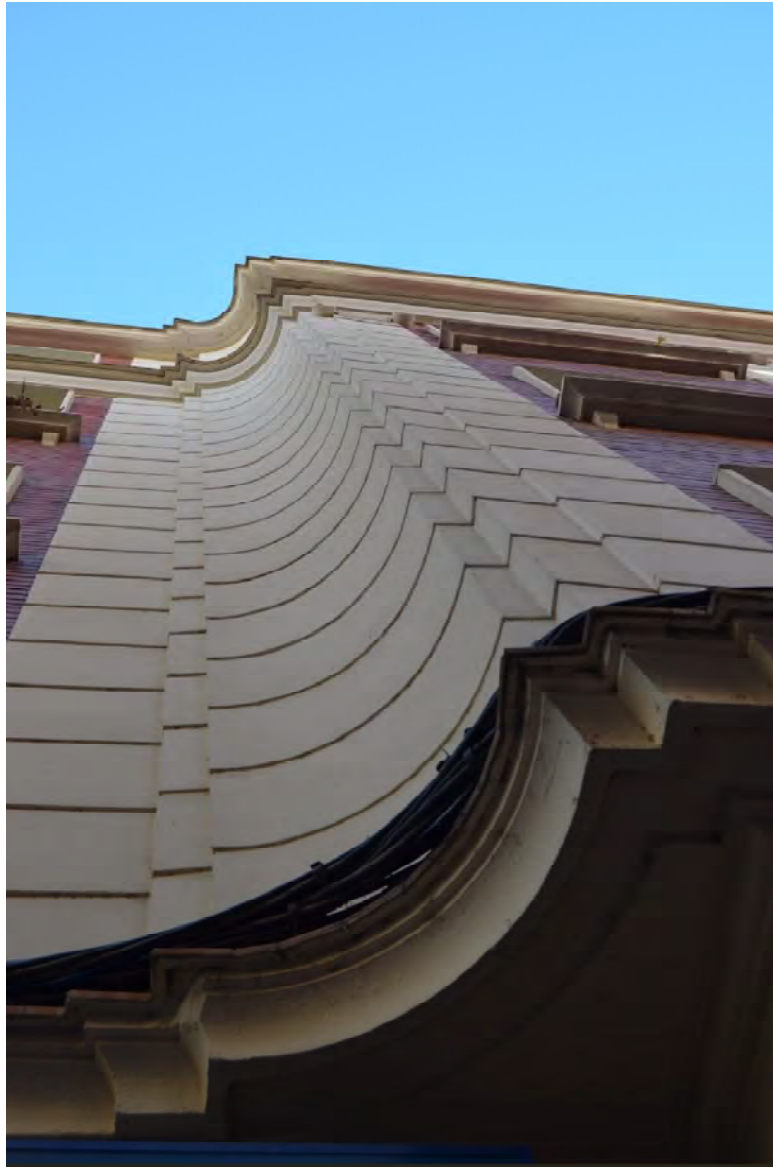
Lám. 125. Edificio de 10 viviendas, tiendas y almacenes, calle Calvo Sotelo 10, detalle de fachada, Logroño, A. del Valle, 1949
