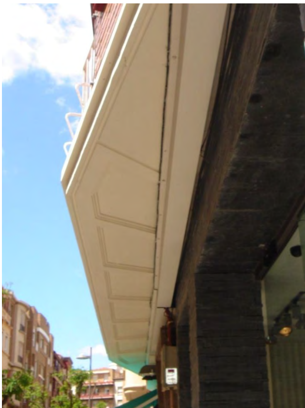
Lám. 182. Edificio de viviendas, c/ García Morato 4, detalle de sofito inferior, Logroño, J. Carceller. 1954
