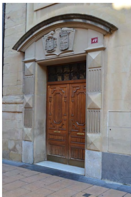
Lám. 381. Edificio de viviendas y Casa Parroquial, c/ Portales 14, detalle de fachada, portal, Logroño, A. del Valle y F. del Valle 1958
