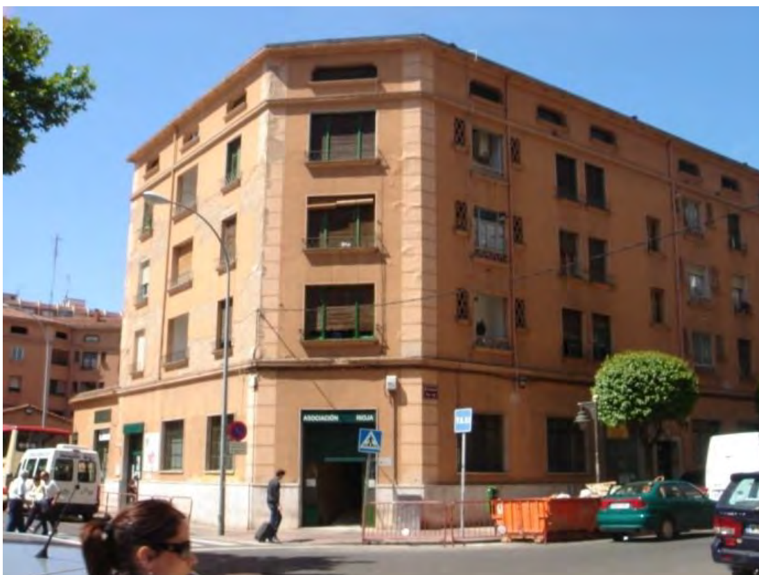
Lám. 111. Edificio de viviendas y Estación de autobuses, A/ España 1 a 11 y A/ Pío XII 2 a 10, Logroño, J. Carceller y Luis González, 1949
