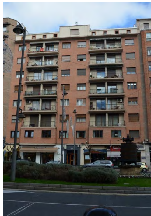
Lám. 262. Edificio de 14 viviendas, a/ Jorge Vigón 9, Logroño, L. González, 1956
