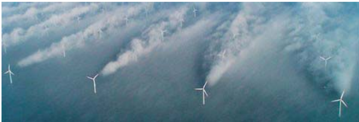
Figura 1.4: El efecto estela se hace visible en parques eólicos off-shore en determinadas condiciones de humedad y temperatura.
