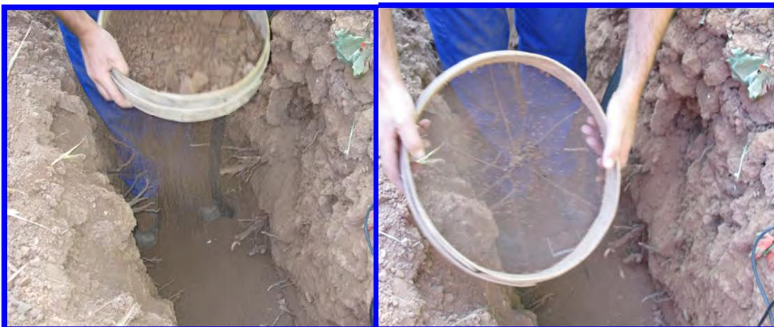
**Figura III.13.** Detalle de la realización de la “cama”, con tierra tamizada (< 2 mm de diámetro), para uno de los sensores.
