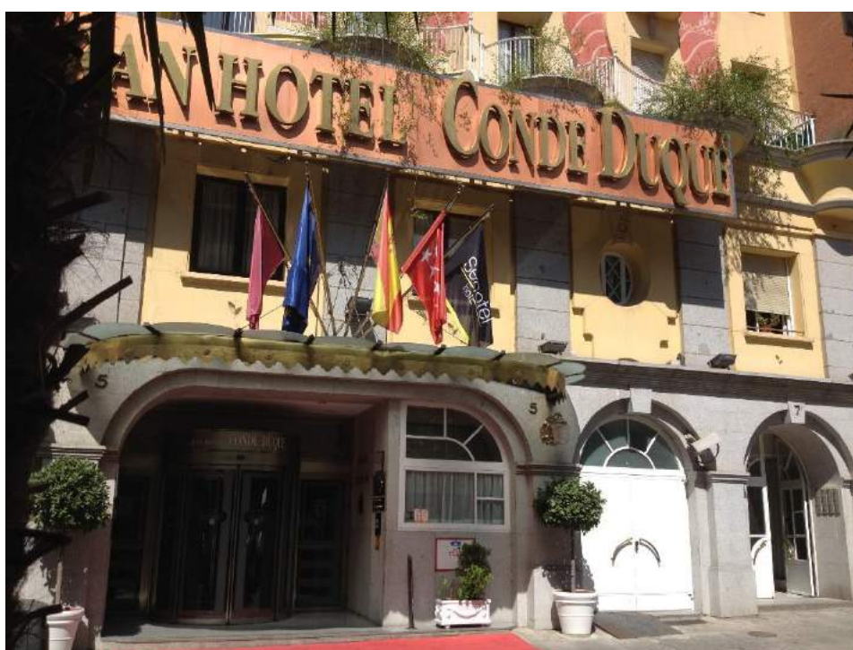
Figura 91: Banderas mal ordenadas en la fachada del Gran Hotel Conde Duque situado en Madrid. 8 de agosto de 2014.
