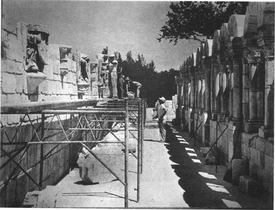
Instalación de grupos escultóricos en la reconstrucción del monasterio
