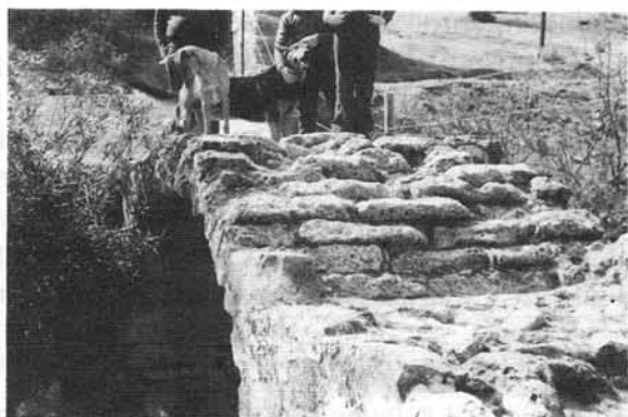
Detalle de las dovelas del arco. (Fotos del autor).
