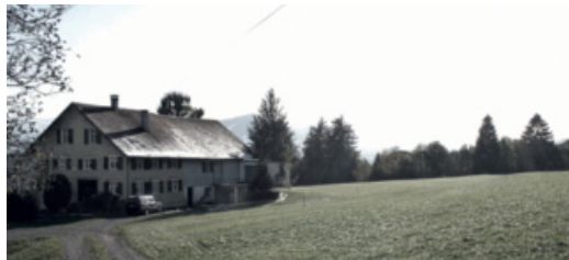
CASA KALTSCHMIEDEN HOUSE KALTSCHMIEDEN Doren, Vorarlberg, Austria, 2014
